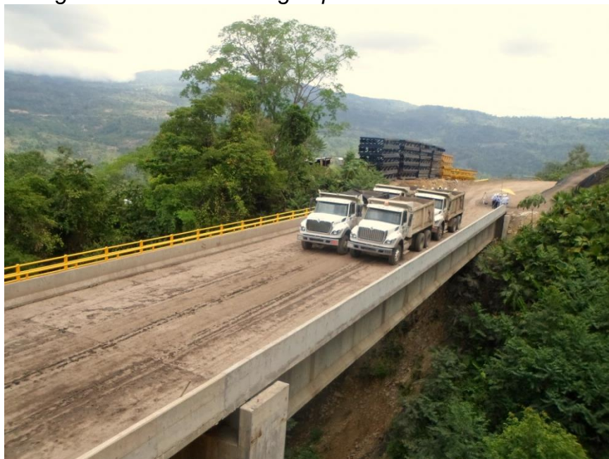
Figura 1. Prueba de Carga aplicada al Puente NNV
