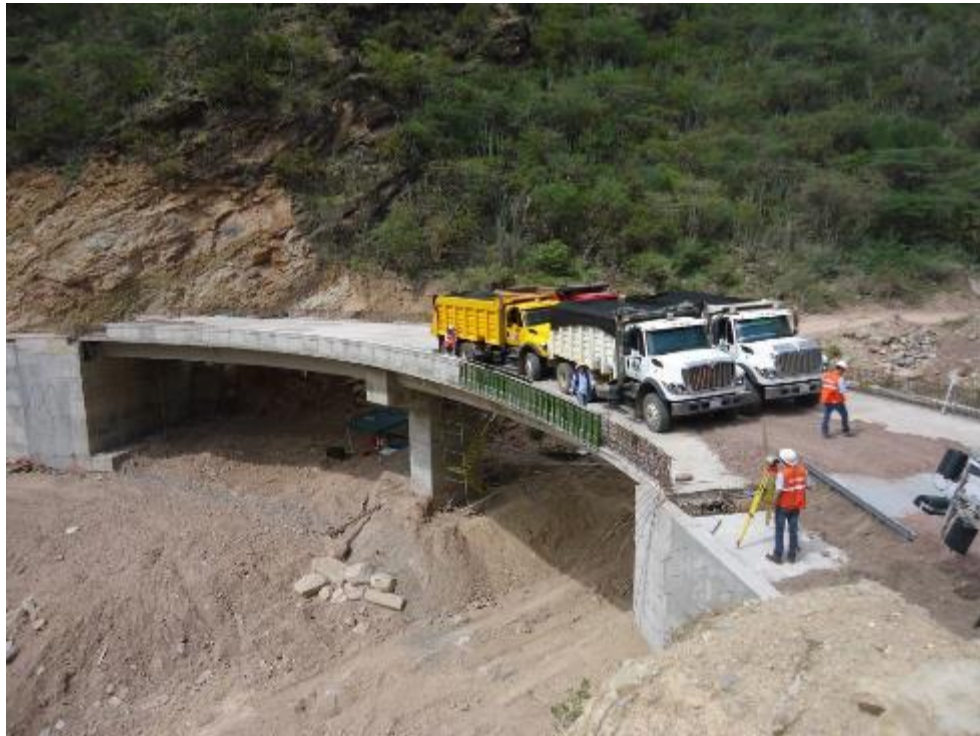
Figura 14. Prueba de Carga entre ejes 2 y 3 Puente Quebrada 1
