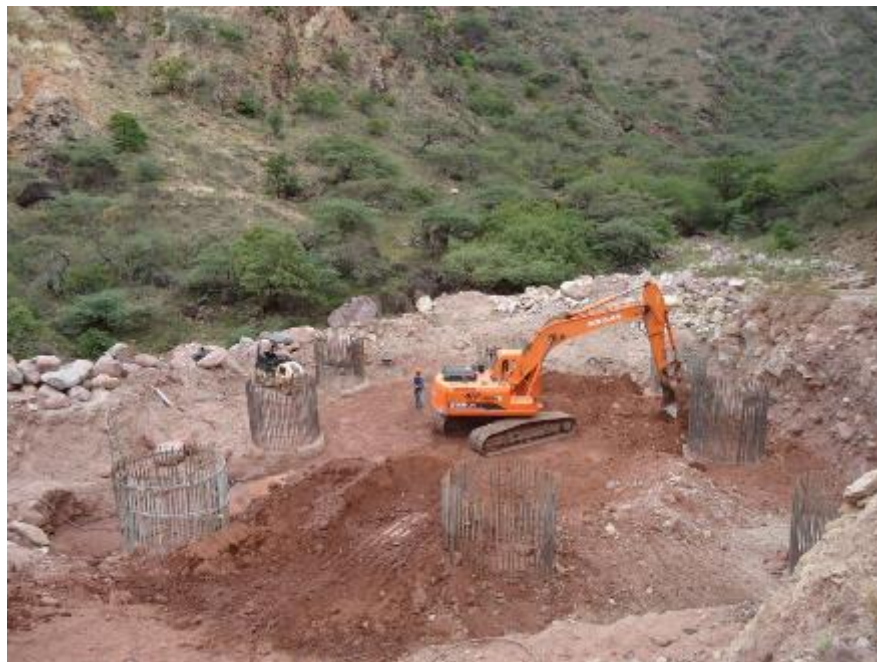
Figura 26. Panorámica de Pilotes del Puente Guillermo Gómez Ortiz
