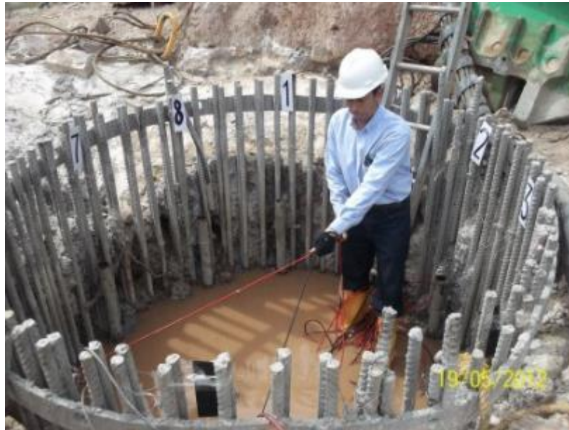
Figura 24. Ejecución de la Prueba Cross-Hole Logging.
