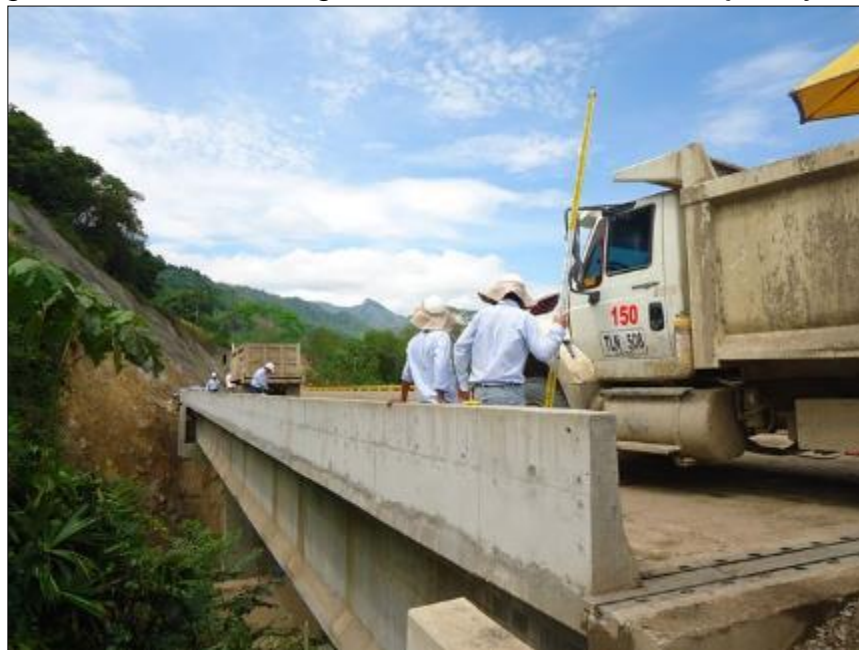
Figura 6. Fase 1 del cargue del Puente NNV, entre Ejes 1 y 2
