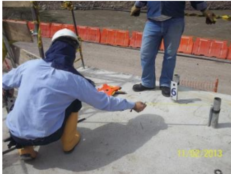
Figura 28. Toma de mediciones entre los tubos en la superficie del pilote
