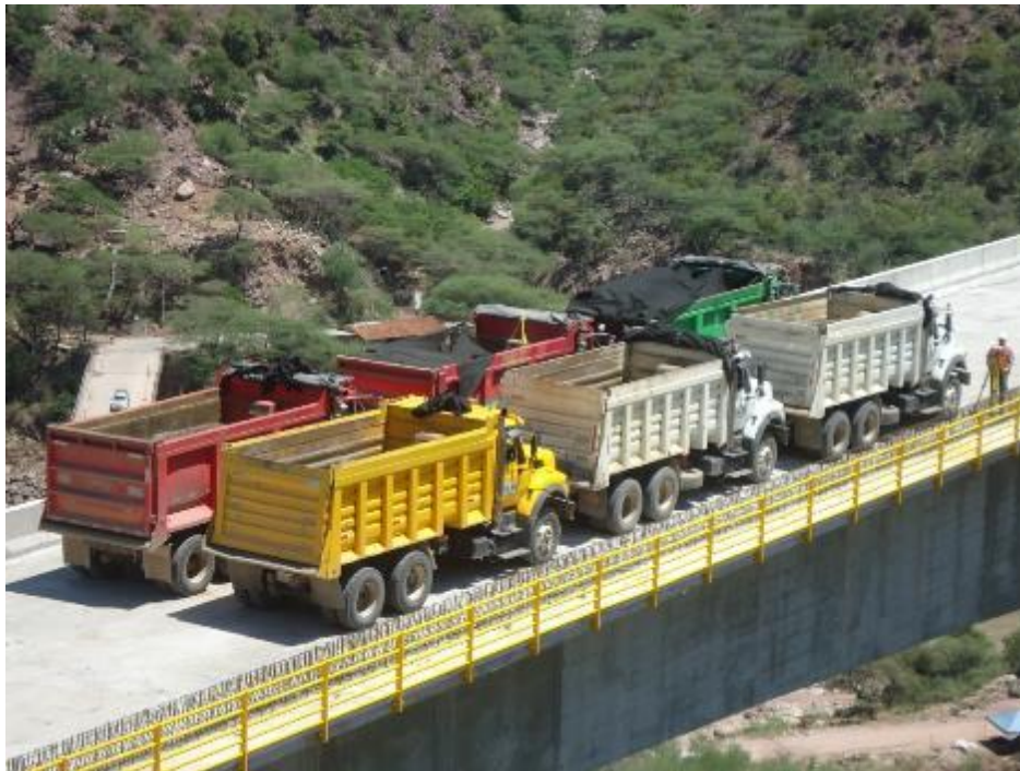
Figura 11. Tren de Carga de la Prueba de Carga, Puente Gómez Ortiz
