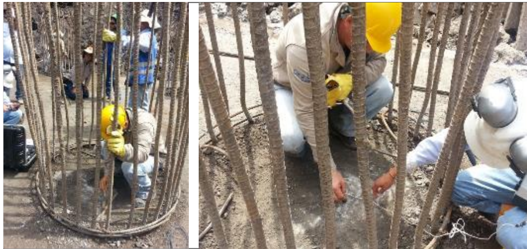
Figura 22. Colocación del sensor para detectar las ondas de la PIT.
