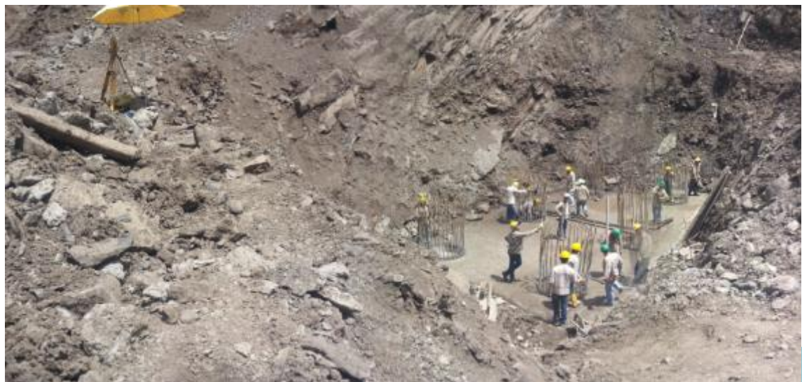
Figura 21. Instalación del equipo de topografía, PIT.
