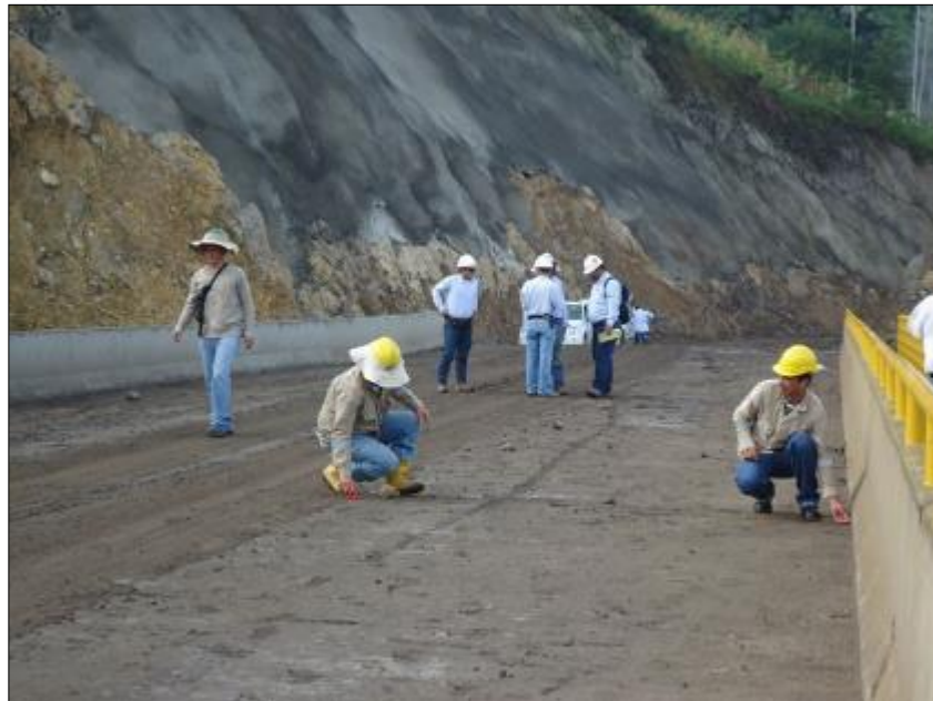
Figura 4. Inspección preliminar realizada al Puente NNV
