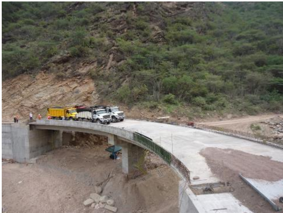
Figura 13. Prueba de Carga entre ejes 1 y 2 Puente Quebrada
