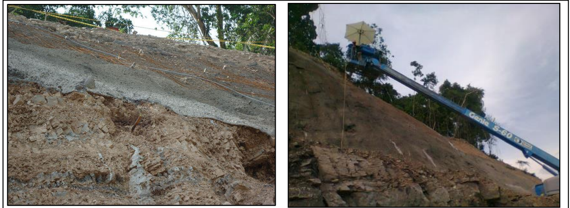
Figura 21. Estabilización de Taludes con concreto lanzado, malla electro soldada y pernos de anclaje, Vía Bucaramanga-San Vicente, Grupo III.
