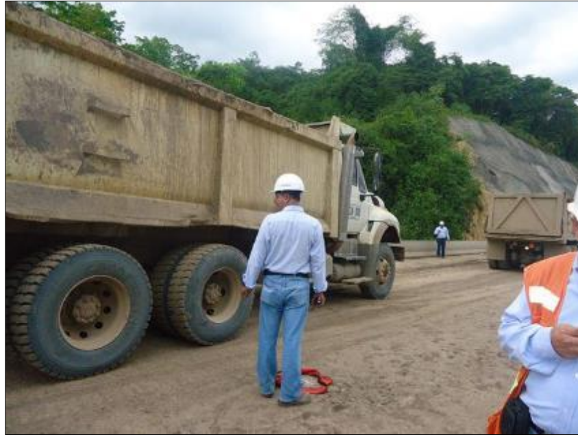
Figura 8. Descargue de la Fase 2 del Puente NNV, entre Ejes 1 y 2
