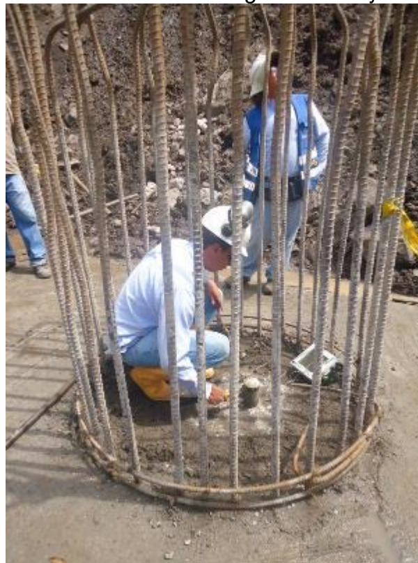
Figura 16. Ejecución de la Prueba de Integridad de Baja Deformación PIT
