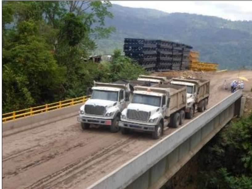
Figura 7. Fase 2 del cargue del Puente NNV, entre Ejes 1 y 2
