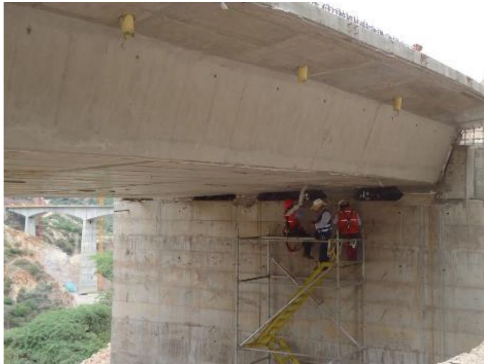
Figura 15. Toma de mediciones de temperatura y deformación en neoprenos, Prueba de Carga Puente Quebrada 1
