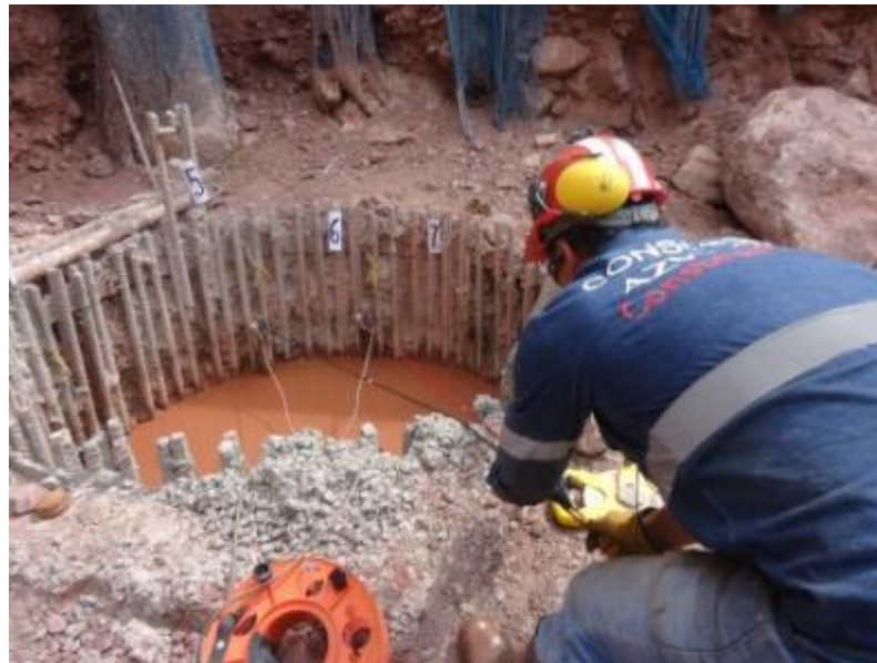
Figura 29. Izaje de sondas, Prueba Cross-Hole Logging
