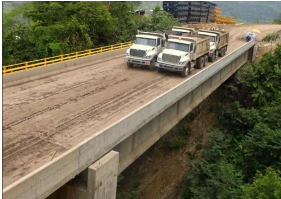
Figura 23. Prueba de Carga Estática, Puente NNV, Vía Bucaramanga-San Vicente Grupo III.
