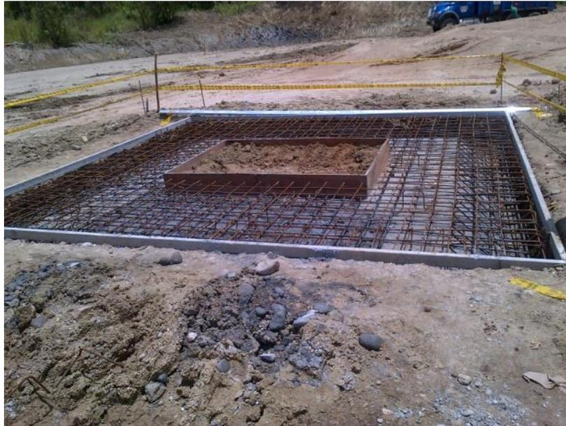
**Figura 31- Acero Refuerzo de Placa Perforación**
