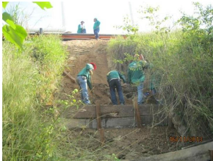
**Figura 27- Construcción Trinchos en Madera Vía Moriche CE**
