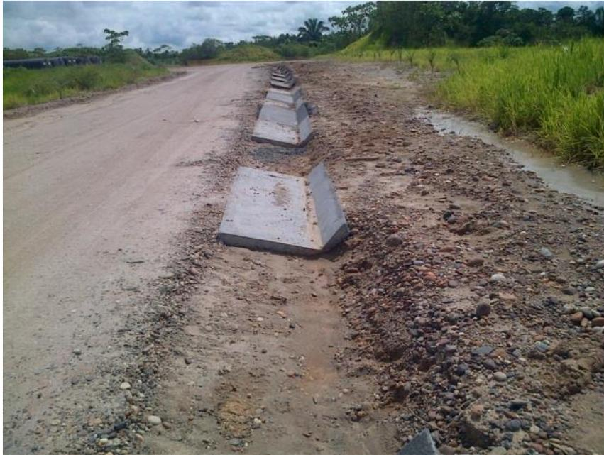
**Figura 26- Cunetas en Concreto Vía Abarco Ph3**
