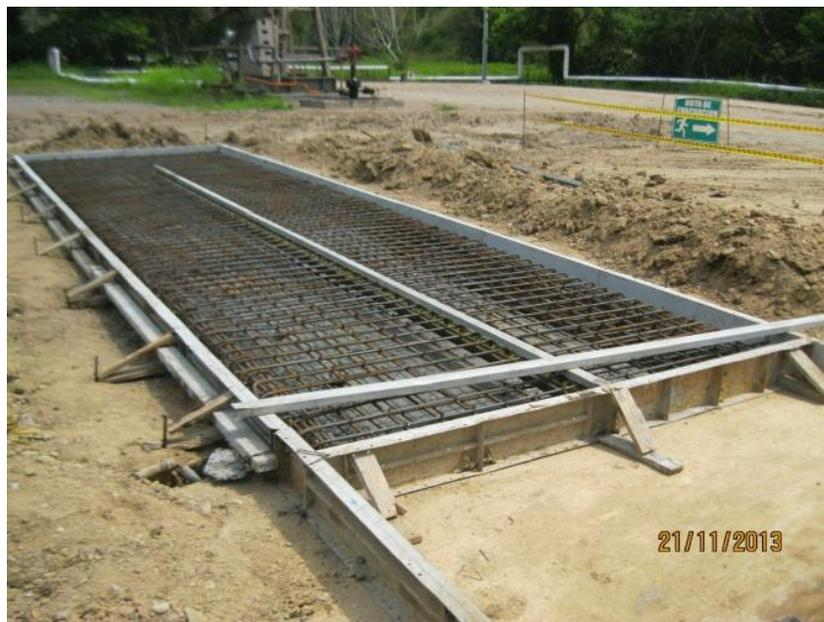
Figura 23- Acero de Refuerzo Placa Unidad de Bombeo, Abarco Ph5
