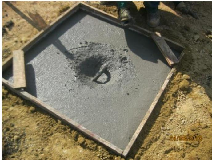
Figura 28- Anclajes, Campo Abarco ph5
