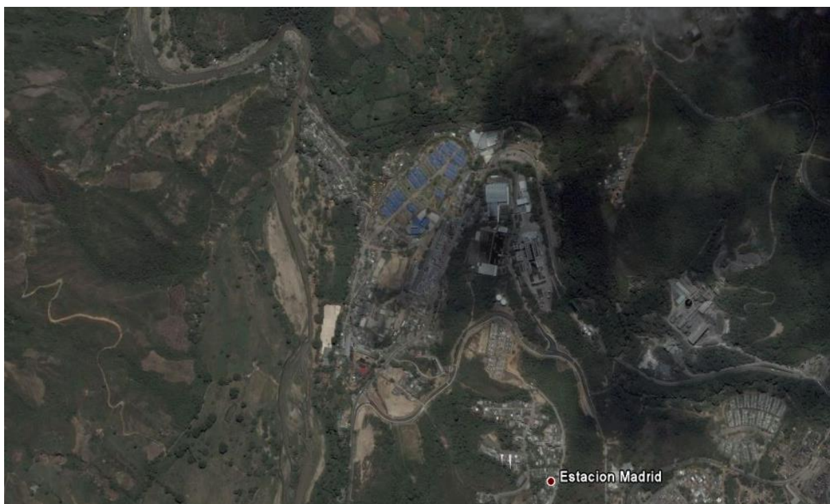
Figura 1. Fotografía satelital que muestra el sector del rio de oro a explotar, así como la infraestructura de acceso.
