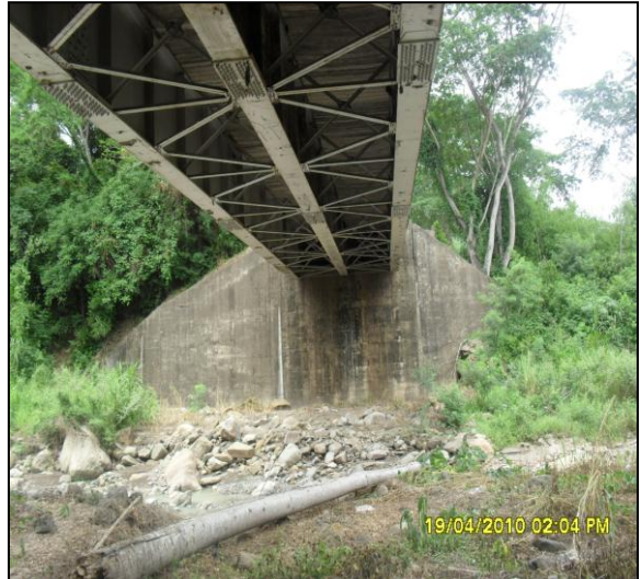
Puente La Putana Tramo 6602 Clasificación de Puentes según su Super- Estructura y Subestructura.
