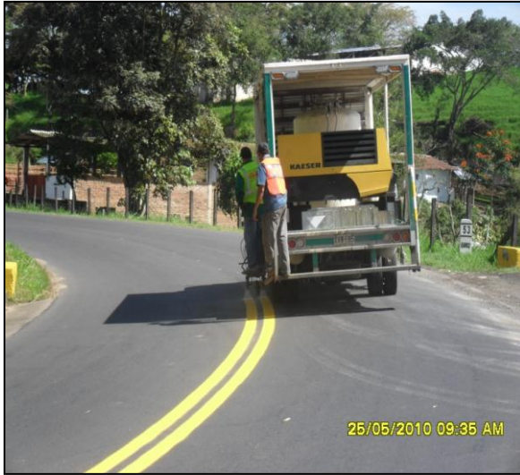
PR 53+000 Tramo 6602. Supervisión de la Demarcación Vial de eje.
