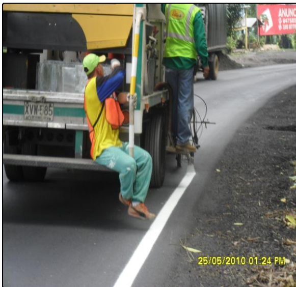
PR 38+500 Tramo 6602. Supervisión de la Demarcación vial de borde
