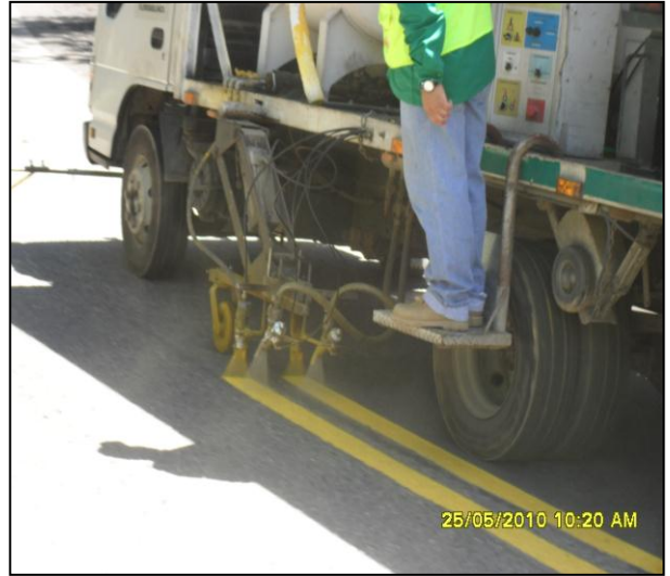
PR 53+000 Tramo 6602. Supervisión de la Demarcación Vial de eje.
