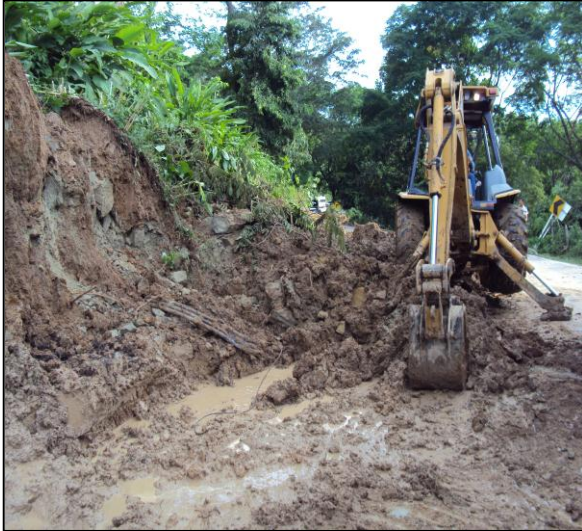
PR 16+500 Tramo 6602 Supervisión de Remoción de Derrumbes.
