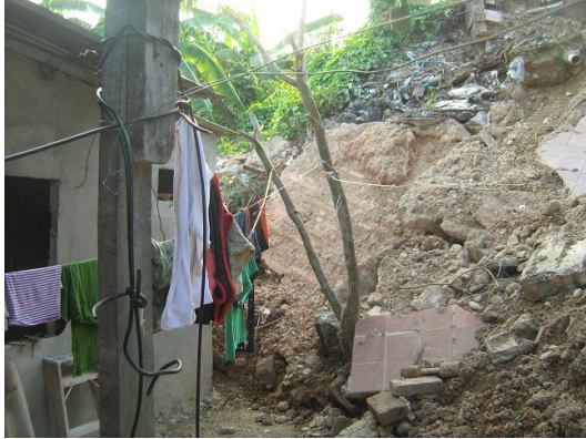
Figura 42. Cercanía de derrumbe al patio
