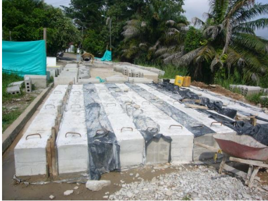
Figura 19. Acopio de pilotes y sardineles prefabricados
