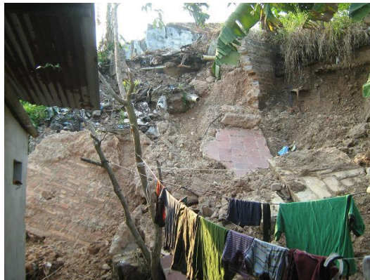
Figura 44. Magnitud del derrumbe
