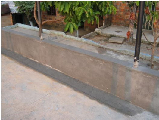
Figura 34. Acabado final de muro de cerramiento
