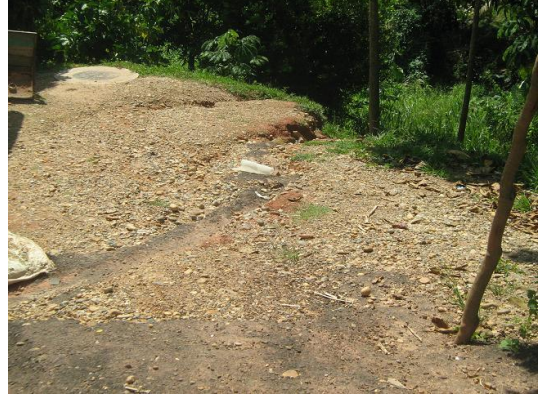
Figura 39. Zona superior de talud
