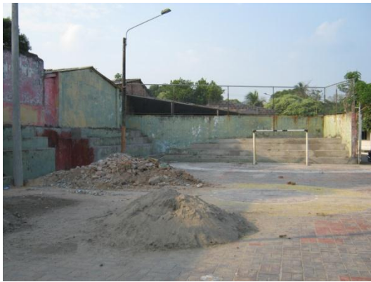
Figura 25. Estado inicial de polideportiva
