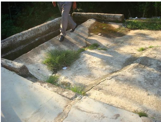
Figura 56. Detalle de estructura de captación de aguas lluvias
