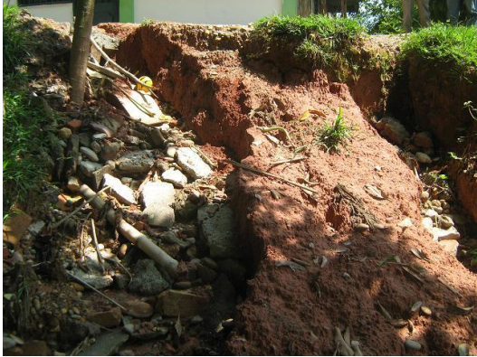
Figura 38. Erosión por acción del agua
