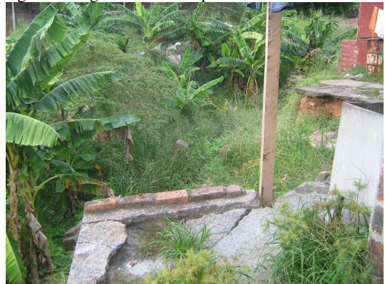
Figura 46. Agrietamiento de pisos
