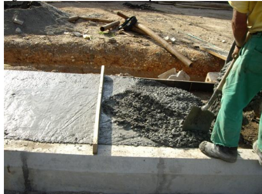
Figura 18. Fundida de andenes peatonales
