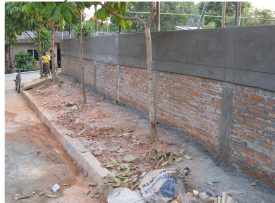
Figura 35. Acabado final posterior muro de cerramiento y de contención
