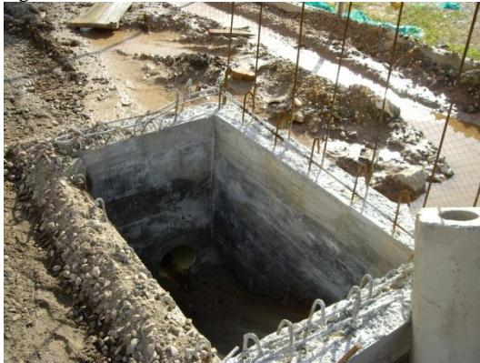
Figura 17. Construcción de sumidero lateral
