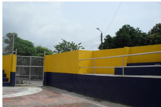
Figura 28. Aplicación de pintura sobre gradas y detalle de barandas
