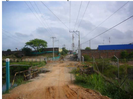
Figura 16. Estado actual de puente vehicular
