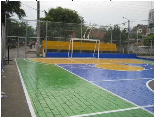
Figura 23. Aplicación de pintura sobre piso
