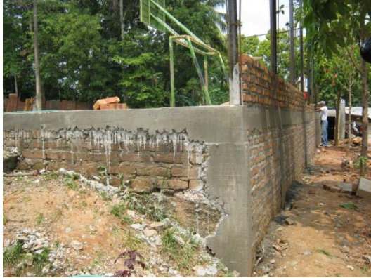
Figura 32. Detalle de anclajes laterales con muros existentes
