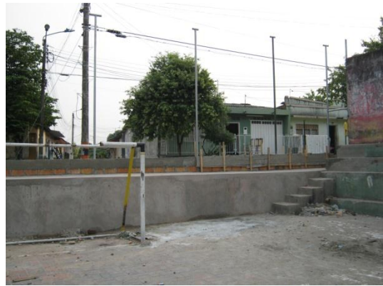
Figura 26. Construcción de muro para soporte de mallas de cerramiento
