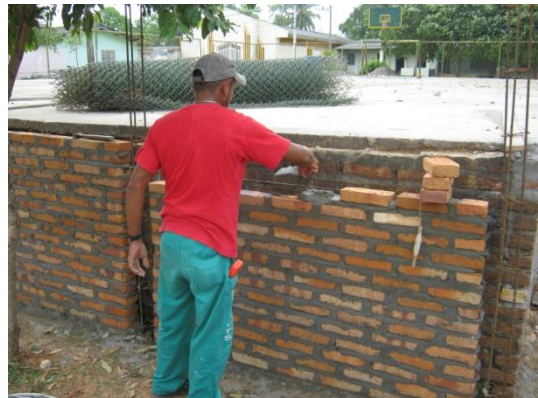
Figura 31. Alzada de muro hasta cota de placas
