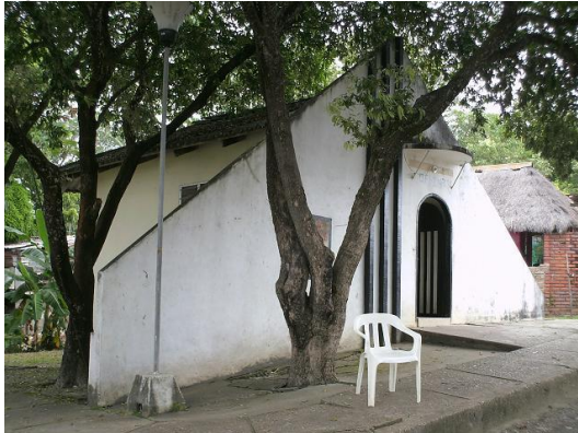
Figura 6. Oficina de celaduría
