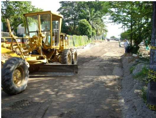
Figura 15. Extendido de material granular de base
