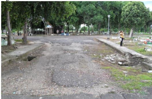
Figura 8. Estado de las vías de acceso
