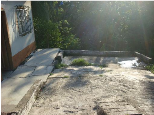
Figura 53. Talud ubicado al final de vía
