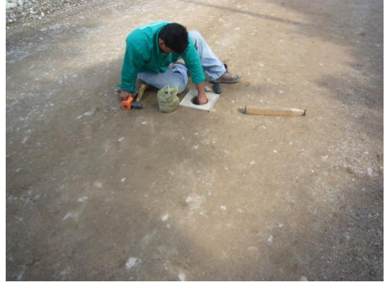
Figura 20. Prueba de densidad de campo
