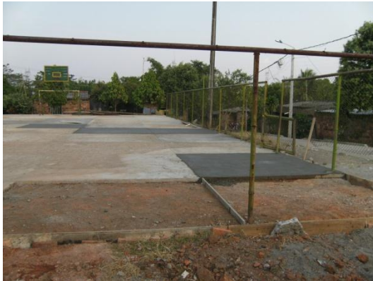
Figura 36. Instalación de malla de cerramiento
