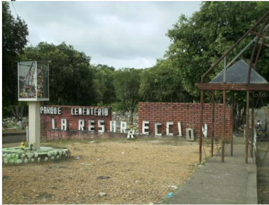
Figura 3. Estado de fachada
