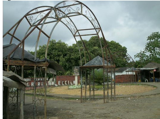
Figura 4. Estructuras a desmontar
