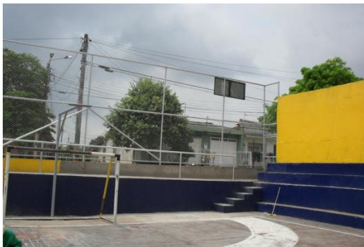
Figura 27. Instalación de malla de cerramiento
