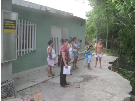
Figura 51. Peligros por avance de erosión
