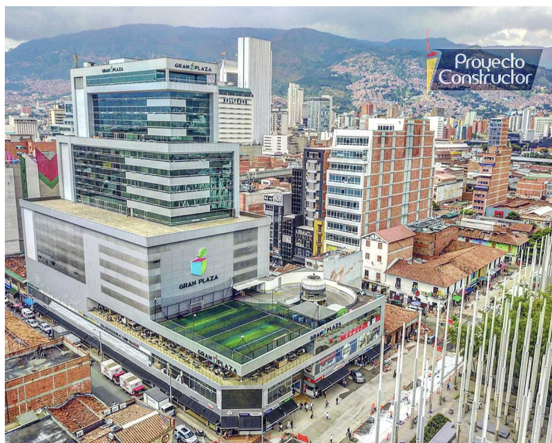
Figura 5. Fachada con la identidad visual del centro comercial Gran Plaza. Fuente: https://elmejorlocal.com.co/propiedad/local-comercial-ubicado-en-c-c-gran-plaza-grplz-005/ (20-05-2021).
