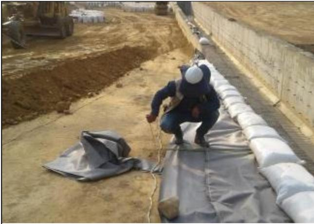
Instalación de geotextil no tejido en contacto con los sacos.
