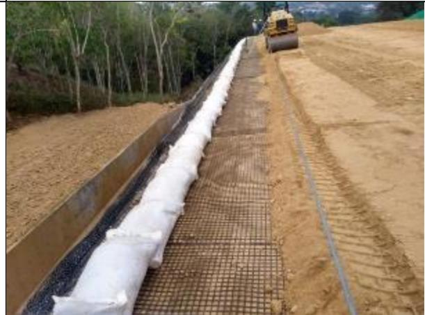
Instalación de la primera y segunda fila de sacos rellenos de material para la configuración de la fachada.
