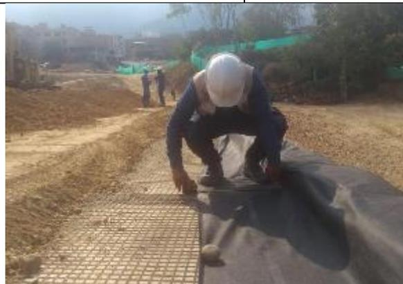
Por último, se realiza la extendida de la segunda capa de material de relleno en un espesor de 25 cm y cierre de la geomalla y geotextil.
