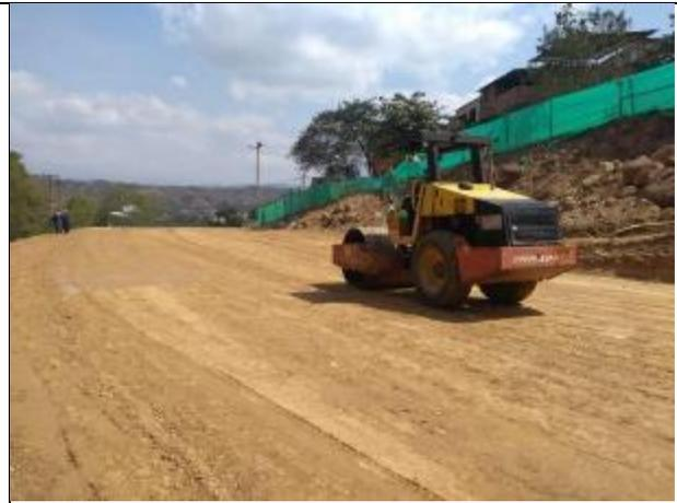
Compacción de capa por medio de vibro-compactador acorde a la humedad y densidad óptima de compactación.
