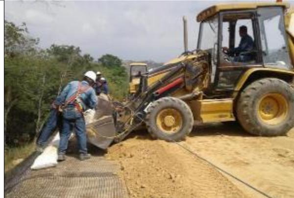
Instalación de la tercera y cuarta fila de sacos rellenos para la conformación de la fachada.
