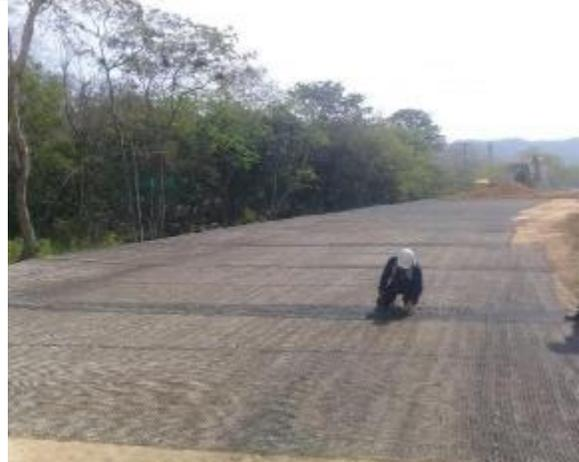
Instalación y anclaje de geomalla de refuerzo.
