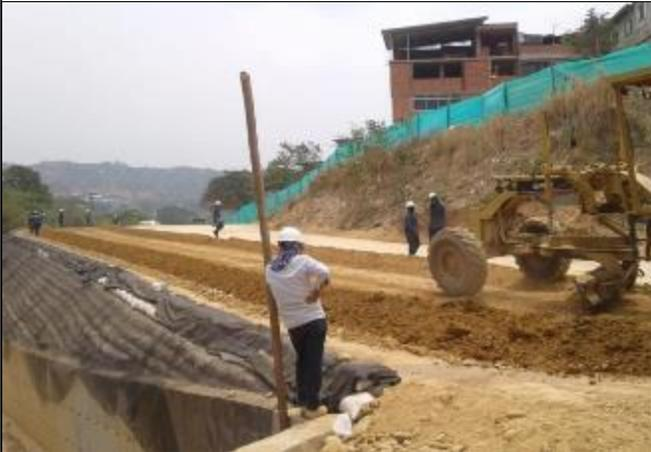
Extendida de la primera capa de material, espesor 25 cm
