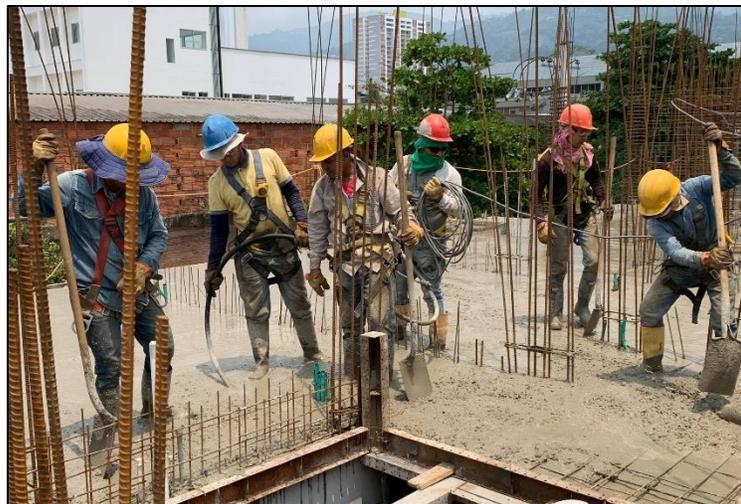
Figura 10. Fundida concreto placa.
