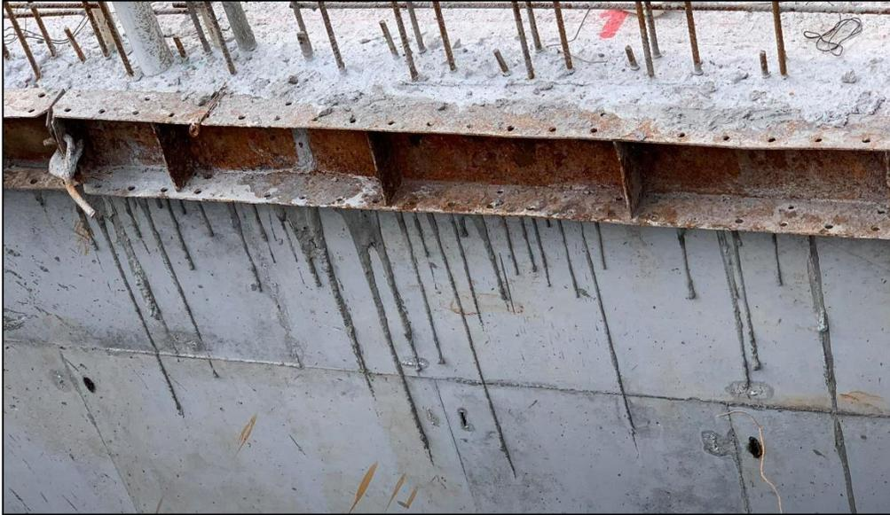
Figura 12. Filtración de concreto por las formaletas.
