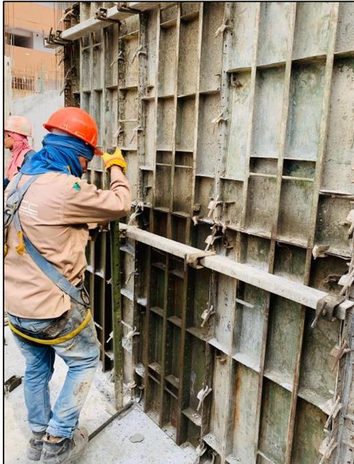
Figura 11. Desencofrado de pantallas.
