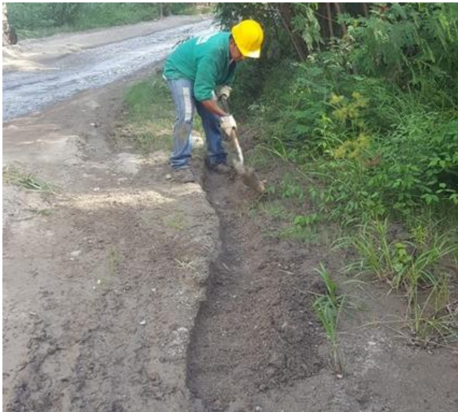
Imagen 8. Adecuación de zanjas para aguas lluvias y sobrante del lavado de arena
