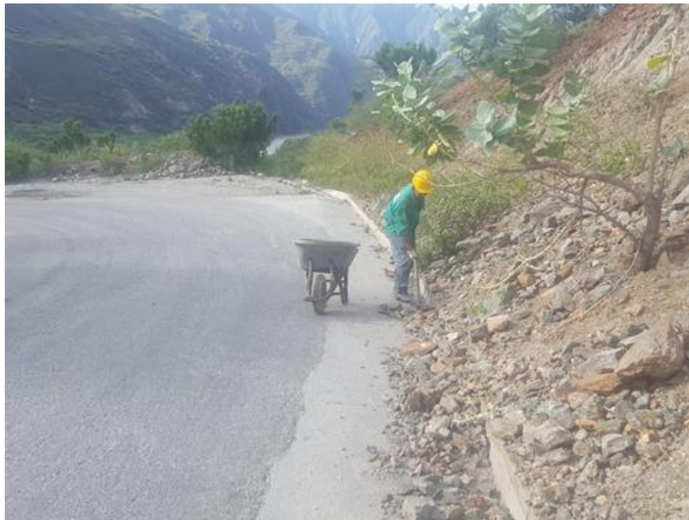
Imagen 5. Limpieza via de acceso
