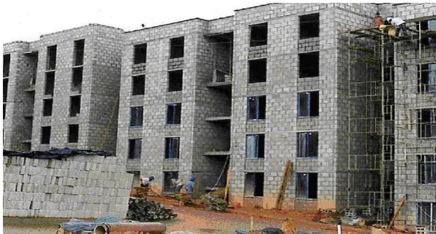
Figura 3: edificio multifamiliar en mampostería reforzada
