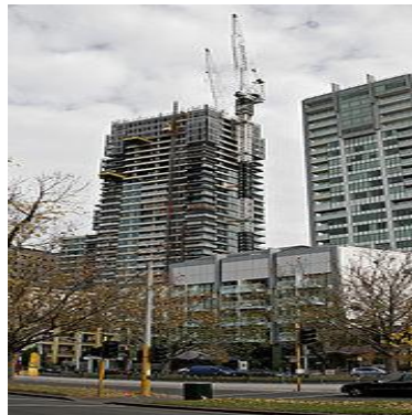
Figura 1. Edificio en construcción en Melbourne
