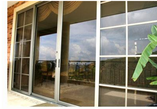
Figura 16. Ventanas de vidrio laminado.
