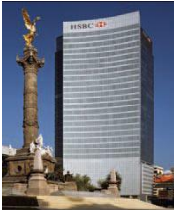
Figura 5. Edificio sostenible HSBC en la Ciudad de México
