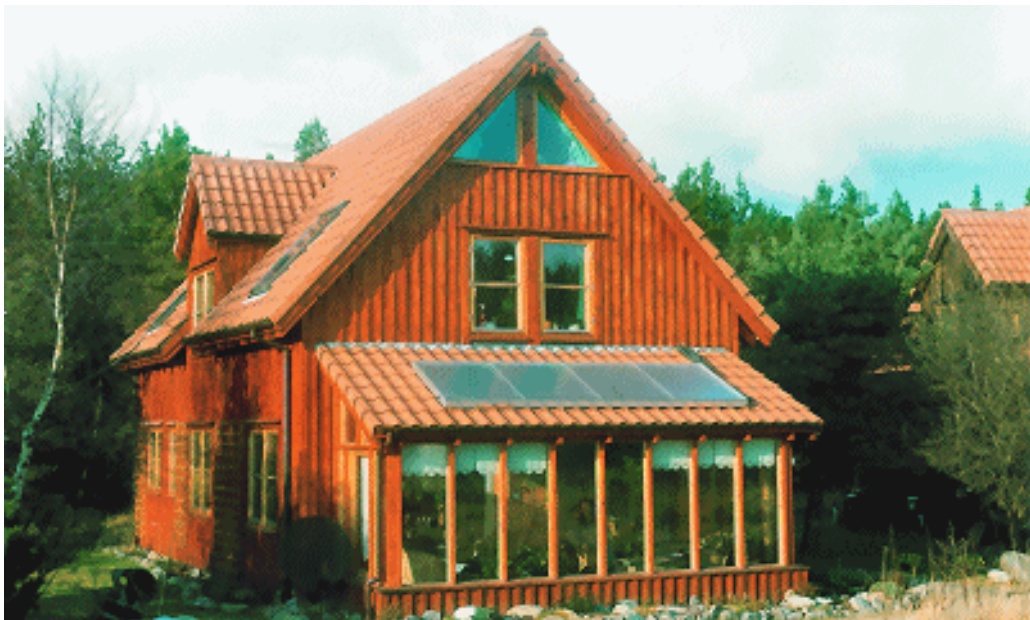
Figura 15. Casa con paneles solares.
