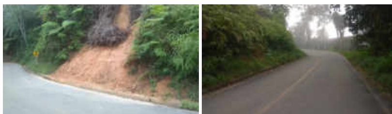
Ilustración 25. K3+300. Talud con pendiente media, material areno arcilloso y humedad media.
