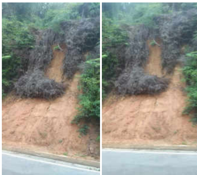
Ilustración 26. K3+300. Zona de ladera arenosa con pendiente media y poca vegetación.
