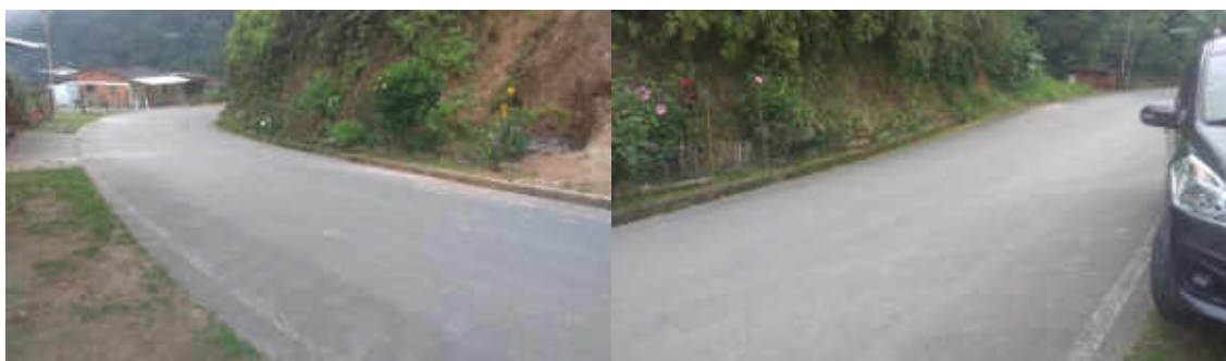
Ilustración 21. K1+900. Vía de inicio a fin sin afectaciones.
