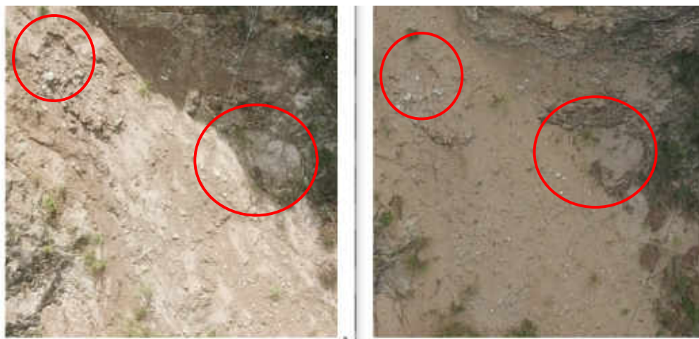
Ilustración 93. Talud 2 Noviembre (izquierda) Enero (derecha) Cuerpo del deslizamiento.
