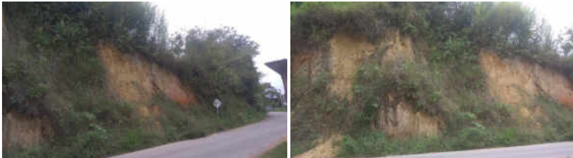
Ilustración 39. K6+000. Presencia de vegetación en parte baja que indica que no ha habido deslizamientos.
