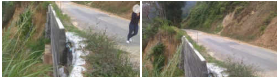
Ilustración 35. K5+000. Muro de contención y muros gaviones de zona ya estabilizada.
