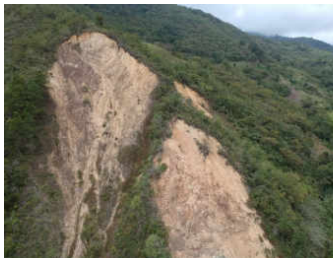
Ilustración 49. K18+500. Fotografía dron de gran deslizamiento en montaña.
