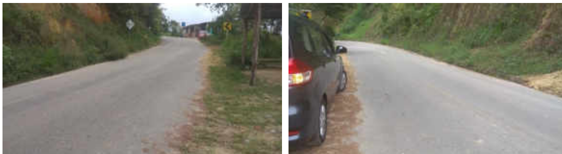
Ilustración 37. K6+000. Inicio y fin de la vía sin afectaciones.
