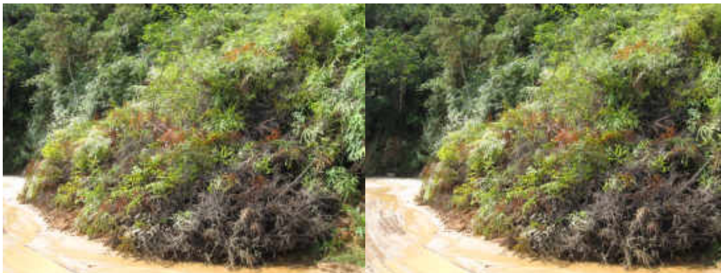
Ilustración 36. K5+000. Antecedentes a deslizamiento del año 2010. (Imagen suministrada Julián Galvis)
