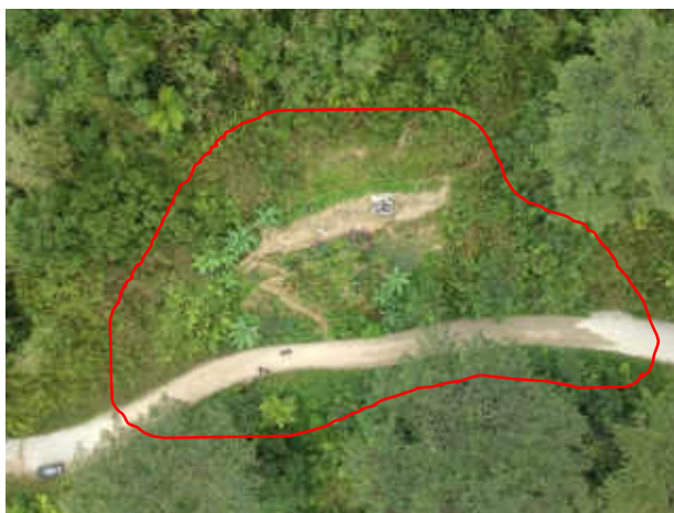
Ilustración 19. K1+200. Imagen de dron a 80 metros de altura. Se denota zona con deslizamiento de inicio a fin.
