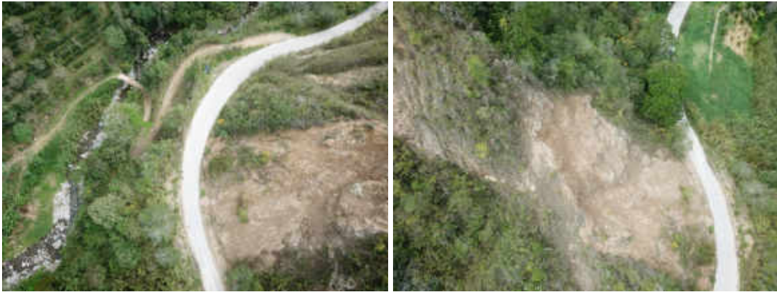
Ilustración 60. Talud 2. Ejemplo de imágenes obtenidas con la ejecución de los planes de vuelo.
