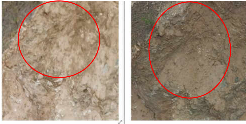
Ilustración 92. Talud 2 Noviembre (izquierda) Enero (Derecha) escarpe principal del deslizamiento.
