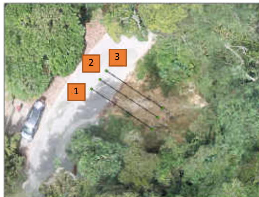
Ilustración 84. Talud 1 Comparación Noviembre-Diciembre. Demarcación perfiles topográficos extraídos
