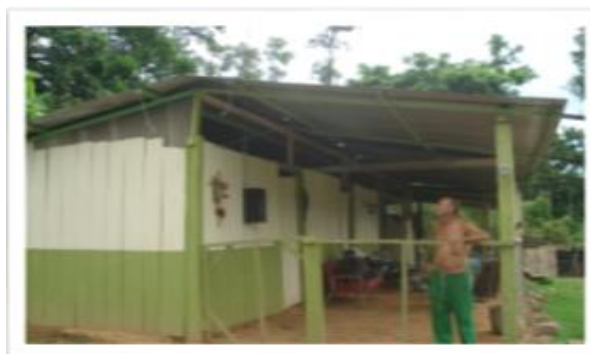
Figura 14. Vivienda del sector 25 de Agosto (1). En la ilustración se observan materiales como la madera y tejas de zinc, también espacios como el corredor que eran aprovechados como sitio de reunión. Adaptado de Archivo fotográfico de ISAGEN, recupera
