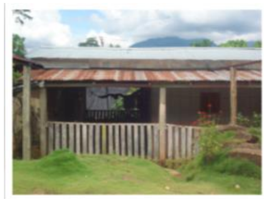
Figura 16. Vivienda del sector 25 de Agosto (3). En la ilustración, se observa un tipo de vivienda que se conoce como “casa elva”, que es una construcción en el techo que permitía realizar las labores de secado del cacao. Adaptado de Archivo fotográfico de ISAGEN, recuperado en el 2017.
