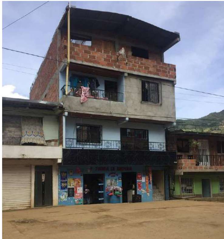
Imagen 15. Construcción de vivienda Sector Regalo de Dios
