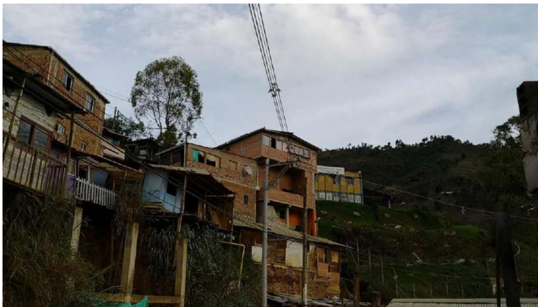
Imagen 11. Construcción de viviendas en Granizal
