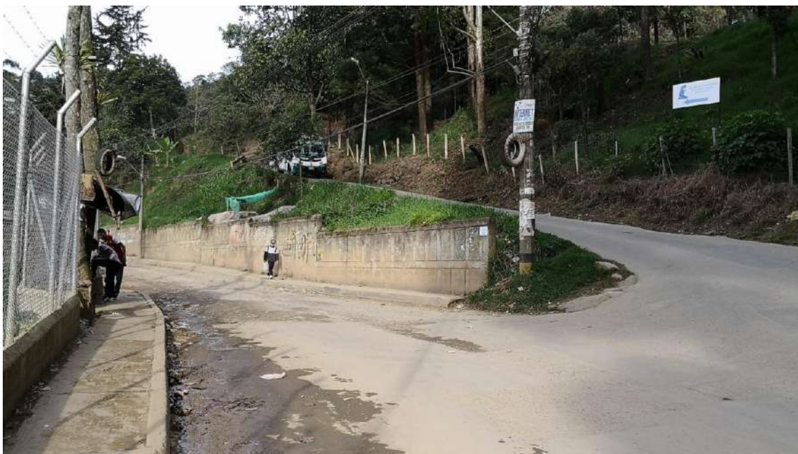
Imagen 13. Vía de acceso a la vereda
