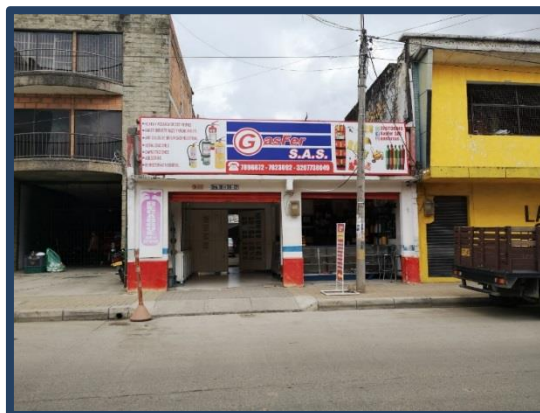
Figura 8. Fachada y área externa Gasfer S.A.S. Fuente: autor.
