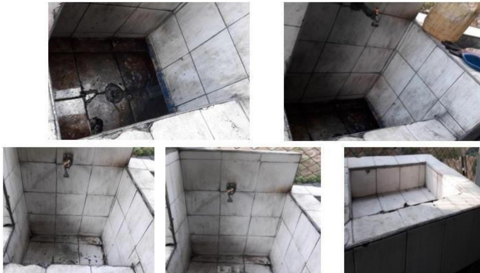
Imagen 23. Limpieza de la pila ubicada en mantenimiento. Fuente: La Autora.
