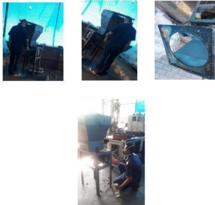
Imagen 24. Evidencia de la limpieza y pintada de la maquina Sika. Fuente: La Autora.
