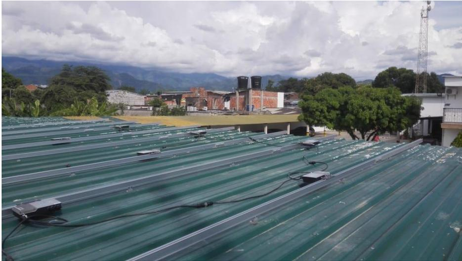
*Figura 60* Microinversores instalados en techo
