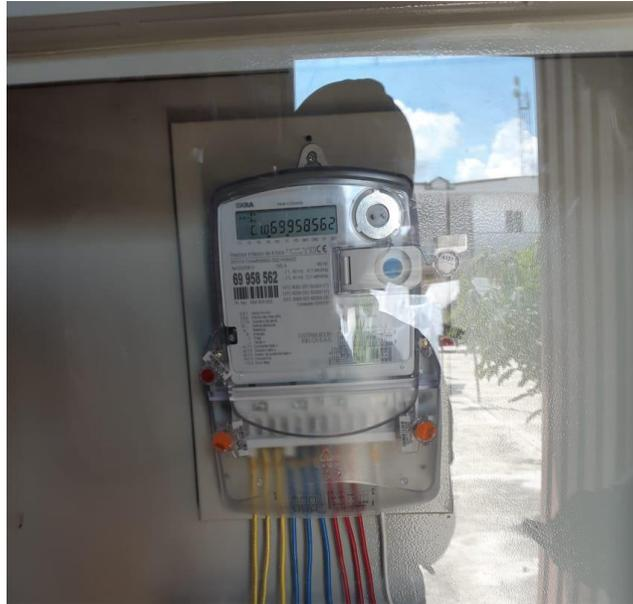
*Figura 49.* Medidor bidireccional iskra
