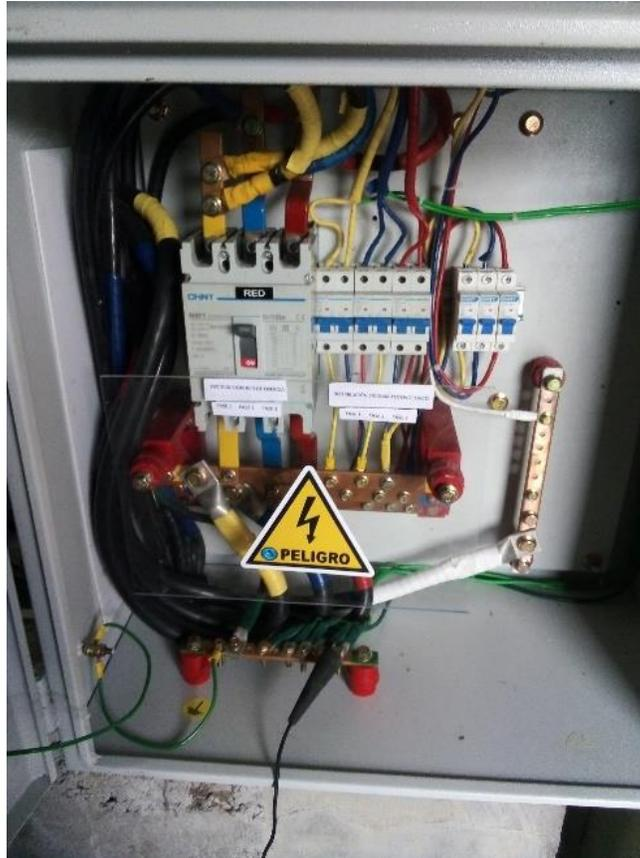
Figura 53 Tablero de sincronización
