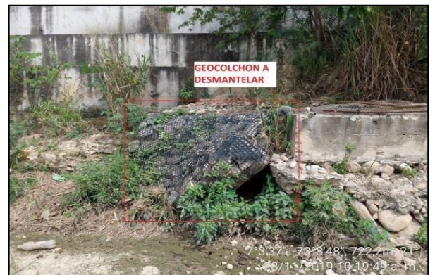
Fotografía N° 43. Estructuras a desmantelar Fuente: Tecnicontrol
