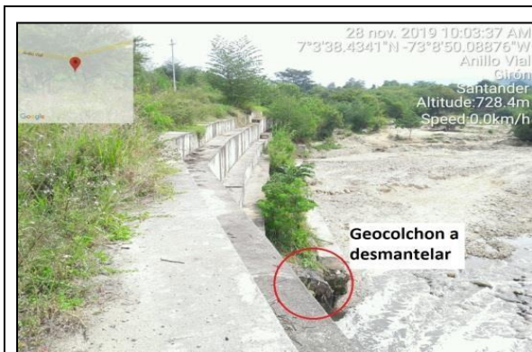
Fotografía N° 44. Estructuras a desmantelar Fuente: Tecnicontrol
