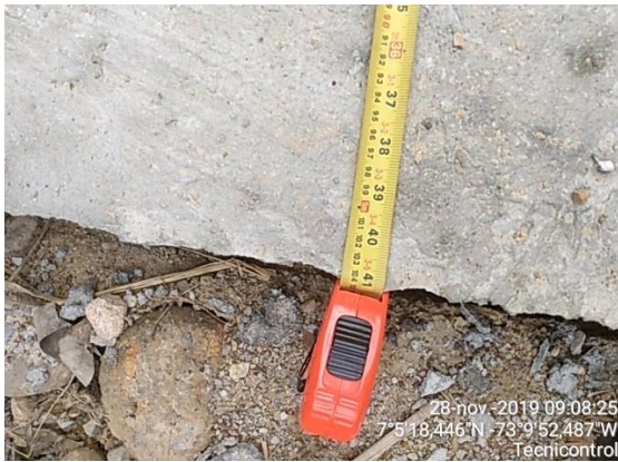
Fotografía N° 50. Verificación dimensiones de las placas Fuente: Technicontrol
