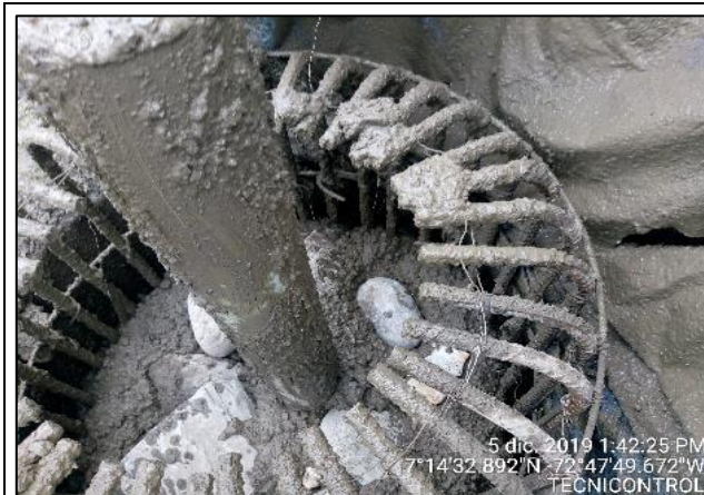
Fotografía N° 15. Fundida del núcleo de caisson en concreto ciclópeo de 3000 psi Fuente. Technicontrol S.A.S
