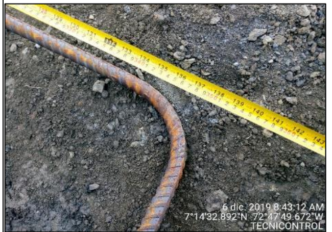
Fotografía N° 26. Verificación de acero para el núcleo de caisson Fuente. Tecnicontrol S.A.S
