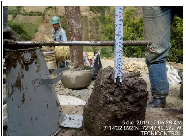
Fotografía N° 22. Toma de muestra asentamiento de concreto Fuente. Tecnicontrol S.A.S
