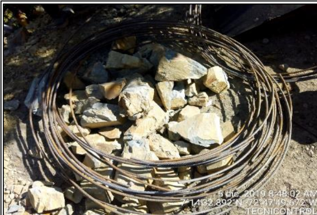
Fotografía N° 27. Verificación de acero para el núcleo de caisson Fuente. Tecnicontrol S.A.S
