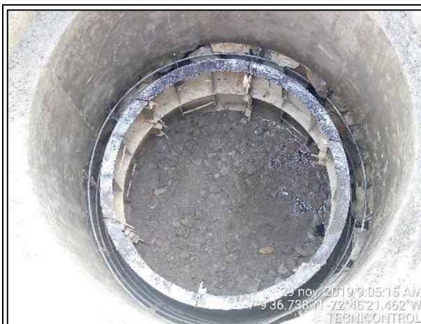
Fotografía N° 05. Amarre de acero y armado de formaleta para fundir anillo de protección en el caisson Fuente. Tecnicontrol S.A.S
