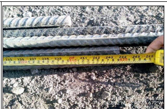
Fotografía N° 24. Verificación de acero para el núcleo de caisson Fuente. Tecnicontrol S.A.S
