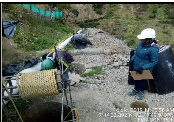
Fotografía Nº 31. Aseguramiento de trabajo en espacios confinados de los caissons, por medio de la medición de atmósferas
