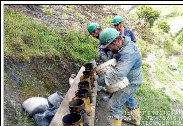
Fotografía N° 17. Toma de ocho (8) muestras de cilindros para ser fallados a la compresión Fuente. Tecnicontrol S.A.S
