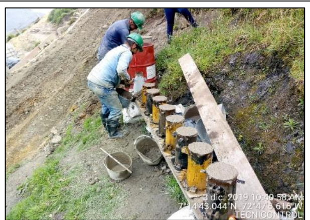
Fotografía N° 18. Toma de ocho (8) muestras de cilindros para ser fallados a la compresión Fuente. Tecnicontrol S.A.S
