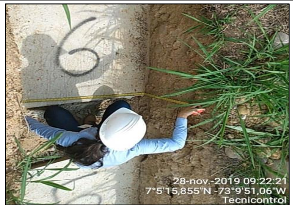
Fotografía N° 49. Verificación dimensiones de las placas Fuente: Tecnicontrol
