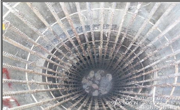
Fotografía N° 13. Fundida del núcleo de caisson en concreto ciclópeo de 3000 psi Fuente. Technicontrol S.A.S
