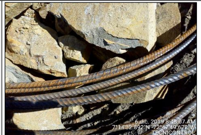
Fotografía N° 28. Verificación de acero para el núcleo de caisson Fuente. Tecnicontrol S.A.S
