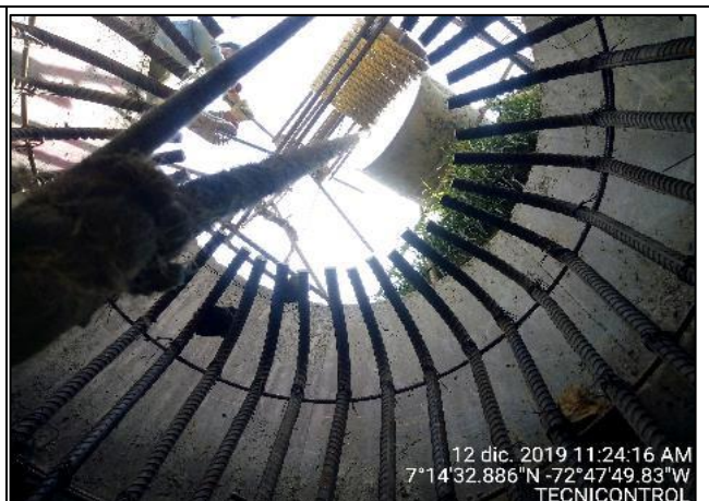
Fotografía N° 10. Verificación amarre de acero para el núcleo del caisson Fuente. Tecnicontrol S.A.S
