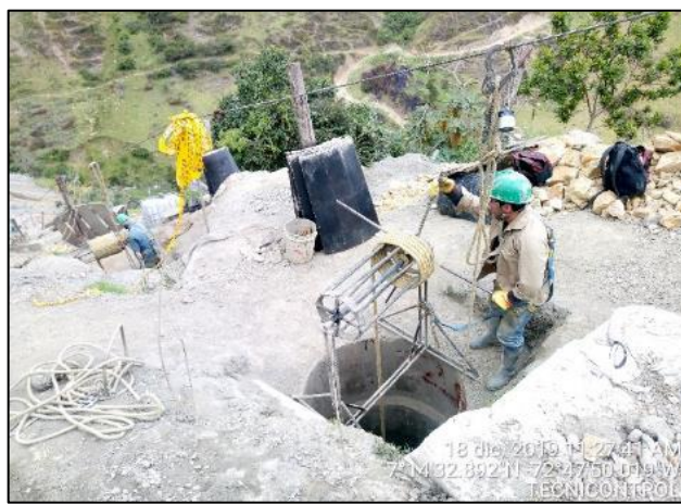
Fotografía N° 03. Molinete para extracción de material de excavación Fuente. Tecnicontrol S.A.S
