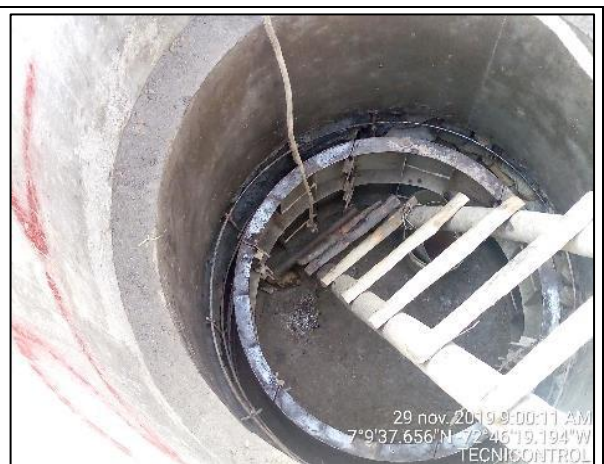
Fotografía N° 06. Amarre de acero y armado de formaleta para fundir anillo de protección en el caisson Fuente. Tecnicontrol S.A.S
