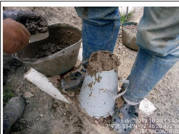
Fotografía N° 21. Toma de muestra asentamiento de concreto Fuente. Tecnicontrol S.A.S
