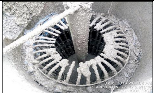
Fotografía N° 14. Fundida del núcleo de caisson en concreto ciclópeo de 3000 psi Fuente. Technicontrol S.A.S
