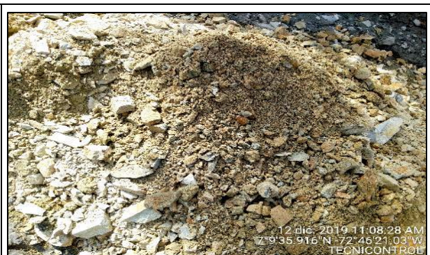
Fotografía N° 02. Material proveniente de excavación para anillos de protección Fuente. Tecnicontrol S.A.S
