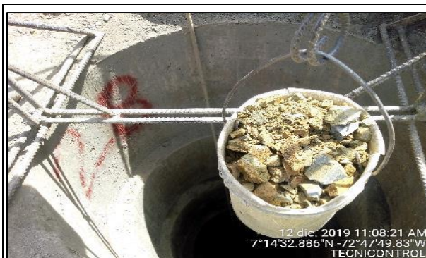
Fotografía N° 01. Material proveniente de excavación para anillos de protección Fuente. Tecnicontrol S.A.S
