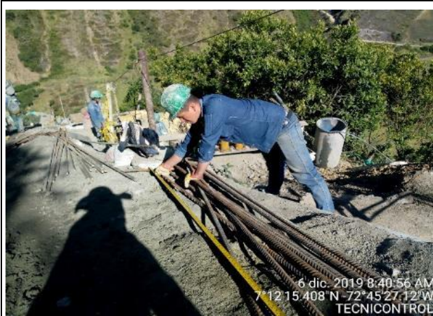
Fotografía N° 25. Verificación de acero para el núcleo de caisson Fuente. Tecnicontrol S.A.S
