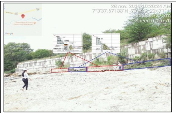
Fotografía N° 47. Distribución Hexápodos Fuente: Tecnicontrol
