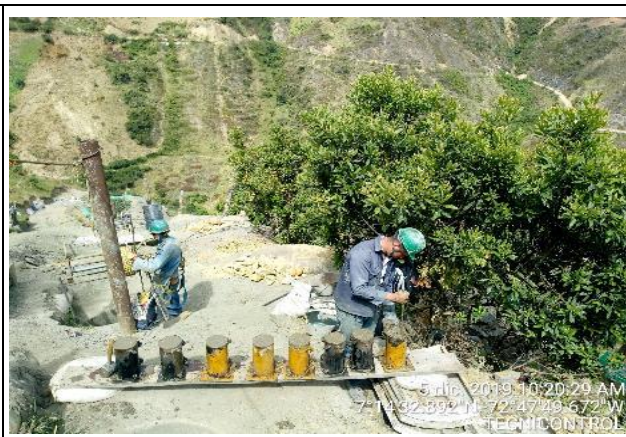
Fotografía N° 20. Toma de ocho (8) muestras de cilindros para ser fallados a la compresión Fuente. Tecnicontrol S.A.S
