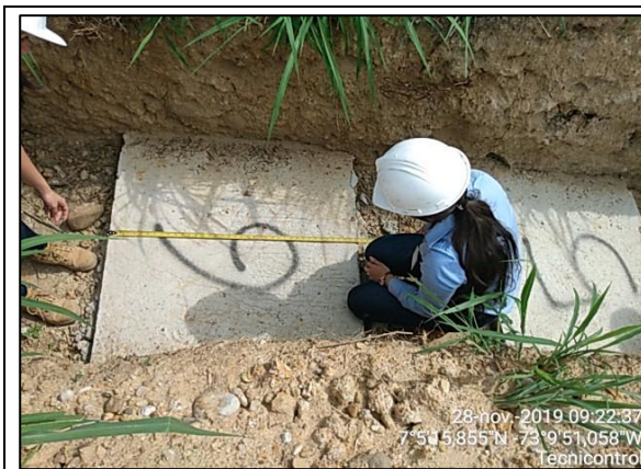
Fotografía N° 48. Verificación dimensiones de las placas Fuente: Tecnicontrol
