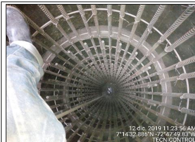
Fotografía N° 09. Verificación amarre de acero para el núcleo del caisson Fuente. Tecnicontrol S.A.S
