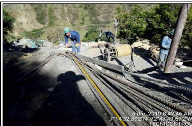
Fotografía N° 23. Verificación de acero para el núcleo de caisson Fuente. Tecnicontrol S.A.S
