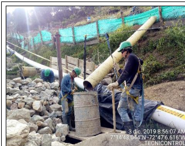
Fotografía N° 11. Fundida del núcleo de caisson en concreto ciclópeo de 3000 psi Fuente. Tecnicontrol S.A.S
