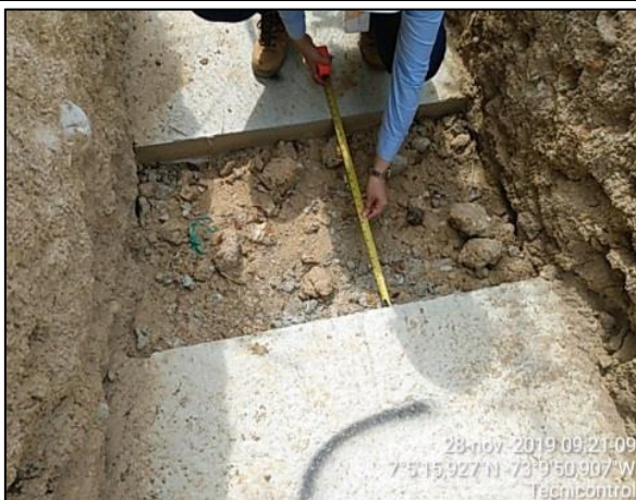
Fotografía N° 52. Verificación distancia entre placas Fuente: Technicontrol
