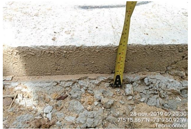
Fotografía N° 51. Verificación dimensiones de las placas Fuente: Technicontrol
