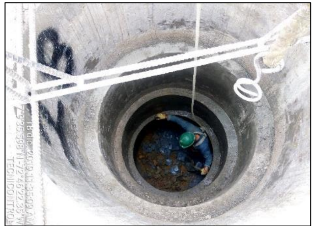
Fotografía N° 04. Verificación de material para anillo de protección caisson Fuente. Tecnicontrol S.A.S
