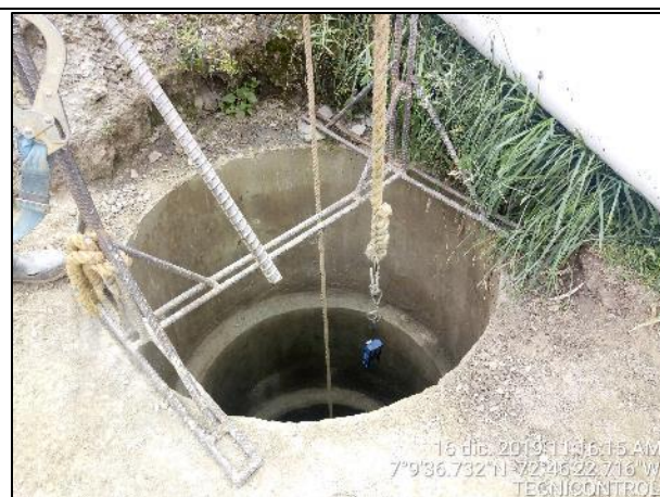
Fotografía Nº 30. Aseguramiento de trabajo en espacios confinados de los caissons, por medio de la medición de atmósferas
