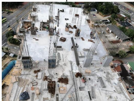
Imagen 3. Seguimiento fundida de columnas piso 19 -20.
