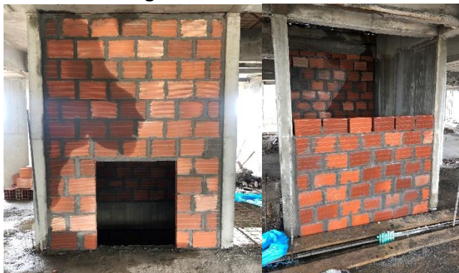
Fuente: foto tomada durante la construcción del shut
