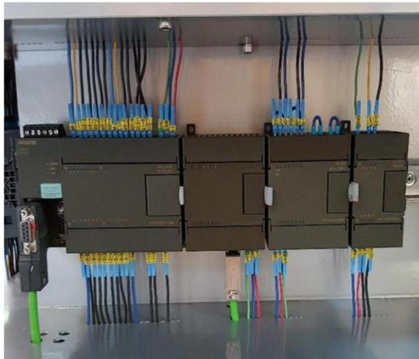
Los sensores e indicadores de luz son alimentados por la fuente 1 desde el cable amarillo, separado de las electroválvulas que se alimentan desde la fuente 2 por el cable rojo. Esto es debido a que las electroválvulas en su interior traen una bobina
