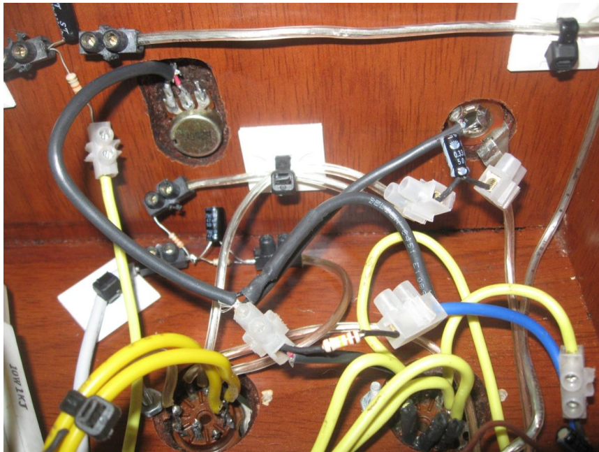
Fig. 56 Construcción del amplificador Fuente: Autor
