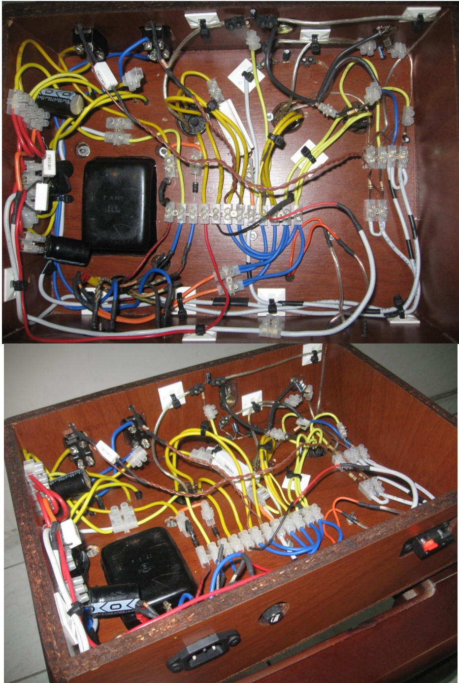
Fig. 58 Construcción del amplificador Fuente: Autor
