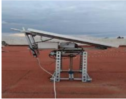
Figura 8. Montaje seguidor solar. Fuente. [17]
