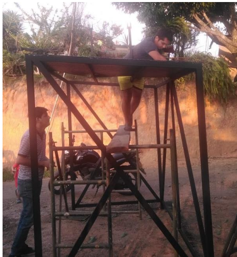
Figura 59. Techado y aislamiento térmico. Fuente Autor.
