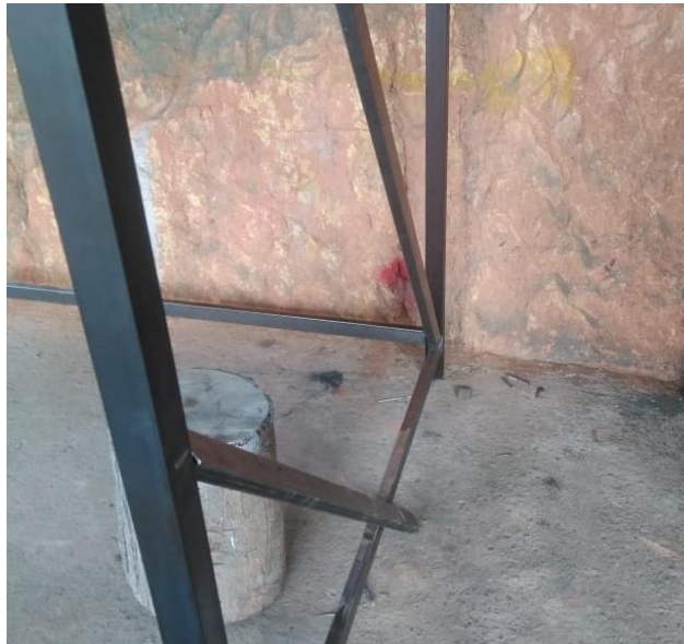
Figura 55. Instalación de soportes diagonales laterales. Fuente Autor.
