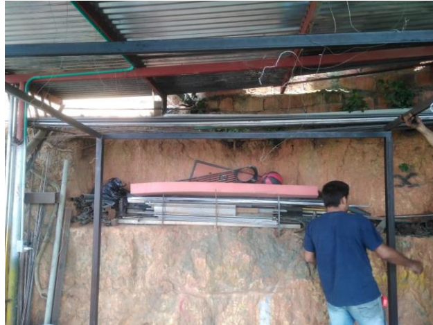
Figura 54. Armado de estructura principal. Fuente Autor.
