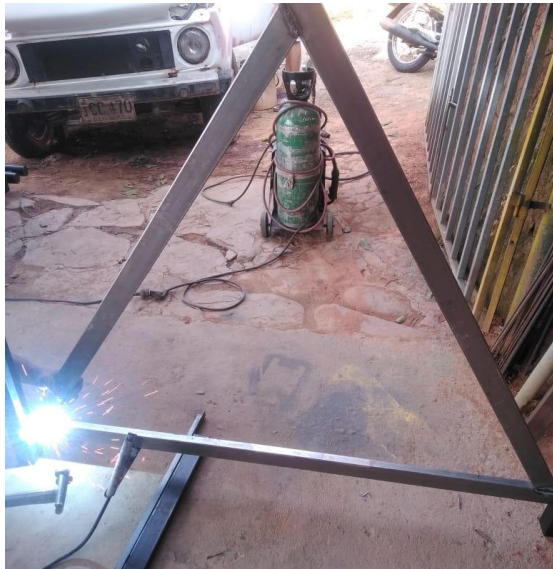
Figura 56. Soldadura aplicada para fijar la estructura. Fuente Autor.
