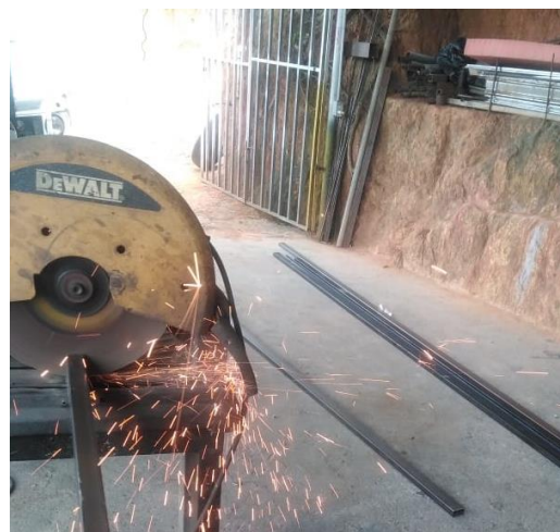
Figura 53. Proceso de corte de los perfiles y tubería de acero. Fuente Autor.
