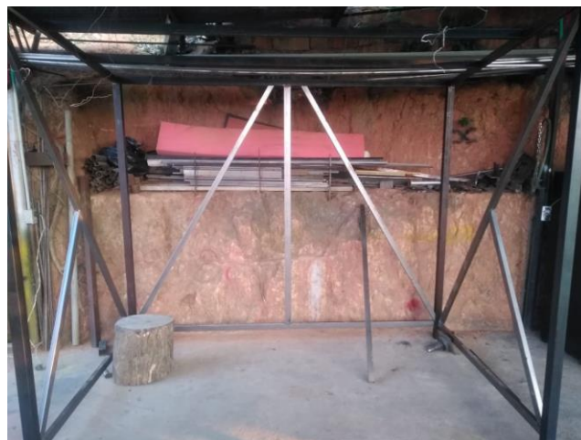
Figura 57. Estructura terminada sin pintar. Fuente Autor.
