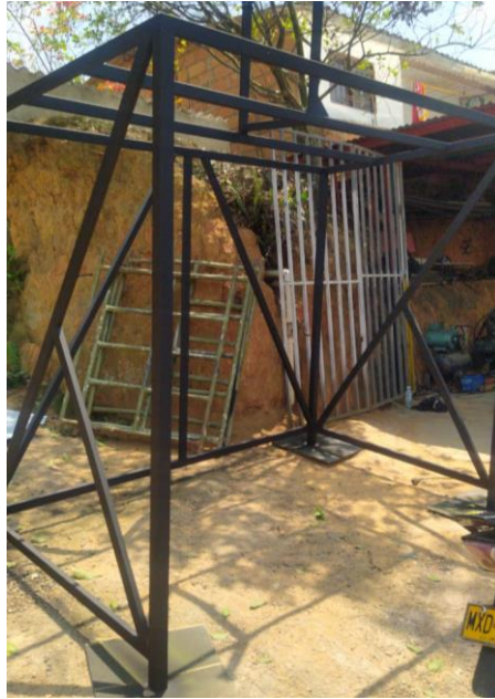
Figura 58. Estructura con recubrimiento anticorrosivo y pintura en negro mate. Fuente Autor.
