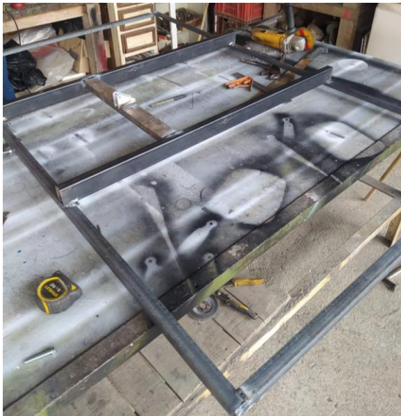
Figura 61. Soporte panel solar terminado. Fuente Autor.
