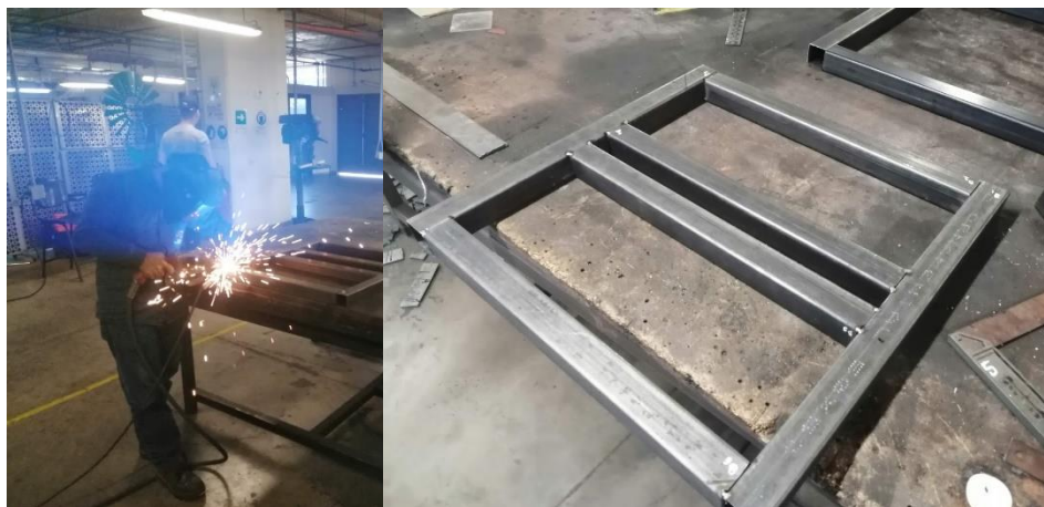
Figura 49. Soldadura de perfiles.
