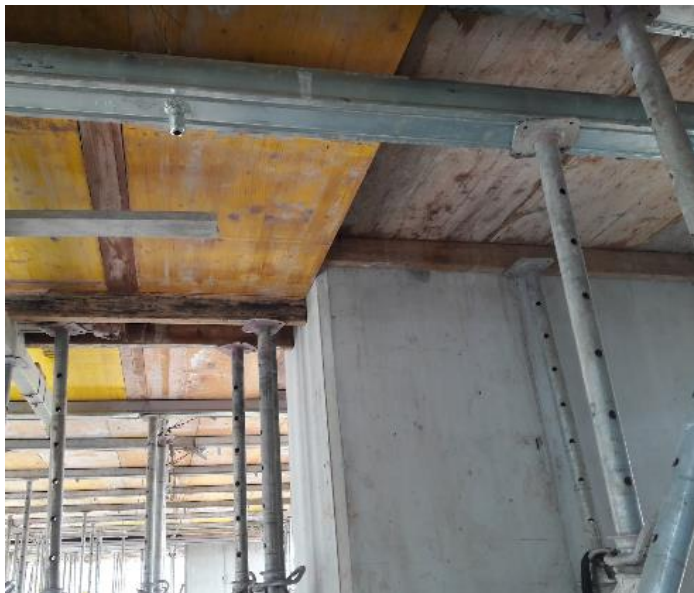
Ilustración 19 Remiendo en madera para remate de formaleta junto a columnas
