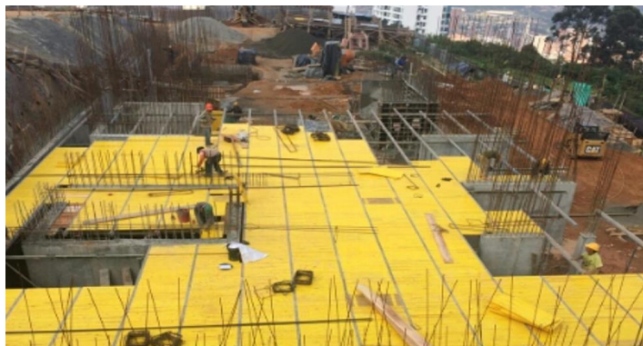
Ilustración 31 instalación STENmetro placa plana [propuesta STEN]
