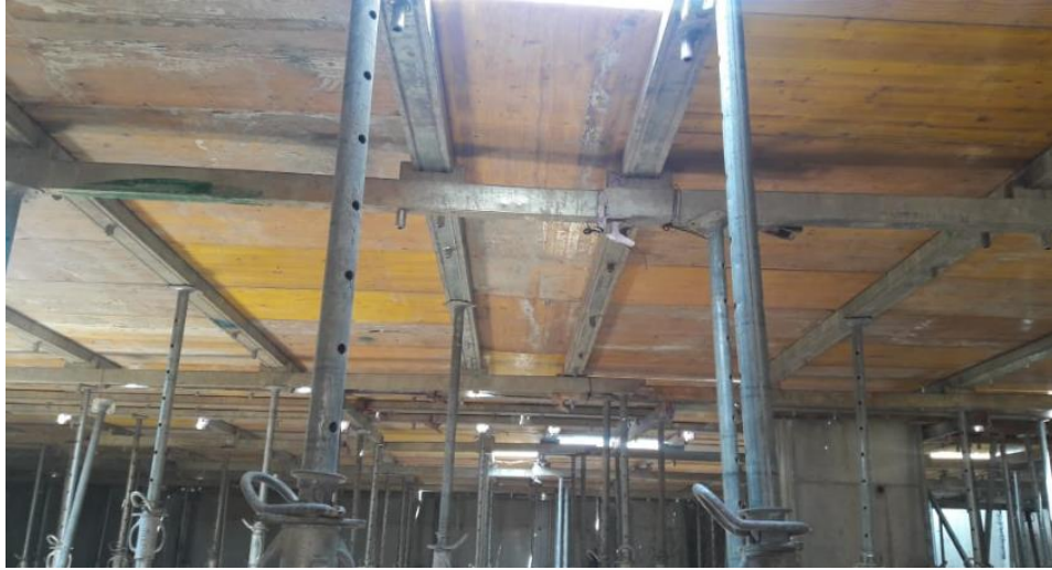
Ilustración 16 Uso de las portacorreas en superficie continua
