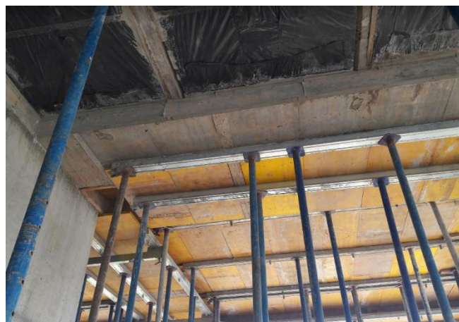
Ilustración 14 Doble entarimado por diferencial de alturas viga y vigueta
