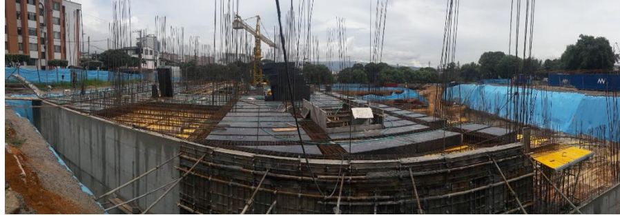
Ilustración 11 Instalación casetón removible
