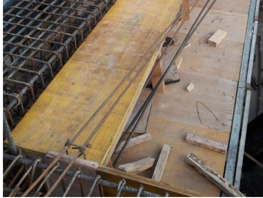
Ilustración 26 Armado encofrado de VOL-VOL
