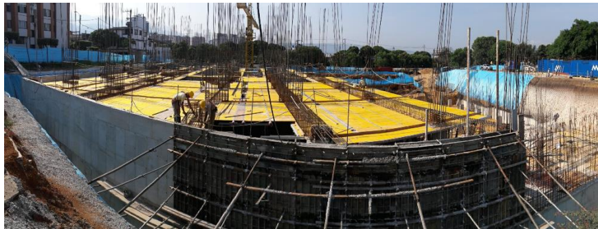
Ilustración 10 Encofrado de placa aligerada
