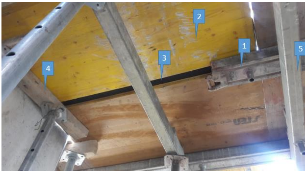
Ilustración 32 detalle instalación formaleta STEN vigas descolgadas
