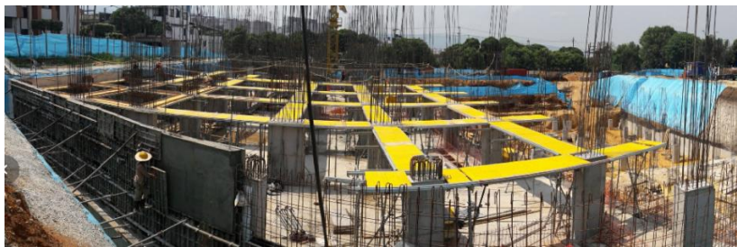
Ilustración 9 Encofrado inicial de vigas
