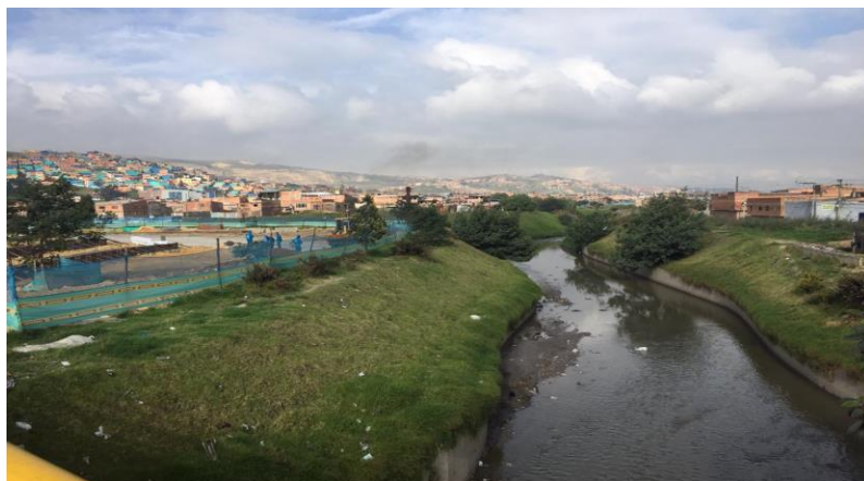
Imagen 14: Procesos de Urbanización Fuente: Tomada por el autor
