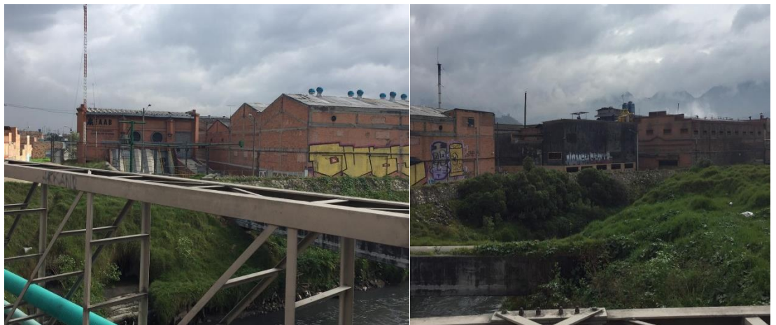
Imagen 12: Vertimientos y descargas al río – Barrio San Benito Fuente: Tomada por el autor
