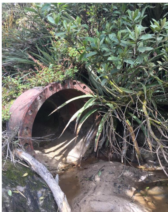
Imagen 3: Bocatoma y conducción del agua Fuente: Tomada por el Autor
