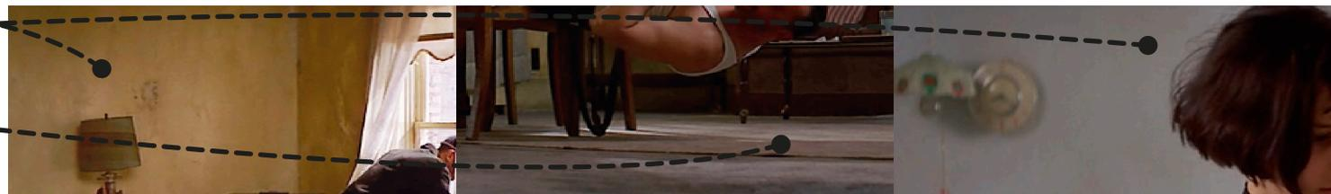
Muro con revestimiento liso acabado pintura color amarillo ■ Piso en concreto expuesto sin acabado ■ Muro con revestimiento liso acabado pintura color Gris ■
