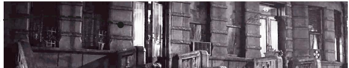
Fachada vaciada en concreto, acabado rustico con ornamento expuesto.
