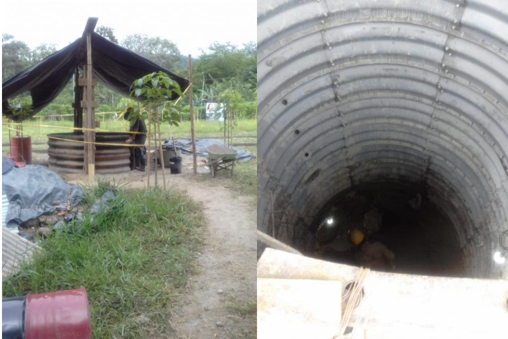
Figura 35. Obra de alcantarillado presente en el tramo analizado. Fuente: propia
