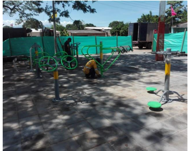
Imagen 13. Instalación elementos gimnasio biosaludable.
