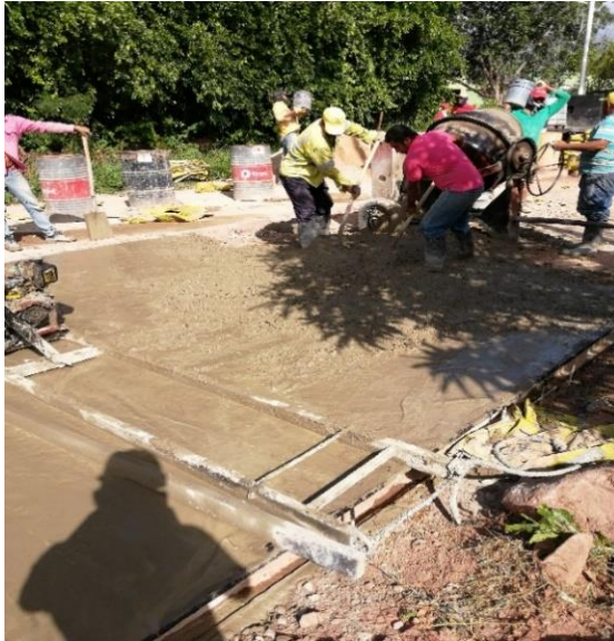
Imagen 19. Registro fotográfico fundición placa de concreto de 3500 psi.
