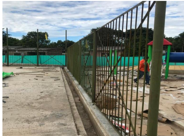
Imagen 12. Construcción cerramiento tipo IDR D altura 2.5Mts.
