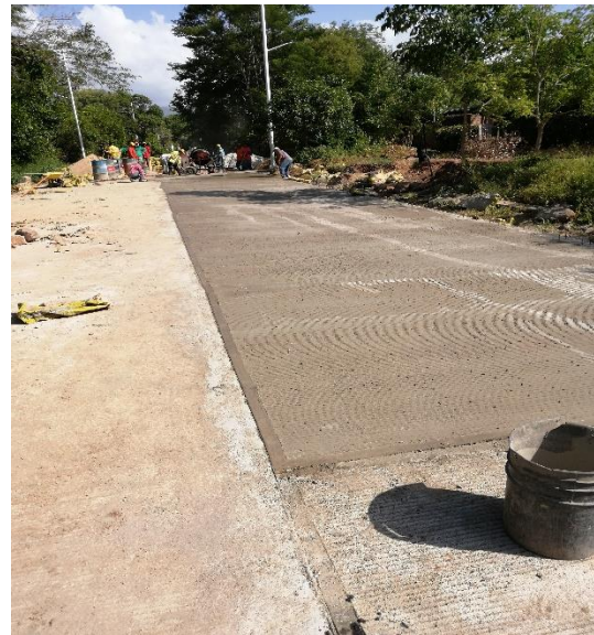
Imagen 20. Registro fotográfico placa de concreto fundida.
