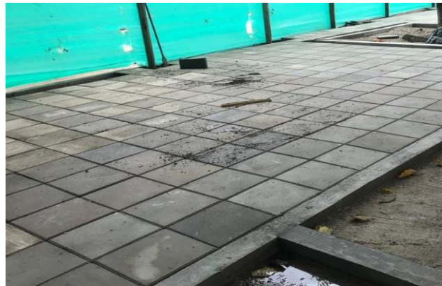
Imagen 7. Instalación losetas prefabricadas en concreto.
