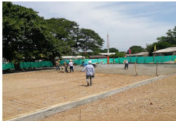
Imagen 10. Fundida de plantilla de piso en concreto de 3000 psi.
