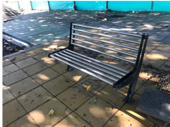
Imagen 14. Registro fotográfico instalación banca en concreto y espaldar en acero inoxidable.
