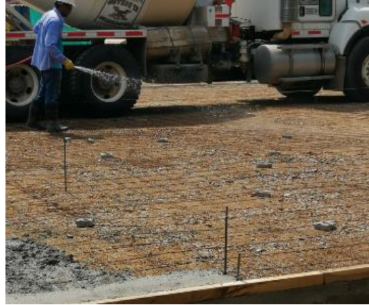
Imagen 8. Malla electrosoldada de 0.25x0.25m.
