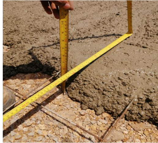
Imagen 9. Revisión espesores plantilla de piso para la cancha.
