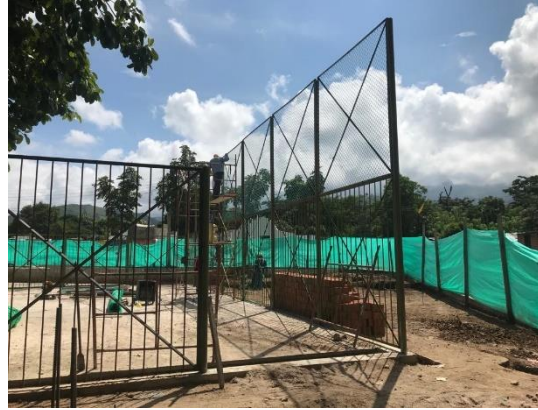
Imagen 11. Construcción de cerramiento contra impacto tipo I.D.R.D H=5m.
