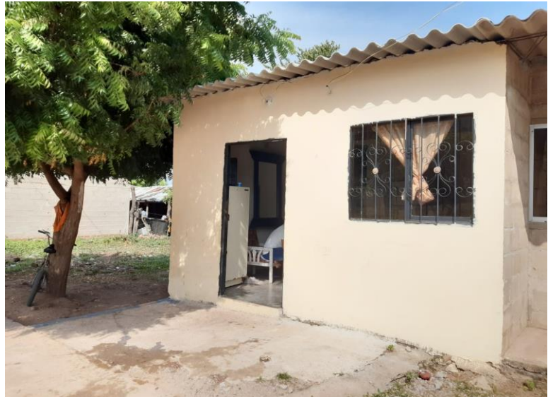
Imagen 28. Registro fotográfico 2 inspección de vivienda actas de vecindad proyecto noni futbol.
