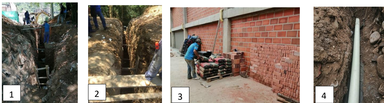
Fotografía 2 Construcción alcantarillado pluvial bodega Ricardo Pradilla. Fuente propia.
