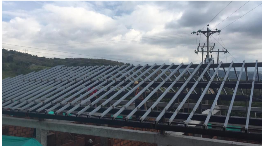
Imagen 26. Estructura Metálica del Techo
