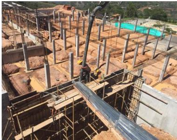
Imagen 21. Fundida Vástago de Muro de Contención
