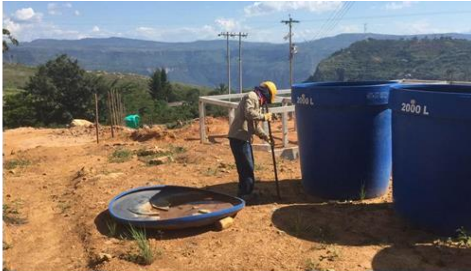
Imagen 23. Cerramiento de Obra
