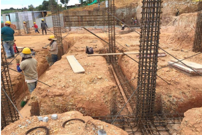
Imagen 12. Armado de Vigas y Columnas de Acero
