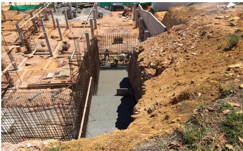
Imagen 19. Fundida Zapata Muro de Contención
