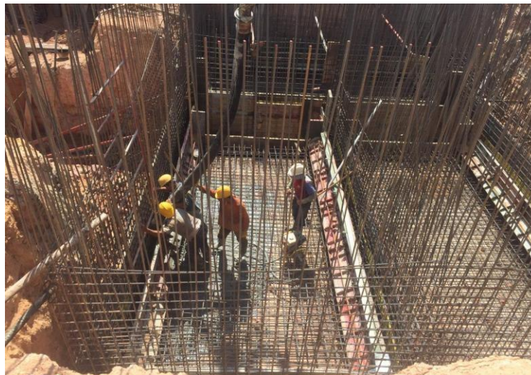
Imagen 24. Fundida de Placa de Tanque
