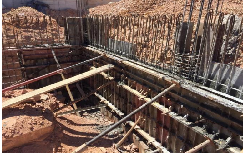
Imagen 18. Fundida Muro Perimetral
