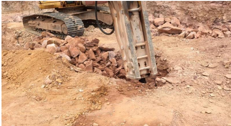
Imagen 14. Excavación en Roca
