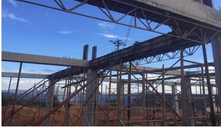
Imagen 20. Fundida de Vigas Aéreas
