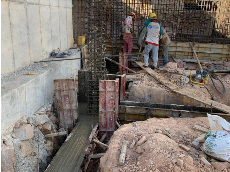
Imagen 15. Fundida Zapatas de Cimentación
