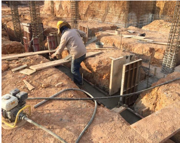
Imagen 13. Fundida Vigas de Cimentación
