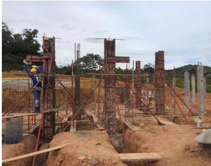
Imagen 17. Fundida de Columnas
