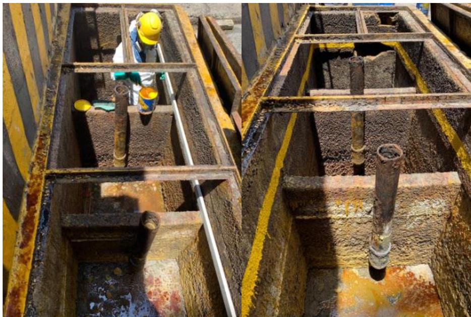
Figura 16. *Delimitación capacidad máxima de la trampa de grasas de Planta 1*
