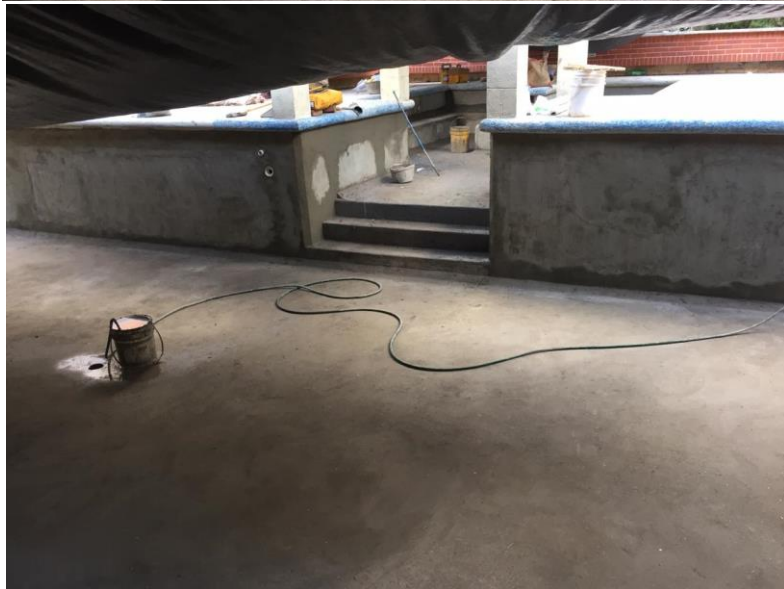
Ilustración 16. Aplicación Sistema de impermeabilización SikaTop -121 Monocomponente.
