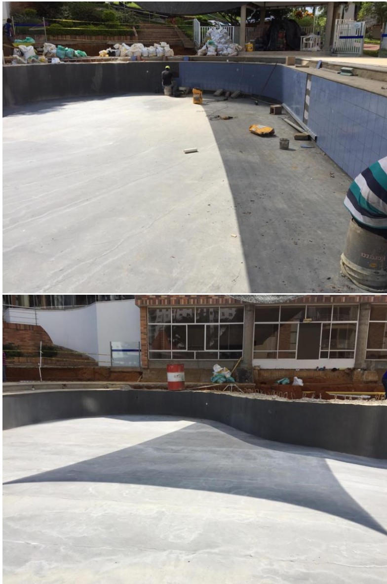
Ilustración 15. Aplicación Sistema de impermeabilización Sikalastic -1K
