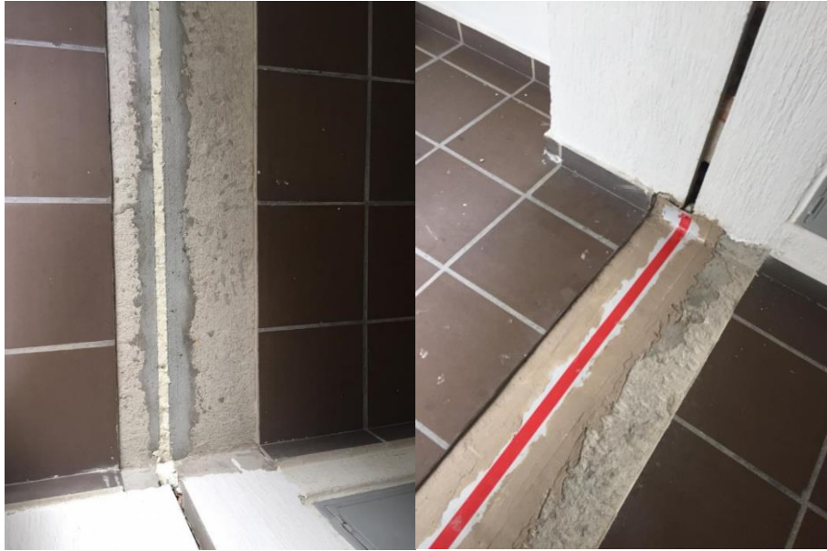
Ilustración 20. Aplicación Sikadur -Combiflex SG.
