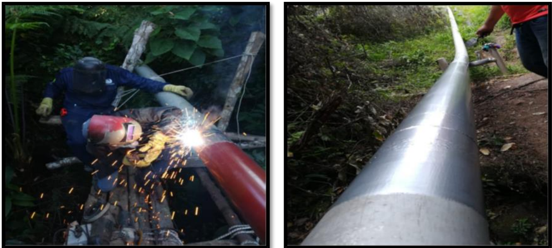
Fotografía 22. Soldadura tramo PK 21+212
