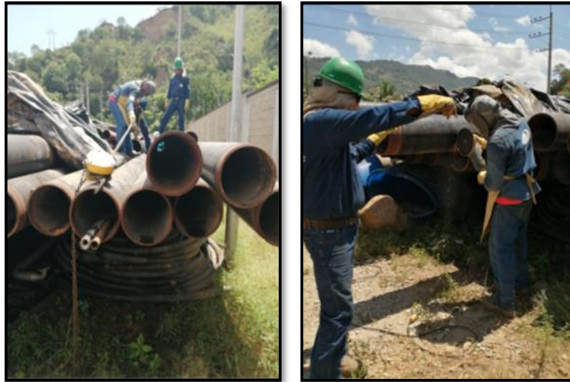
Fotografía 1. Medición y corte de tubería para fabricación de camisas
