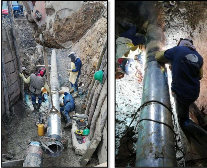
Fotografía 20. Alineamiento y soldadura Sector Jove
