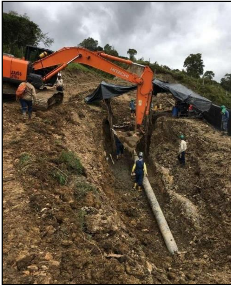
Fotografía 18. Corte de tramo reemplazo Sector Jove
