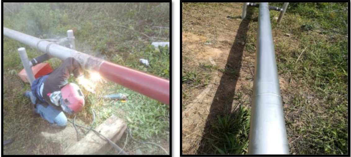
Fotografía 21. Soldadura tramo PK 21+125
