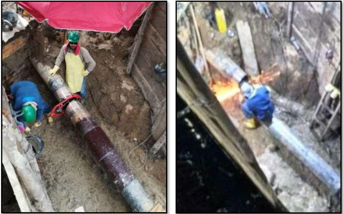
Fotografía 19. Corte de tubería, biseles y refrentado Sector Jove
