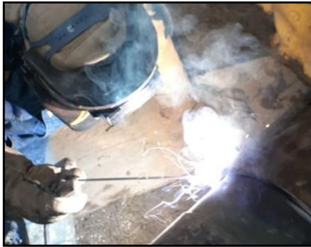
Fotografía 8. Ejecución de junta circunferencial Camisa 1 Sector Jove
