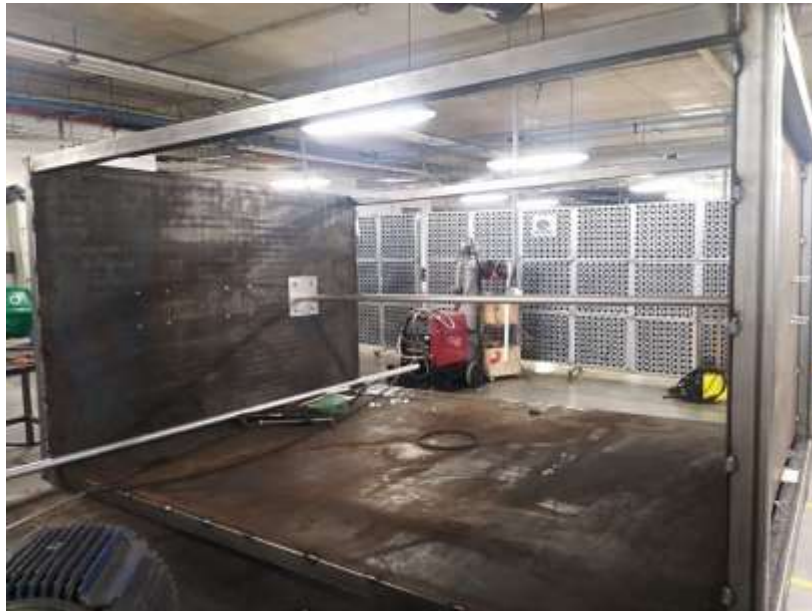
Figura 51. Ensamble de la estructura.
