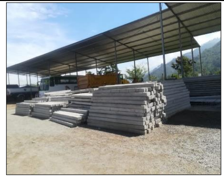
Foto 5. Acopio Postes de Concreto
