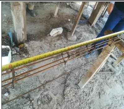
Foto 3. Espaciamiento de estribos
