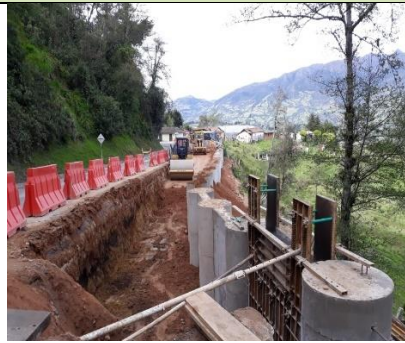
Foto 20. Compactación de material granular en la UF4
