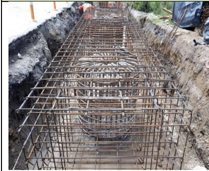
Foto 19. Armado de acero para viga Cabezal modulo 1 . UF3
