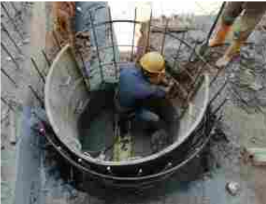
Ilustración 90. Acero de refuerzo pozos de inspección.
