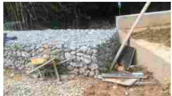
Ilustración 35. instalación de gaviones en la salida de box culvert
