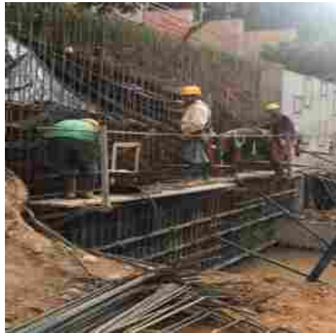
Ilustración 57., figuración de acero muros noroccidental (talud Alto viento II)
