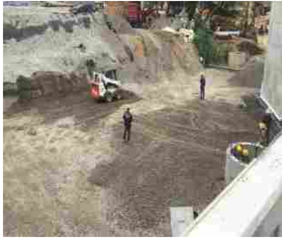
Ilustración 12 . Muros en tierra armada
