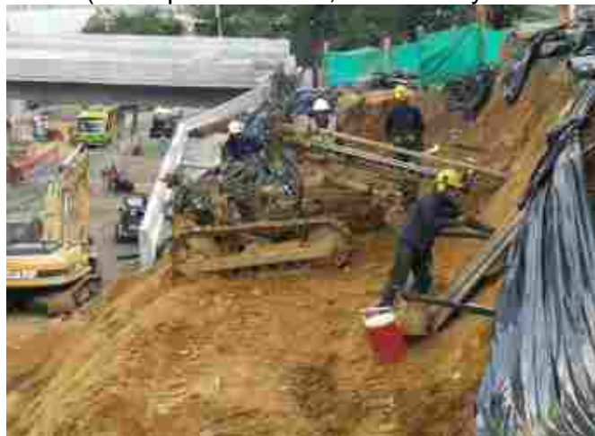
Ilustración 49. Instalación anclajes muro de contención noroccidental (talud Alto viento II)
