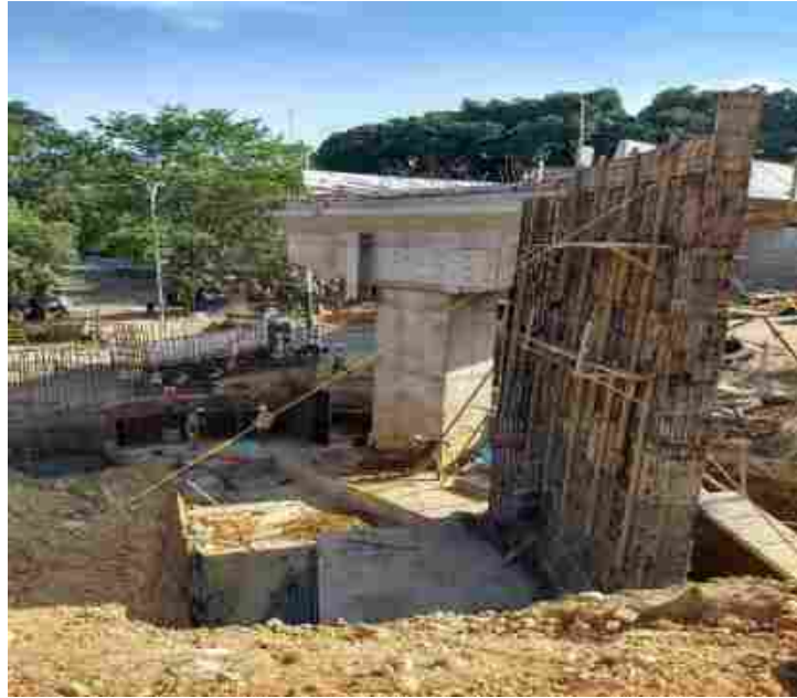
Ilustración 39. Fundición y enconframiento, muros de contención costado oriental (entre puente norte y box curvo)
