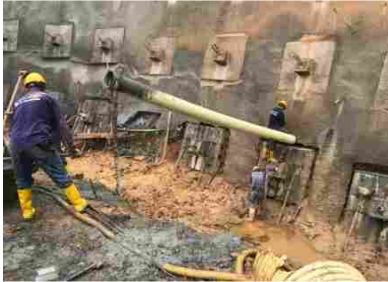
Ilustración 18. Fundición dados en concreto
