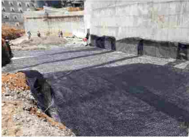
Ilustración 71. Instalación de geomalla tipo Bx-100, (relleno entre puente norte y box curvo)
