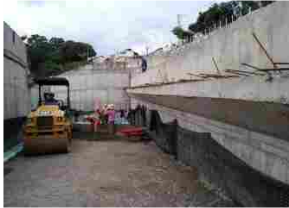
Ilustración 75. Muros en tierra armada (céreo e instalación), pila Suroriental, (relleno puente sur-box curvo-box recto)
