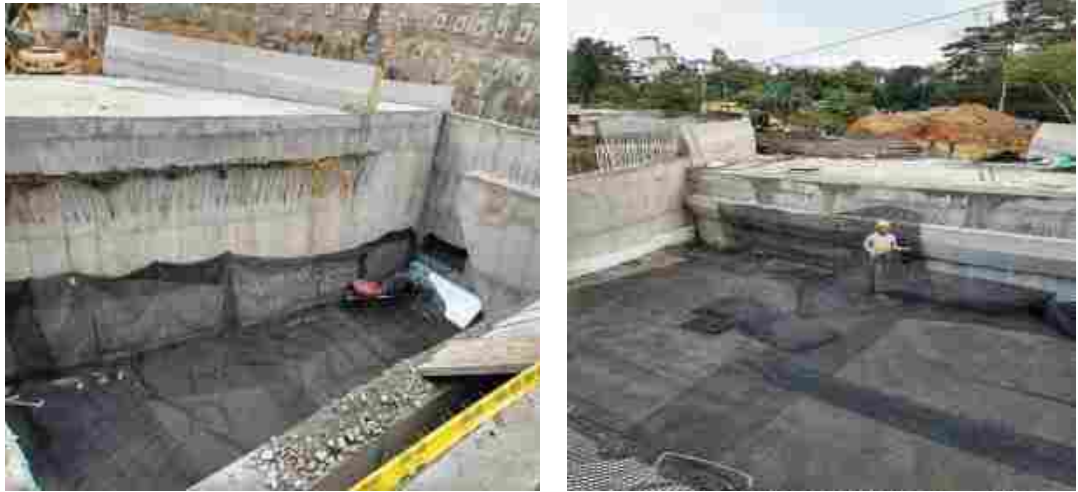
Ilustración 77. Instalación de geomalla tipo Bx-50, (relleno puente sur-box curvo-box recto)
