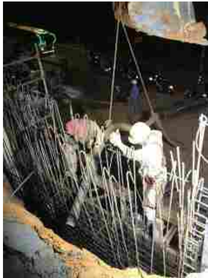
Ilustración 59. vaciado de concretos muros noroccidental (talud Alto viento II)
