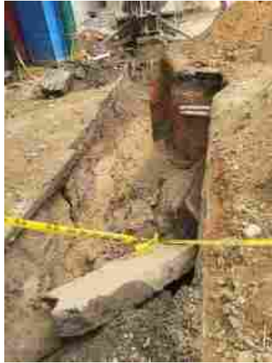
Ilustración 80. Excavaciones para instalación de tubería.
