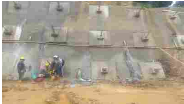
Ilustración 21. Terminación muro anclado barrio San Bernardo
