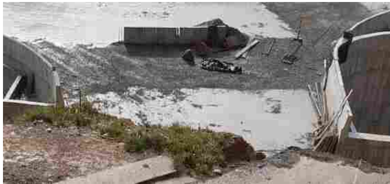
Ilustración 108. losas de aproximación terminadas (costado oriental)
