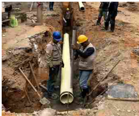
Ilustración 82. instalación tubería en pvc
