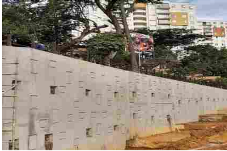
Ilustración 60. muros noroccidentales terminados (talud Alto viento II)
