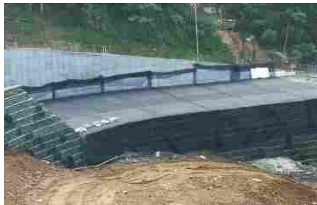
Ilustración 63. Instalación de geomalla, pila suroccidental
