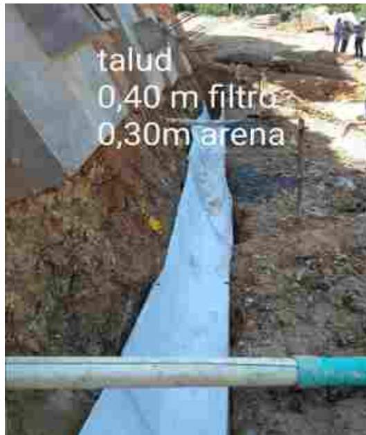
Ilustración 16. Utilización de geomebrana para filtro de agua
