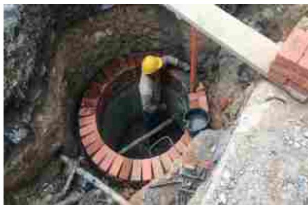
Ilustración 88. Construcción pozos de inspección.
