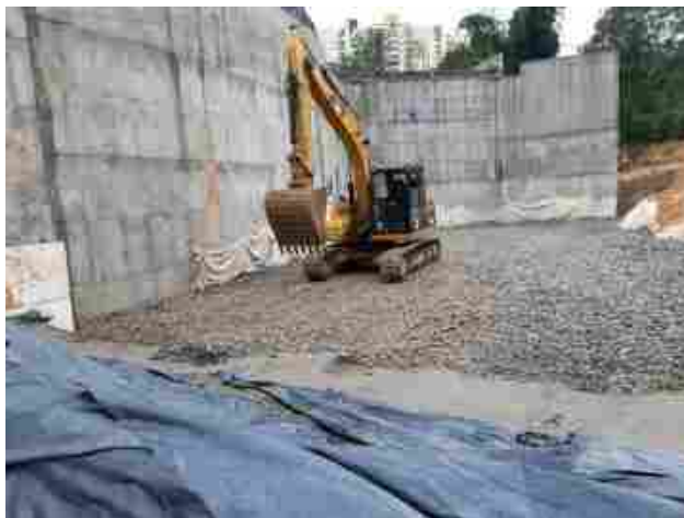
Ilustración 13 . Muros en tierra armada
