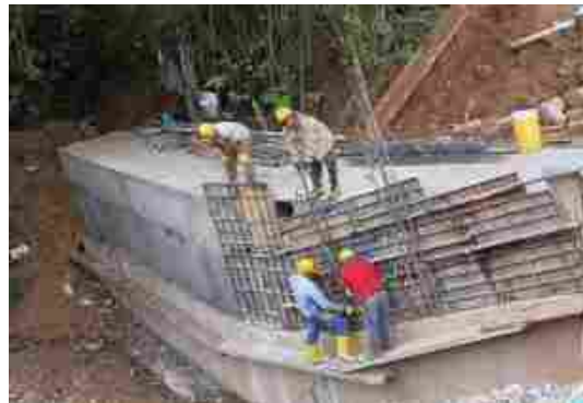
Ilustración 36. Desencofrado de gaviones, revestidos en concreto
