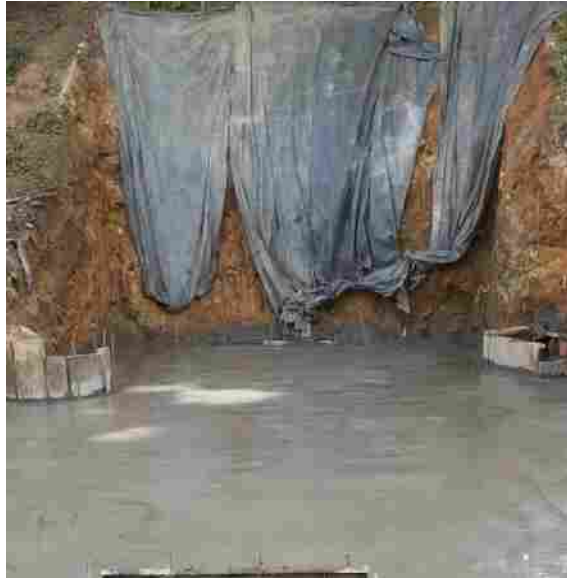
Ilustración 31. Losa de fondo fundida
