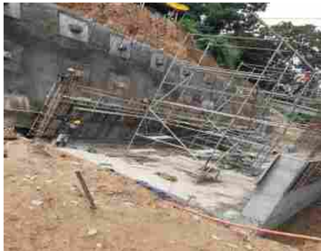
Ilustración 26. Losa de fondo fundida y muros confinados, box recto
