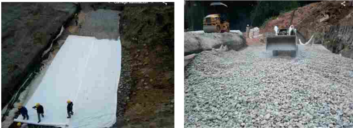
Ilustración 61. Filtro de pedraplén y geomembrana
