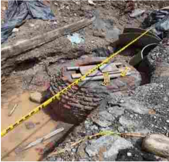
Ilustración 89. Construcción pozos de inspección.
