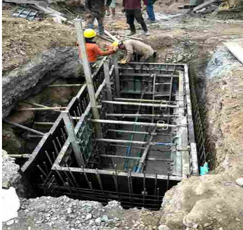
Ilustración 92. Construcción estructura de separación.
