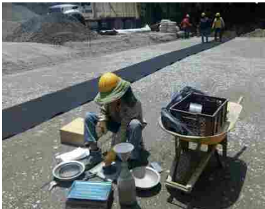
Ilustración 64. Ensayos de densidades realizados al relleno, pila suroccidental
