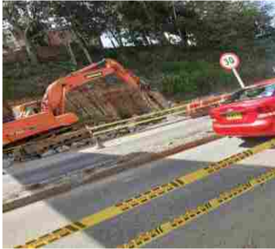
Ilustración 22. Perfilado del talud, barrio Santa Fe
