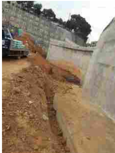
Ilustración 42. muros de contención costado oriental (entre puente norte y box curvo) totalmente terminados
