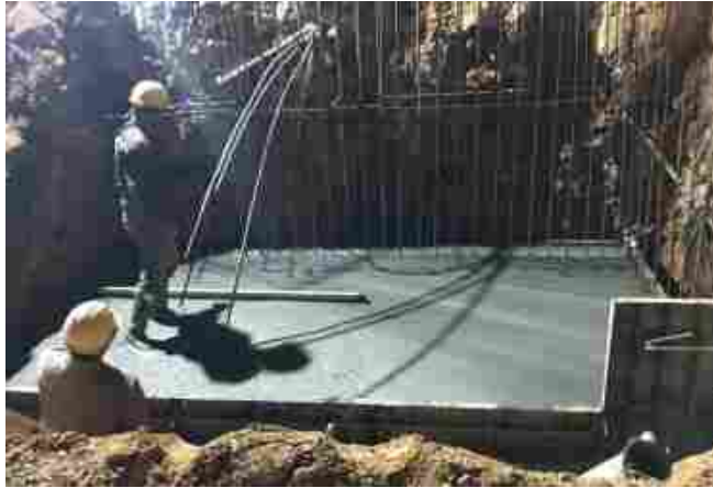
Ilustración 56. fundición zapatas muros noroccidental (talud Alto viento II)
