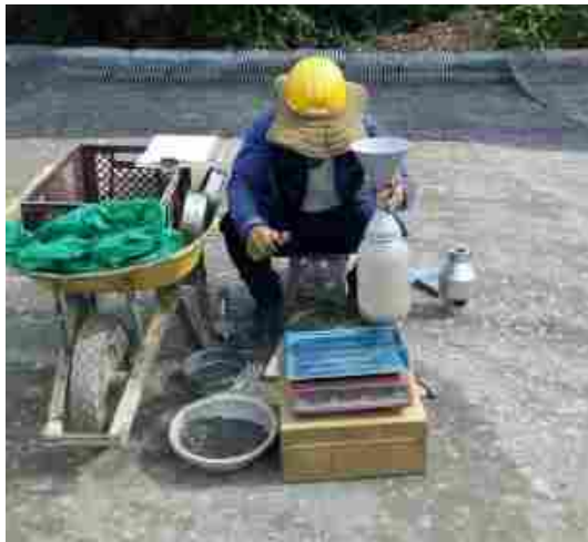
Ilustración 72. Ensayos de densidades realizados al relleno, (relleno entre puente norte y box curvo)
