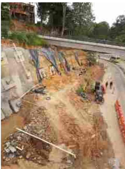
Ilustración 5. Muro anclado costado oriental, barrio Santa Fe
