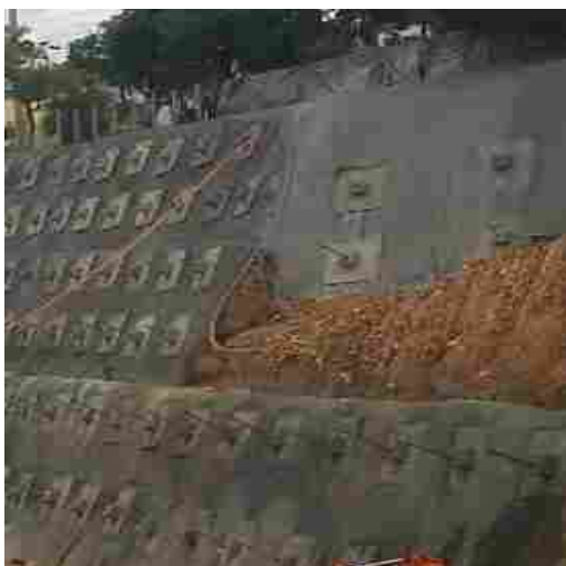
Ilustración 3. Muro anclado costado oriental, barrio San Bernardo
