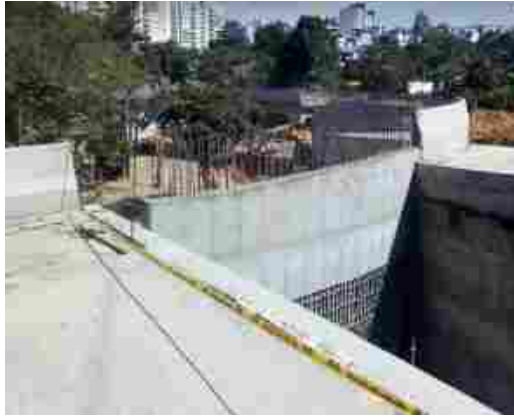
Ilustración 47. desconfinamiento y terminación, Muros de contención costado oriental (entre puente norte, box recto y box curvo)
