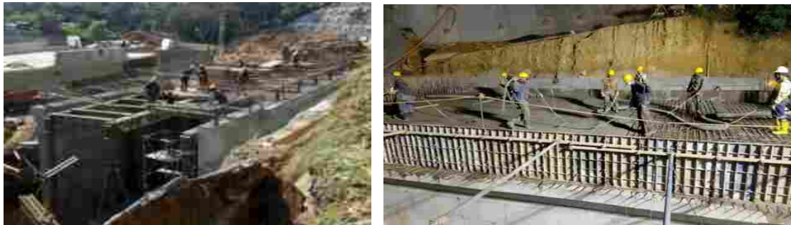
Ilustración 28. Losa tapa, figuración de acero y vaciado de concreto, box recto
