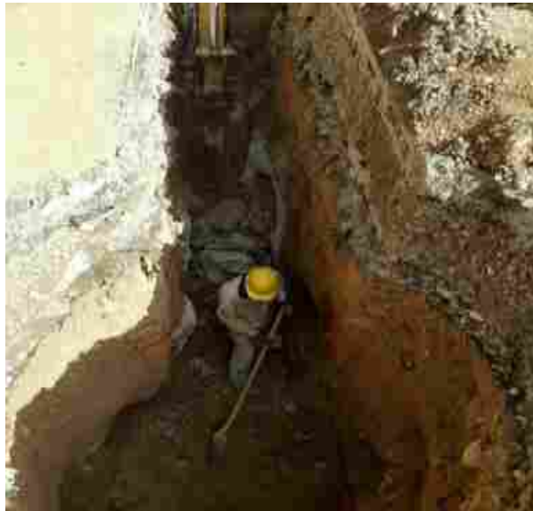
Ilustración 87. Excavaciones para pozos de inspección.
