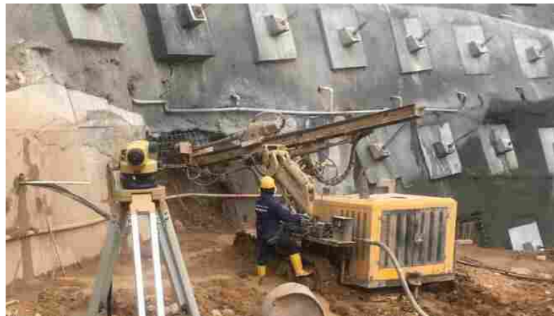
Ilustración 17. Perforación e Instalación de torones
