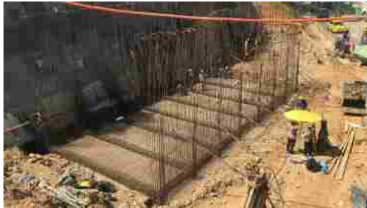
Ilustración 25. Figuración del acero box recto
