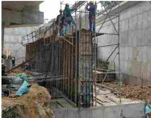
Ilustración 45. , fundición y enconframiento de Muros de contención costado oriental (entre puente norte, box recto y box curvo)
