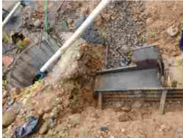
Ilustración 86. Atraques de concreto para tubería
