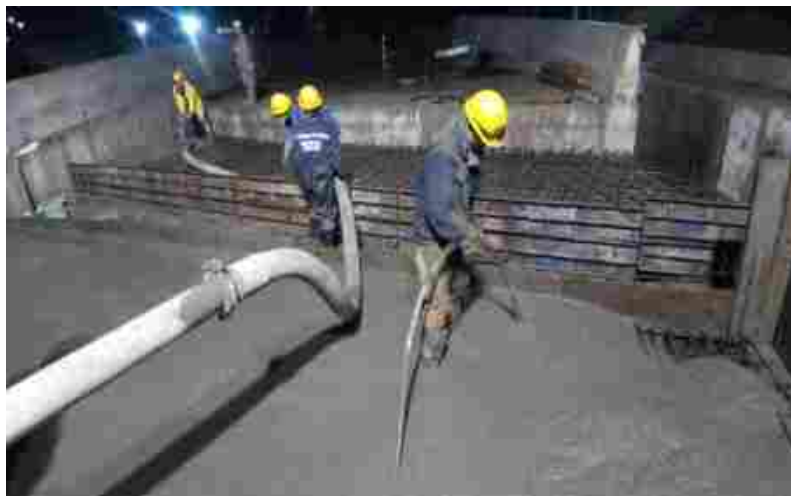
Ilustración 106. Vaciado de concreto en losas de aproximación (costado oriental)
