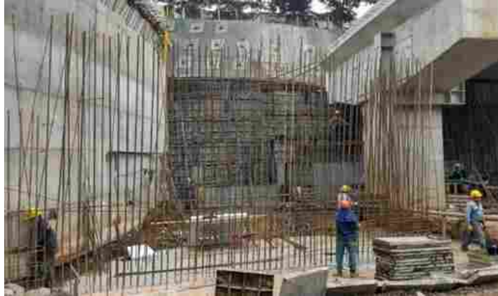
Ilustración 44. Figuración de acero, fundición y enconframiento de Muros de contención costado oriental (entre puente norte, box recto y box curvo)
