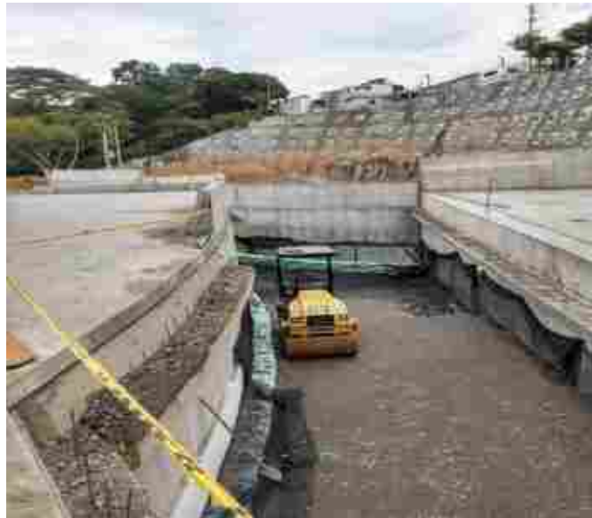
Ilustración 76. Muros en tierra armada (compactado), pila Suroriental, (relleno puente sur-box curvo-box recto)
