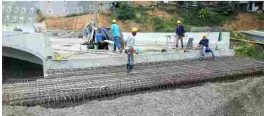
Ilustración 102. Figuración de acero, losa de aproximación (costado occidental)
