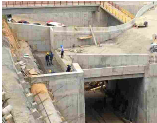
Ilustración 105. Figuración de acero losas de aproximación (costado oriental)
