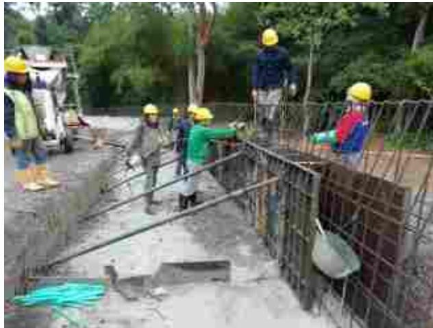
Ilustración 101. Confinamiento y vaciado de concretos muros de New jersey sobre tierra
