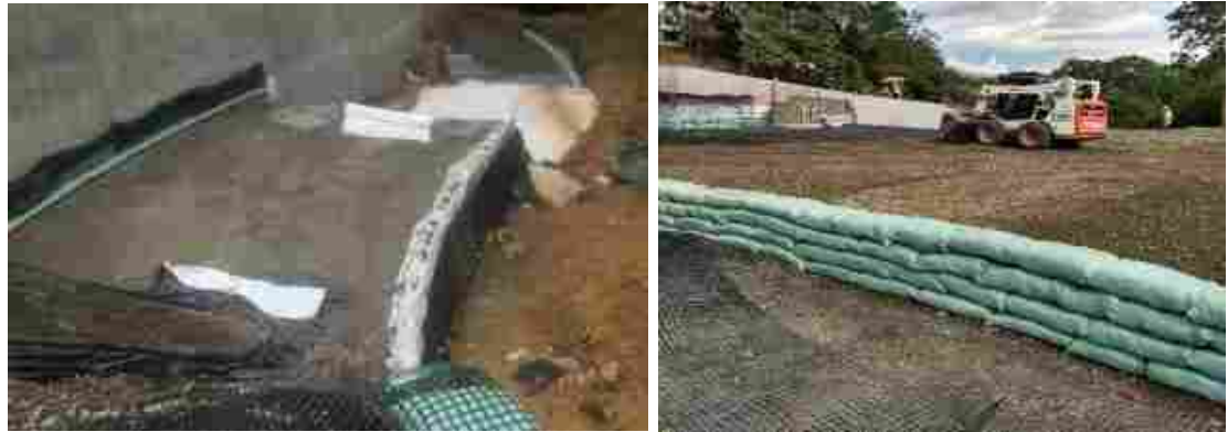
Ilustración 62. Muros en tierra armada (instalación y céreo), pila Suroccidental
