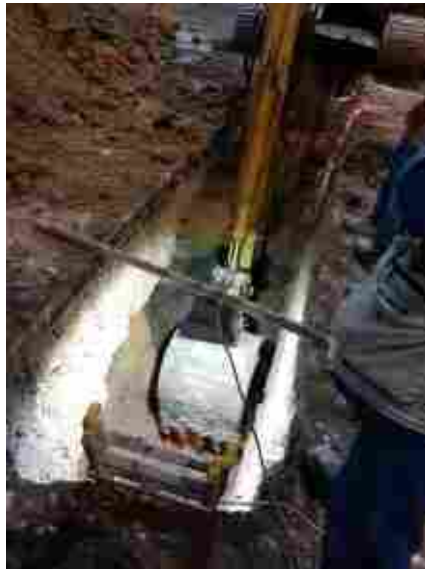
Ilustración 79. Excavaciones para instalación de tubería.
