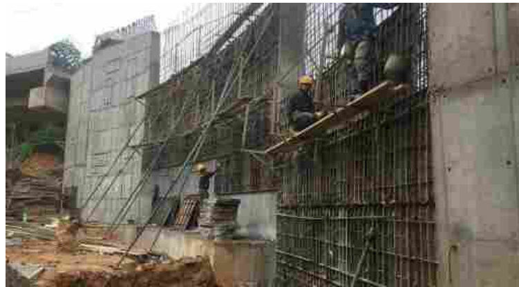
Ilustración 40. Fundición y enconframiento, muros de contención costado oriental (entre puente norte y box curvo)
