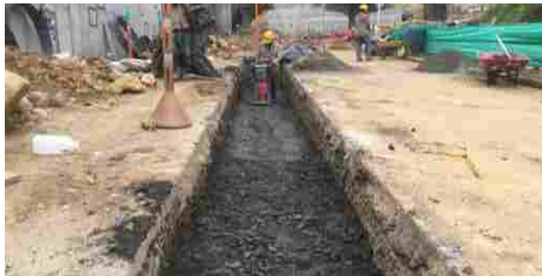
Ilustración 85. Compactación de relleno para tubería
