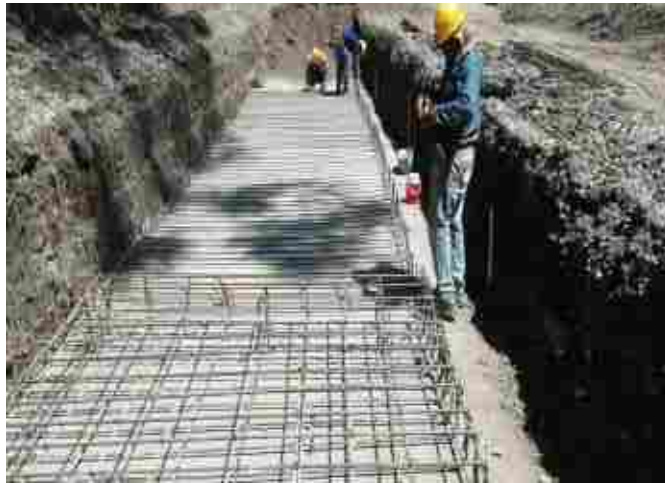
Ilustración 98. Figuración acero cimientos de New jersey sobre tierra
