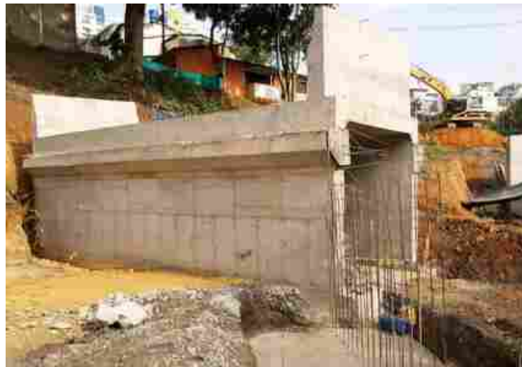
Ilustración 34. Aletas en concreto, box peatonal
