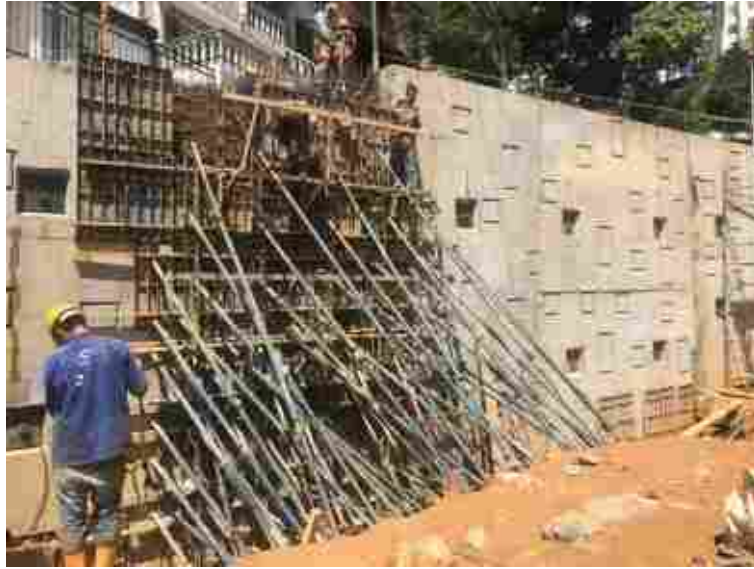
Ilustración 58. , confinamiento muros noroccidental (talud Alto viento II)
