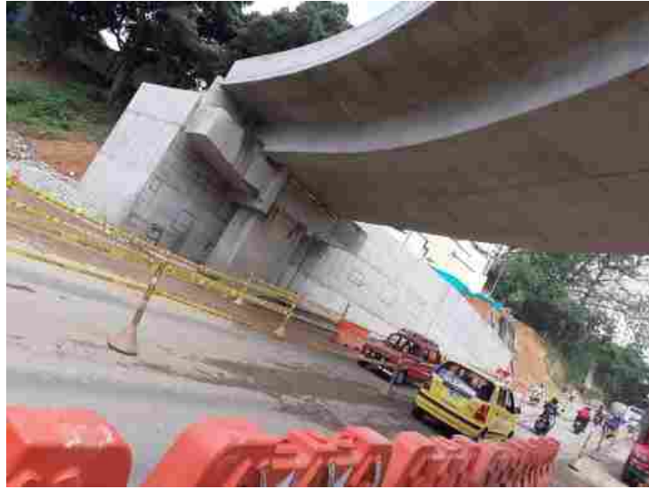
Ilustración 54. muros noroccidentales terminados (muro no anclado)
