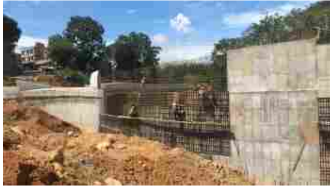
Ilustración 41. Fundición y enconframiento, muros de contención costado oriental (entre puente norte y box curvo)
