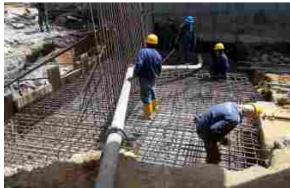
Ilustración 43. Figuración de acero y fundición de zapatas. Muros de contención costado oriental (entre puente norte, box recto y box curvo).
