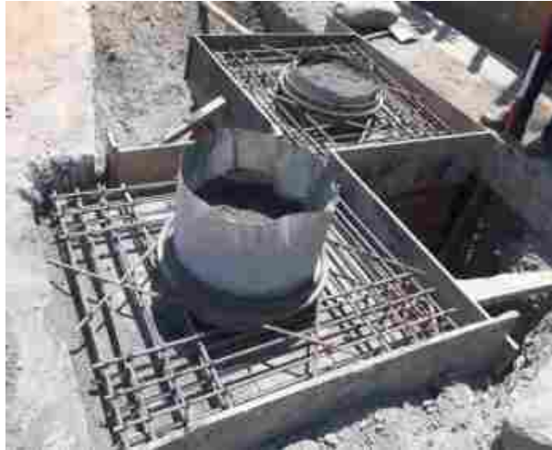
Ilustración 94. Acero de refuerzo y terminación estructura de separación.
