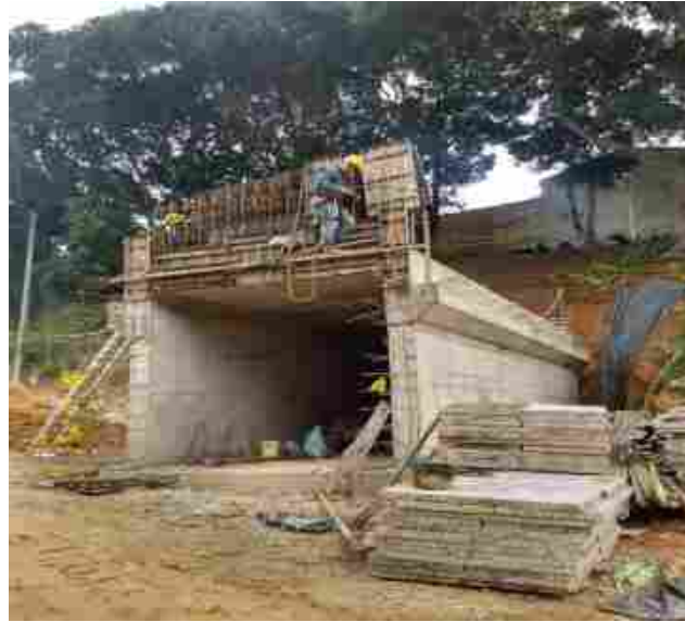
Ilustración 33. Muros New Jersey, box peatonal
