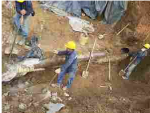
Ilustración 81. retiro de tubería antigua y con daños.
