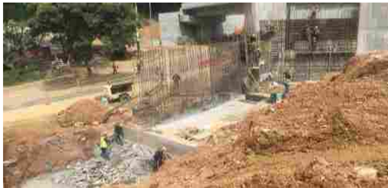
Ilustración 38. Figuración de acero. Muros de contención costado oriental (entre puente norte y box curvo)
