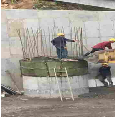
Ilustración 91. Fundición en concreto pozos de inspección.
