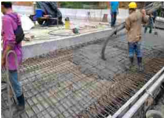
Ilustración 103. Vaciado de concreto, losa de aproximación (costado occidental)
