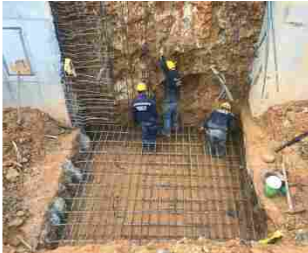
Ilustración 55., figuración de acero zapatas muros noroccidental (talud Alto viento II)
