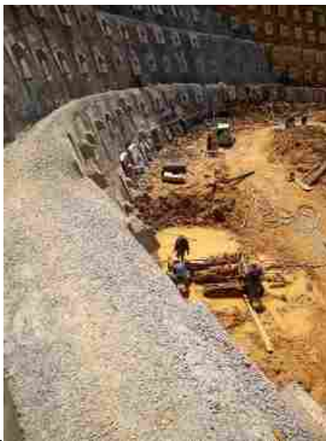
Ilustración 4. Muro anclado costado oriental, barrio San Bernardo
