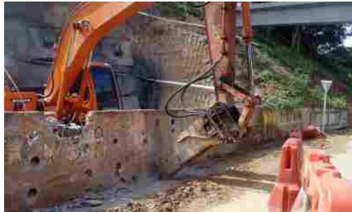
Ilustración 23. Demolición estructura en concreto
