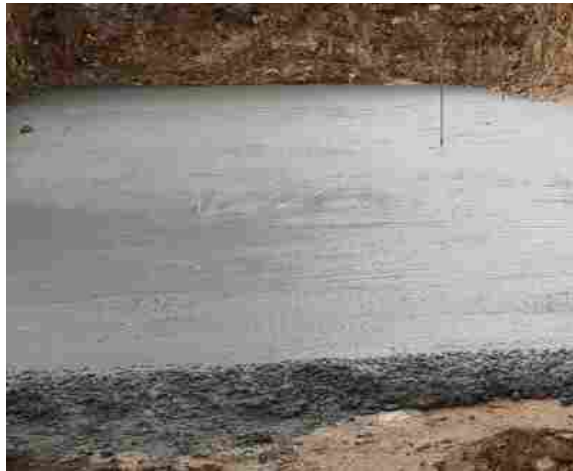
Ilustración 29. Solado de concreto, box peatonal
