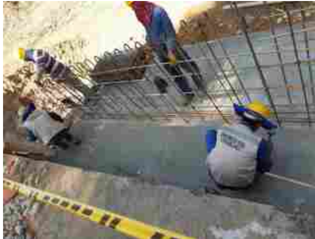
Ilustración 100. Fundición cimientos de New jersey sobre tierra
