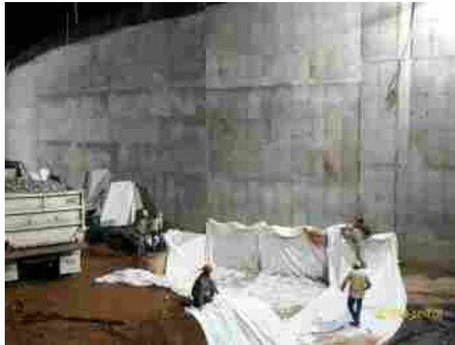
Ilustración 66. Instalación de geotextil no tejido (relleno entre puente norte y box curvo)
