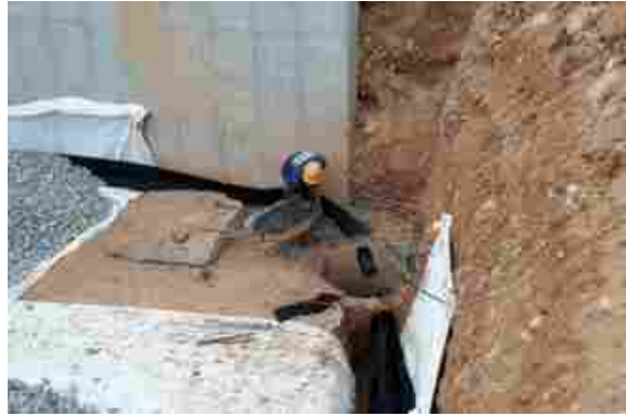
Ilustración 68. Colocación de geodren vial, como tubería drenante, en plástico (relleno entre puente norte y box curvo)
