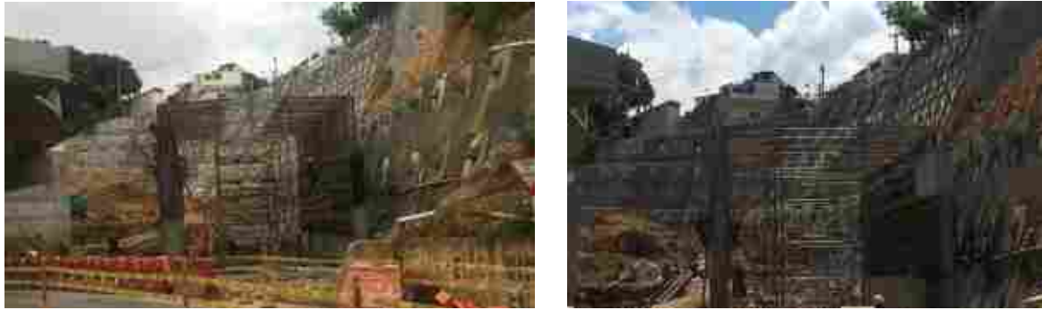
Ilustración 27. muros confinados, box recto
