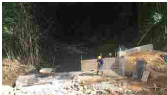
Ilustración 35. instalación de gaviones en la salida de box culvert
