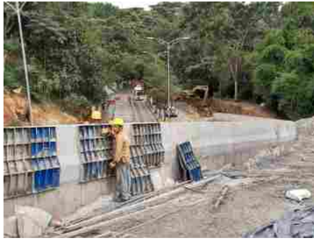
Ilustración 96. Terminación de New jersey sobre muro
