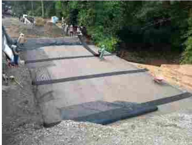
Ilustración 65. instalación de geodrén planar, pila suroccidental
