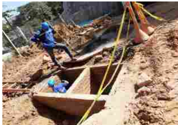
Ilustración 93. Mampostería estructura de separación.
