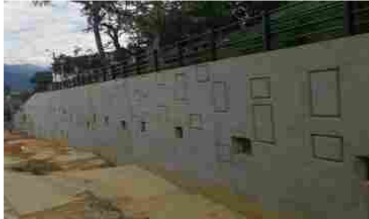
Ilustración 8. Muros de contención y anclado, barrio Altoviento II
