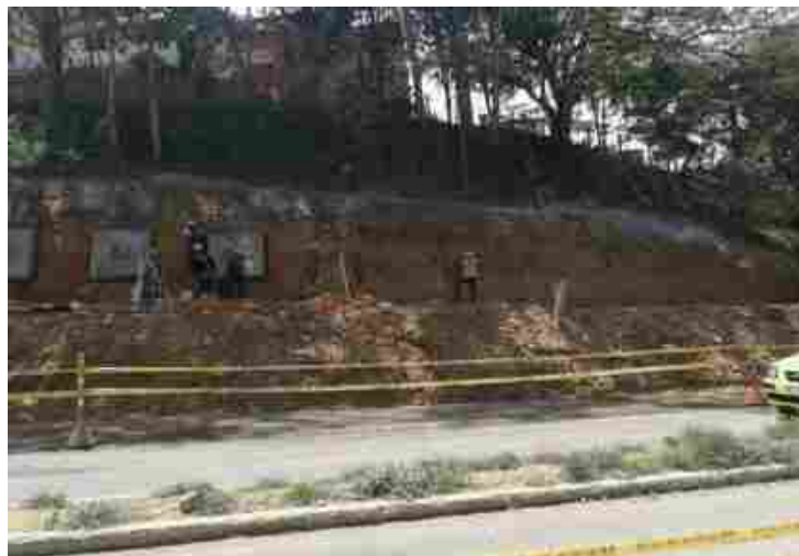
Ilustración 24. Instalación anclajes, barrio Santa Fe
