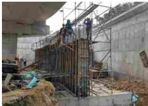
Ilustración 10. Construcción muros de contención pila suroriental
