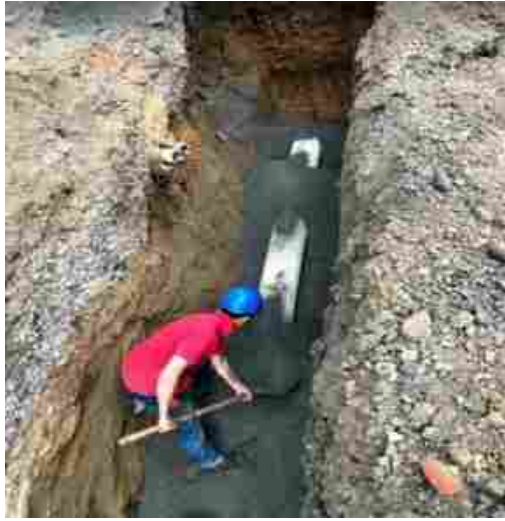
Ilustración 83. Colocación de relleno para tubería
