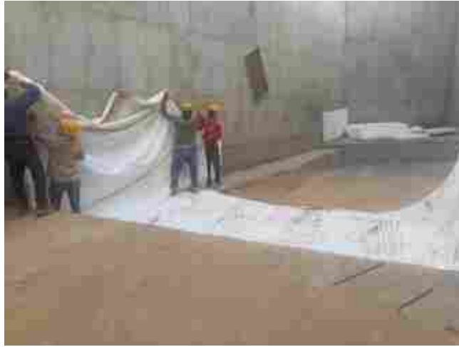
Ilustración 73. Instalación de geotextil no tejido (relleno puente sur-box curvo-box recto)
