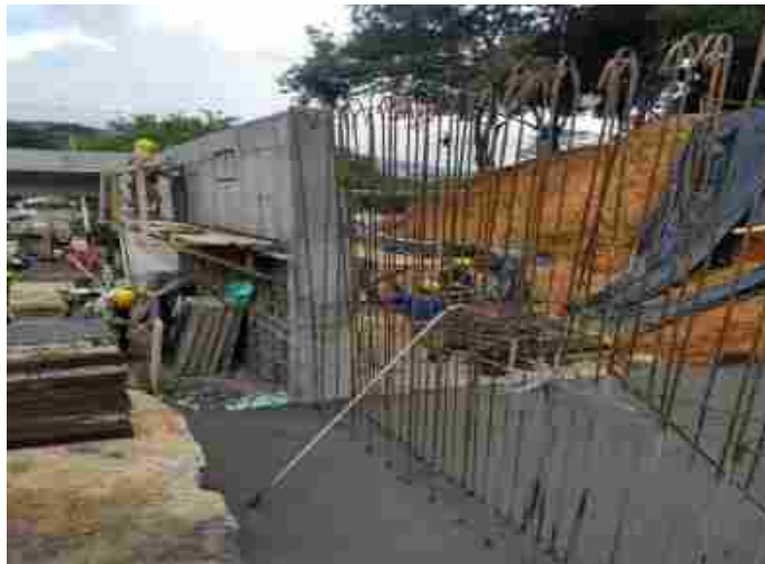
Ilustración 51. fundición de zapatas y figuración de acero para muro, muros noroccidentales (muro no anclado)
