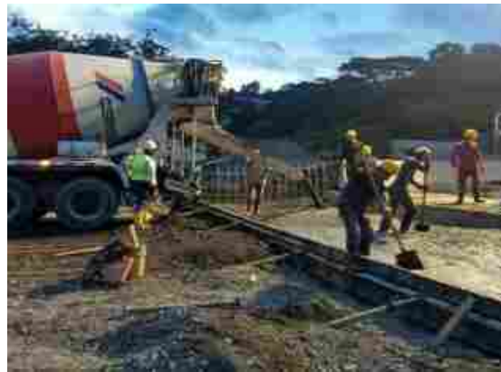
Ilustración 103. Vaciado de concreto, losa de aproximación (costado occidental)
