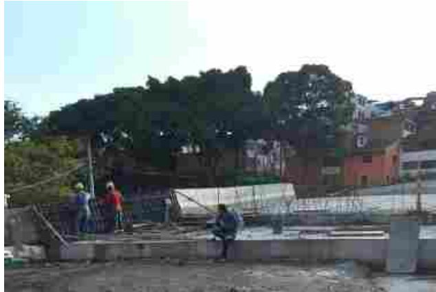
Ilustración 104. losa de aproximación terminada (costado occidental)
