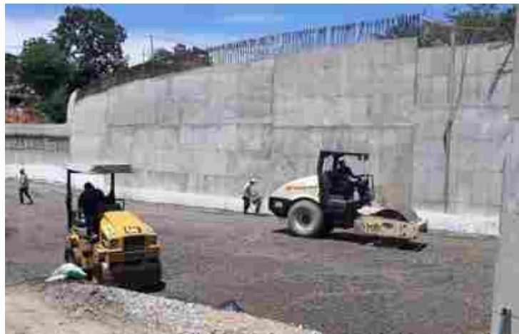
Ilustración 69. Muros en tierra armada (céreo, compactación e instalación), pila Suroriental, (relleno entre puente norte y box curvo)
