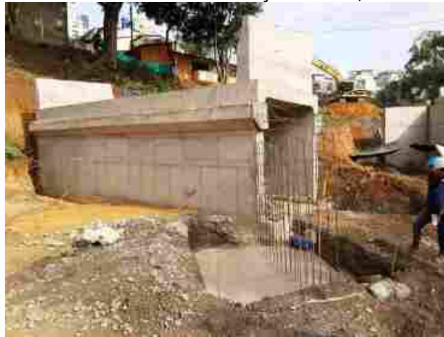
Ilustración 9. Construcción box culvert peatonal
