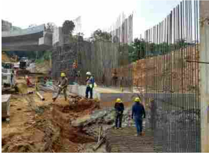
Ilustración 37. Figuración de acero y fundición de zapatas. Muros de contención costado oriental (entre puente norte y box curvo)
