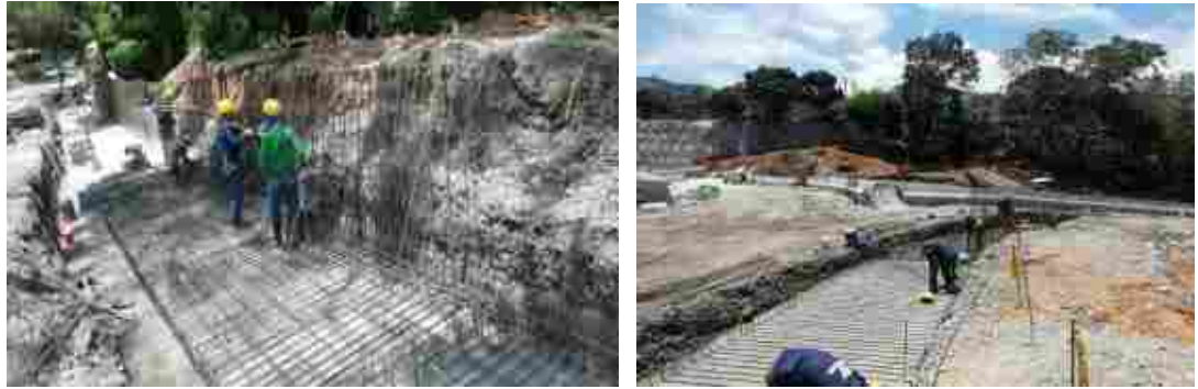
Ilustración 99. Figuración acero de New jersey sobre tierra
