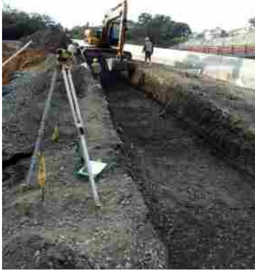
Ilustración 97. Excavación de New jersey sobre tierra
