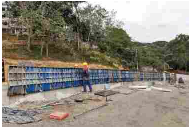
Ilustración 15 .Muros New Jersey
