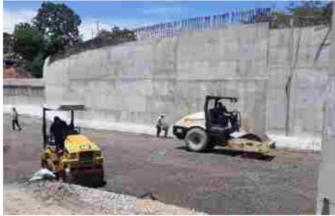
Ilustración 14 .Muros en tierra armada
