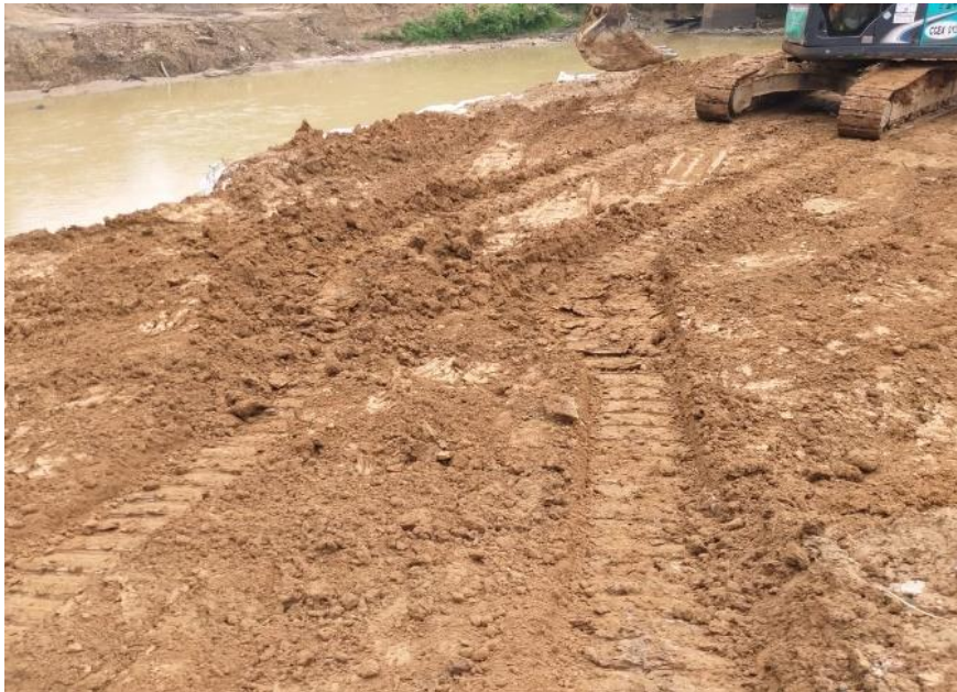
Imagen 1. Replanteo de terreno con la retroexcavadora de lodos
