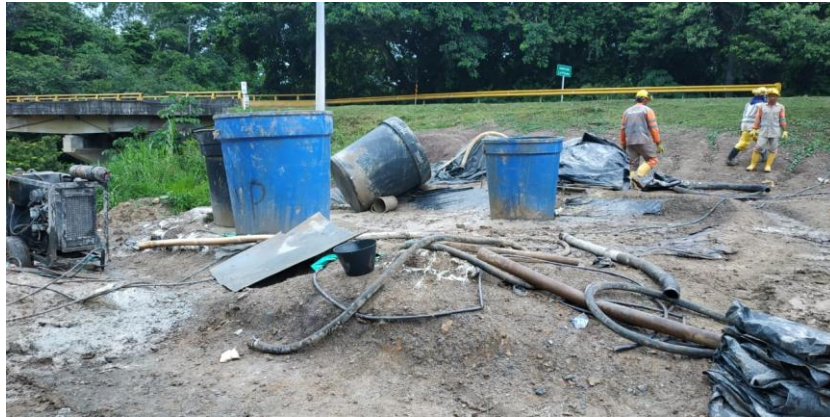
Imagen 10. Retiro de tanques y equipo de inyección
