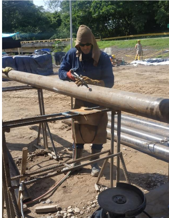
Imagen 4. Soldadura de Tubería de acero de 6"
