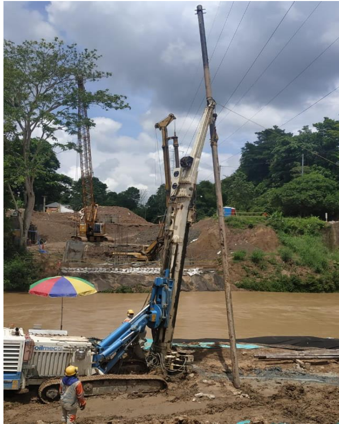
Imagen 6. Incorporación de tubería de acero de 6” en la perforación.
