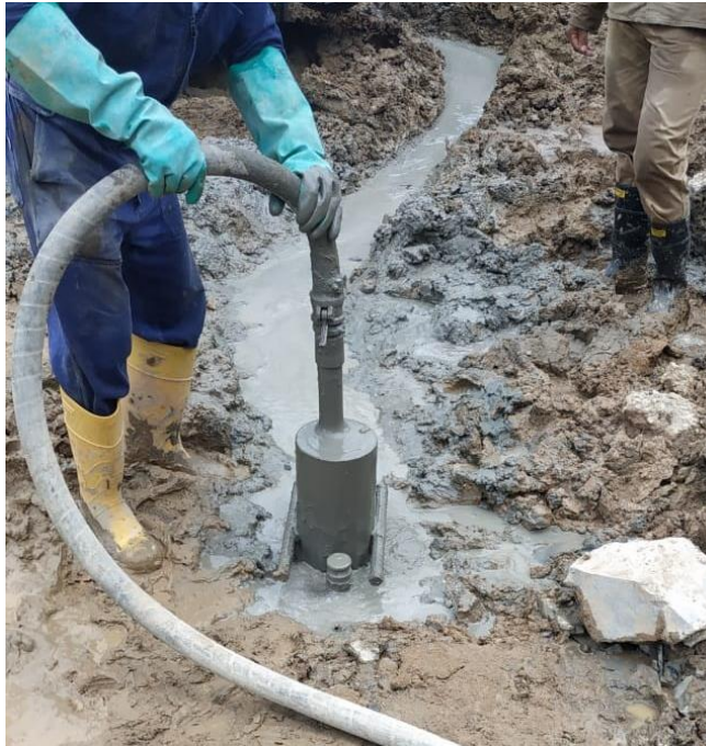
Imagen 8. Inyección de agua-lechada, con zanja para evitar problemas ambientales
