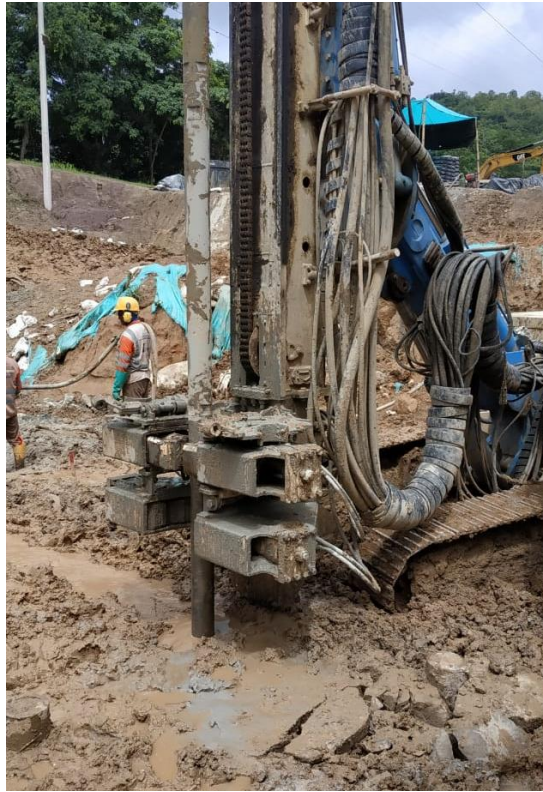
Imagen 5. Perforación de micropilote con la Soilmec SM 14 a 18 mt de profundidad
