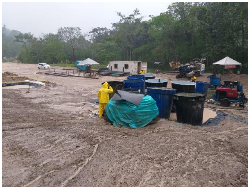
Imagen 2. Localización de Tanques y piscinas
