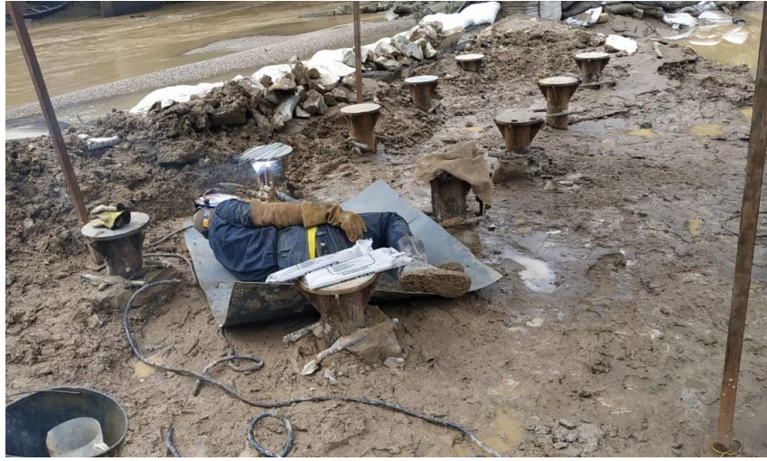
Imagen 9. Instalación de platinas Pila 2
