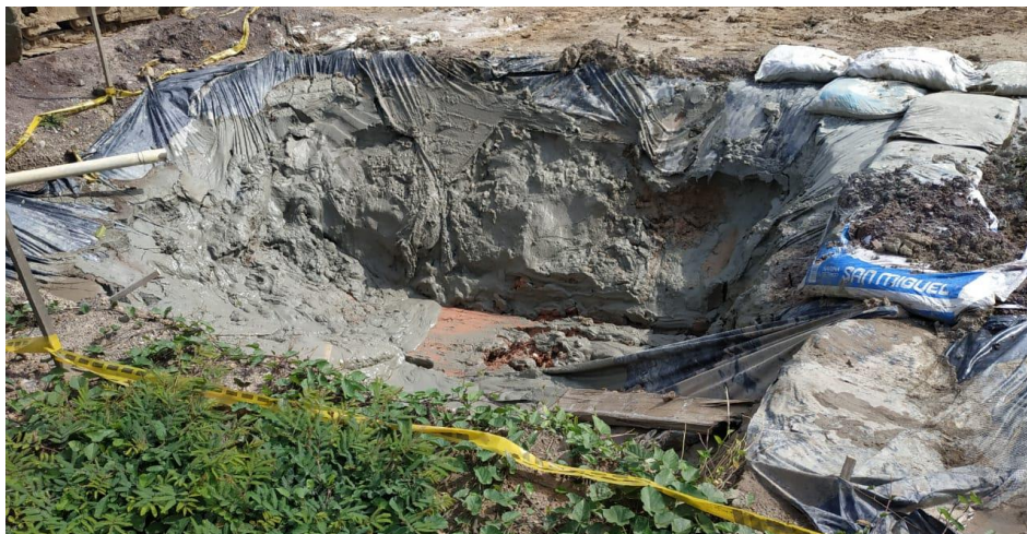
Imagen 11. Arreglo de piscinas de lodo, en total fueron 4 piscinas de 5 m 3
