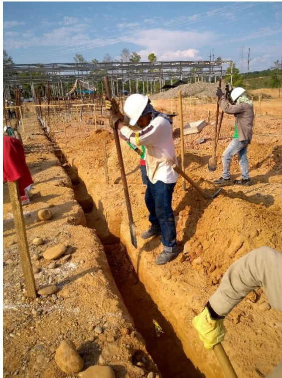
Imagen 11. Excavación manual.
