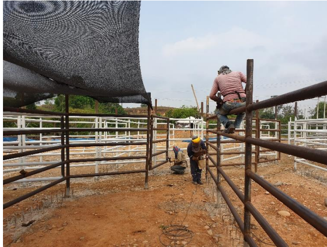
Imagen 18. Grateo de tubos.
