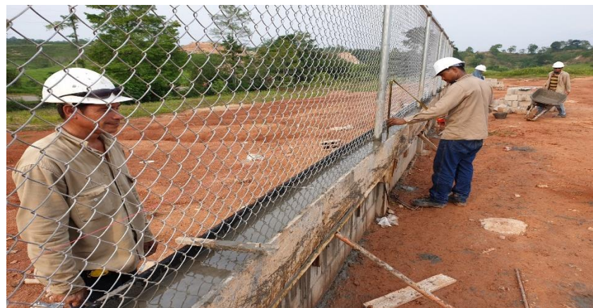
Imagen 26. Concreto de 3000 PSI para viga de riostra en el cerramiento.
