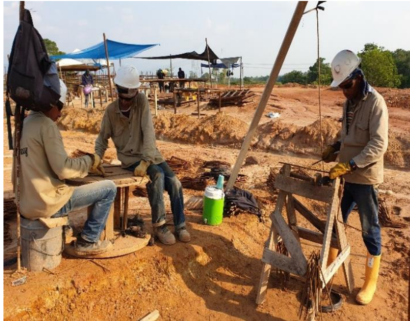
Imagen 10. Sector Corrales (Figuración de flejes para canal de drenaje).
