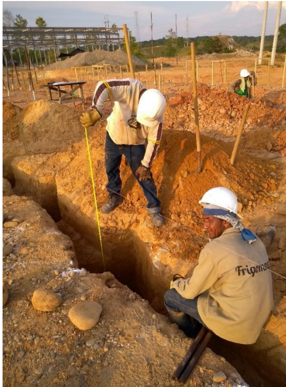
Imagen 12. Excavación manual de la zapata.
