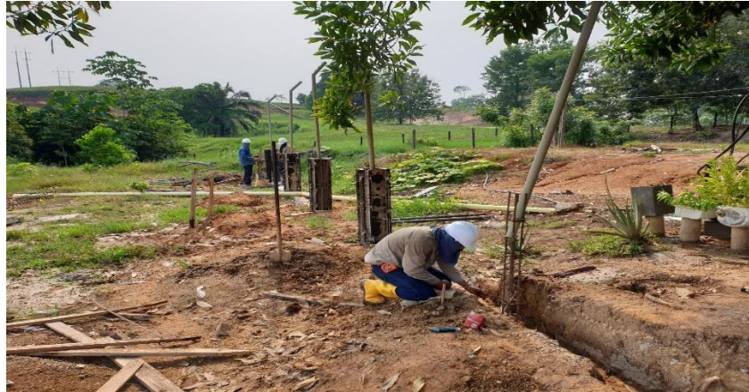
Imagen 25. Acero de refuerzo de cimentación.
