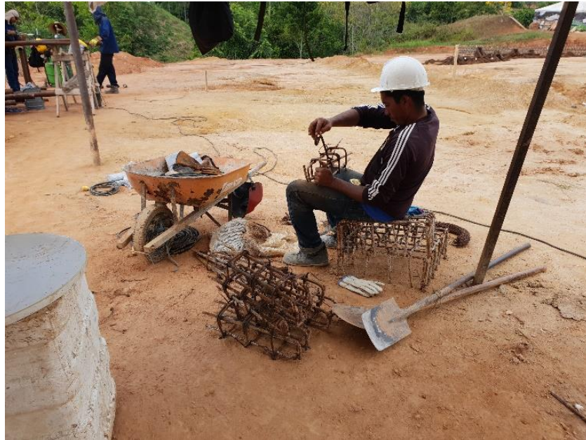
Imagen 15. Zapata y Vigas de Cimentación.
