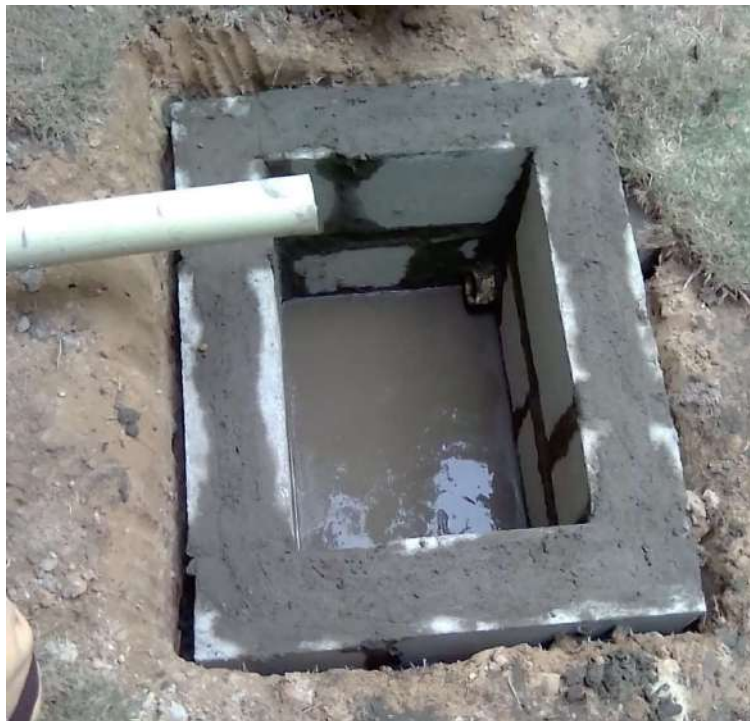
Foto 22. Construcción del pozo séptico
