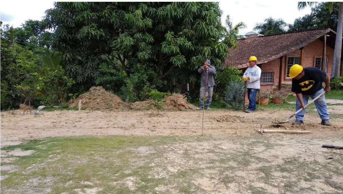
Foto 10. Actividad de localización y replanteo del laboratorio
