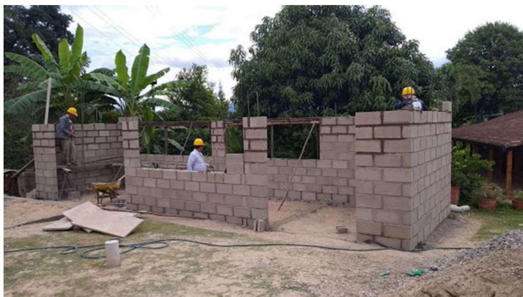
Foto 18. Construcción de muros en bloque estructural de cemento
