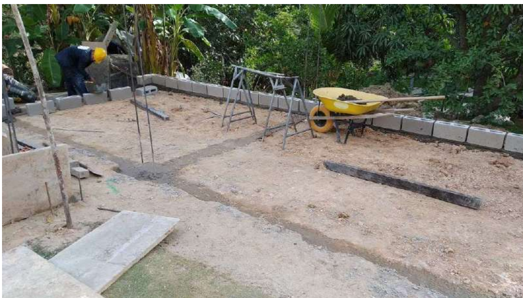
Foto 17. Construcción de muros en bloque estructural de cemento
