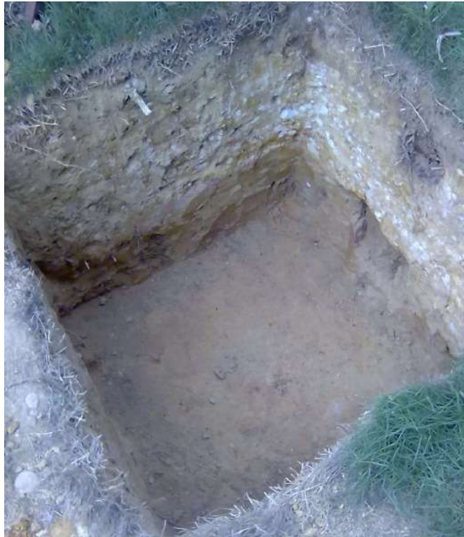
Foto 21. Excavación para pozo séptico
