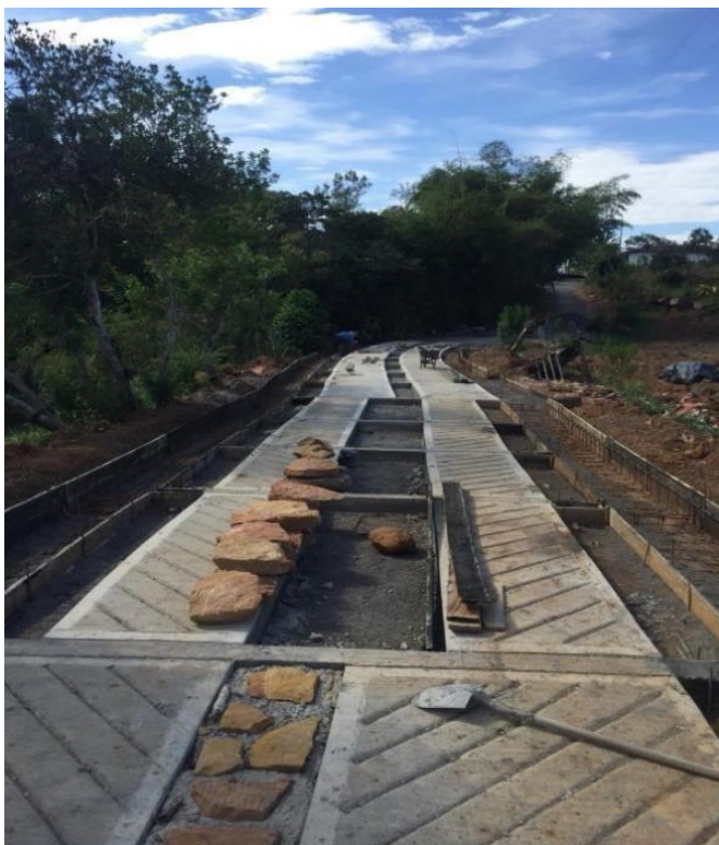
Figura 13. Tramo de placa huella en la vereda Aguafria. Fuente: Autor.
