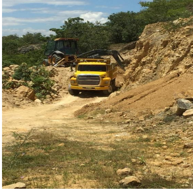
Figura 18. Recebada de las vías terciarias del municipio de Villanueva. Fuente: Autor.
