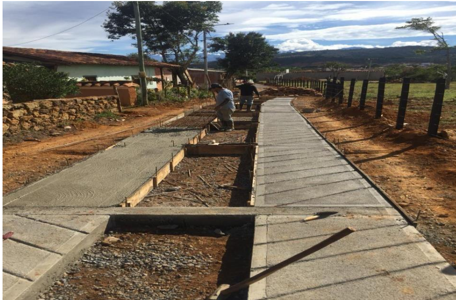
Figura 9. Construcción de placa huellas sector la gruta. Fuente: Autor.
