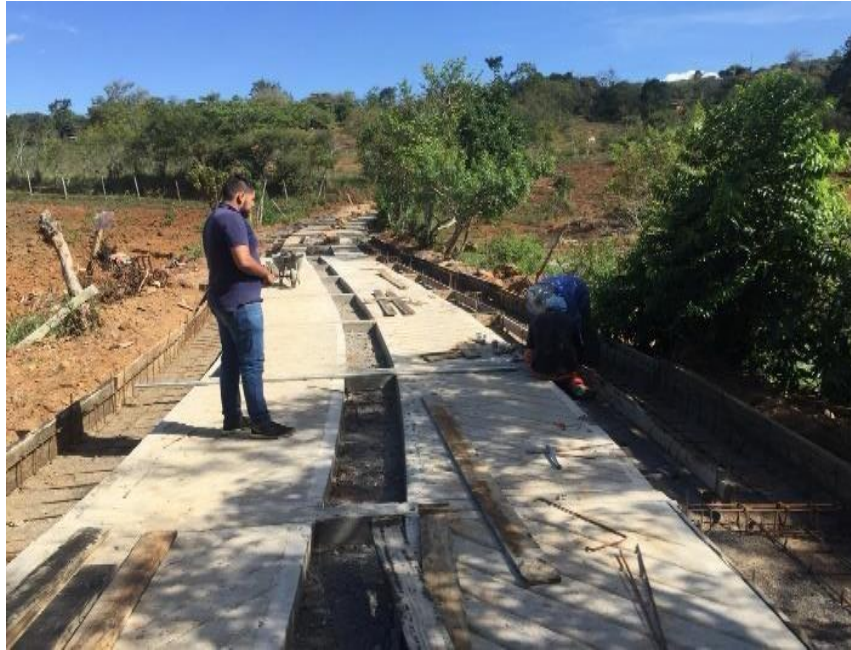
Figura 14. Tramo de placa huella en la vereda Aguafría. Fuente: Autor.
