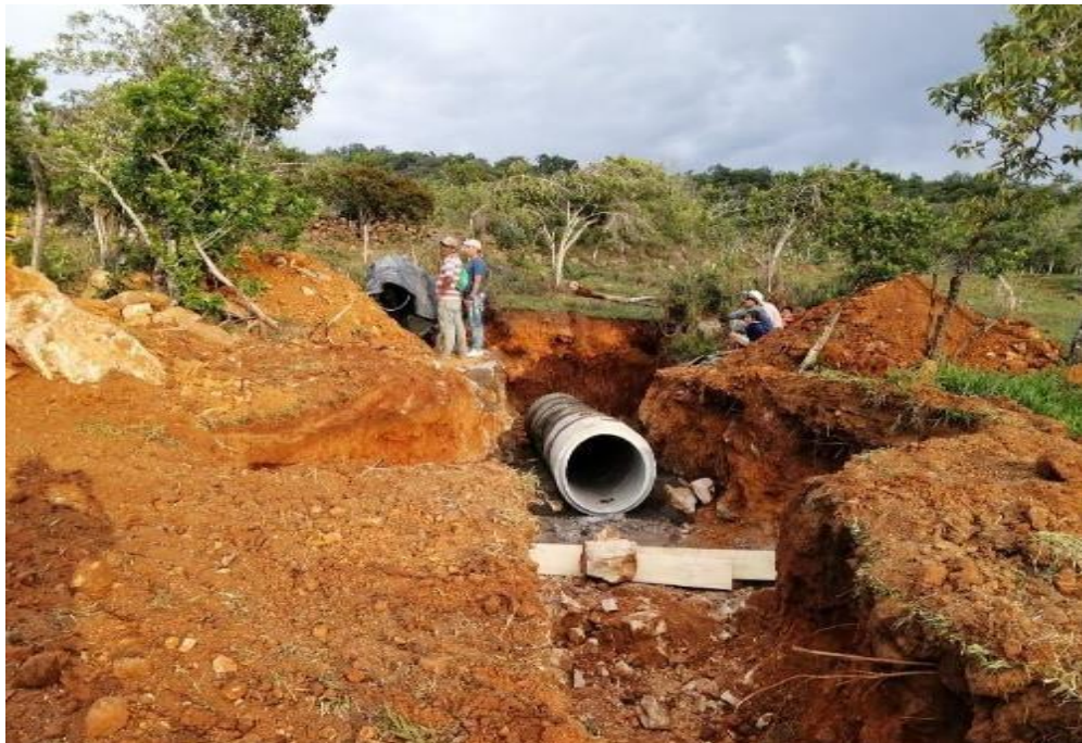
Figura 16. Trabajo de supervisión de instalación de tubería de alcantarillado rural. Fuente: Autor.
