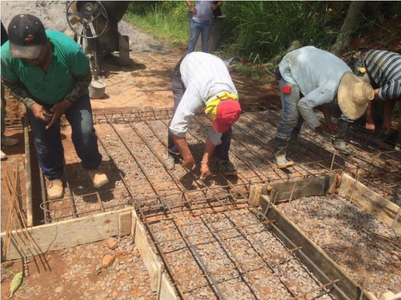
Figura 36. Supervisión de Placa Huella vereda Carrizal. Fuente: Autor.
