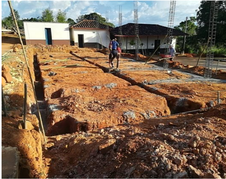
Figura 29. Cimentación escuela La Lajita. Fuente: Autor.
