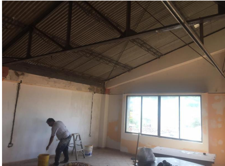
Figura 31. Pintura Auditorio Menor. Fuente: Autor.
