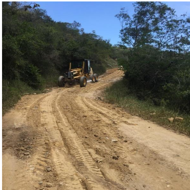
Figura 19. Recebada de las vías terciarias del municipio de Villanueva. Fuente: Autor.
