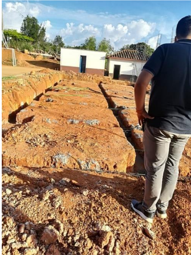
Figura 28. Cimentación escuela La Lajita. Fuente: Autor.
