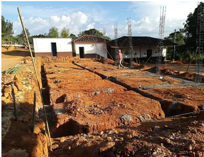
Figura 30. Cimentación escuela La Lajita. Fuente: Autor.
