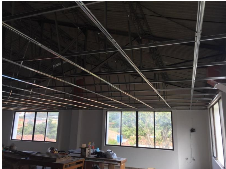
Figura 32. Instalación de Cielo Raso Auditorio menor. Fuente: Autor.
