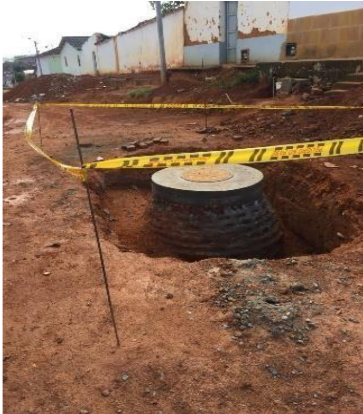
Figura 21. Construcción de pozos sépticos en la carrera 16 con calle 14 del municipio de Villanueva. Fuente: Autor.
