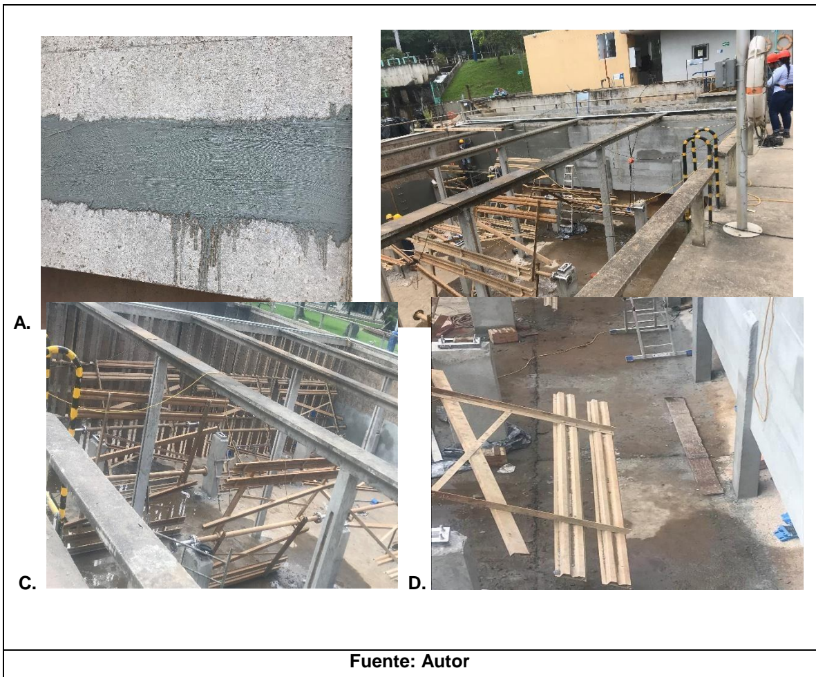
Figura 12. Aplicación del impermeabilizante en muros de canales y floculadores
