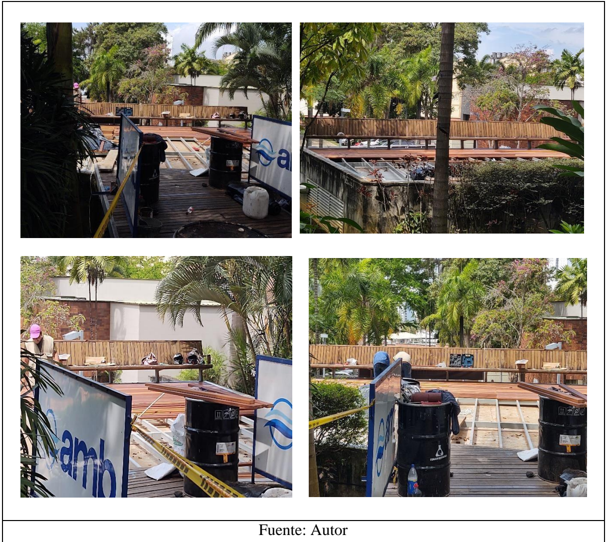
Figura 22. Instalación de listones de madera
