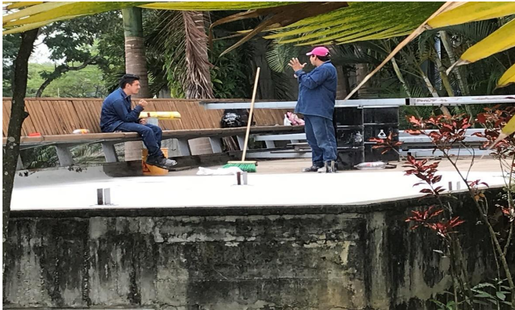
Figura 21. Aplicación del SikaLastic para proteger la cubierta de humedades
