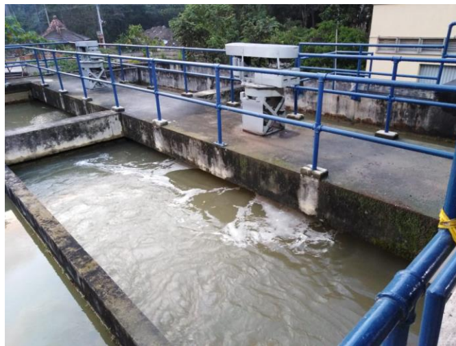
Figura 2. Floculador. Fuente. Autores
