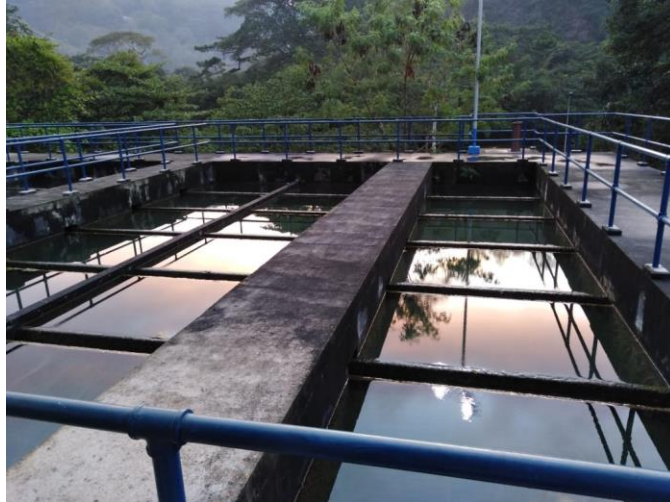
Figura 3. Sedimentador Número 4 Fuente. Autores
