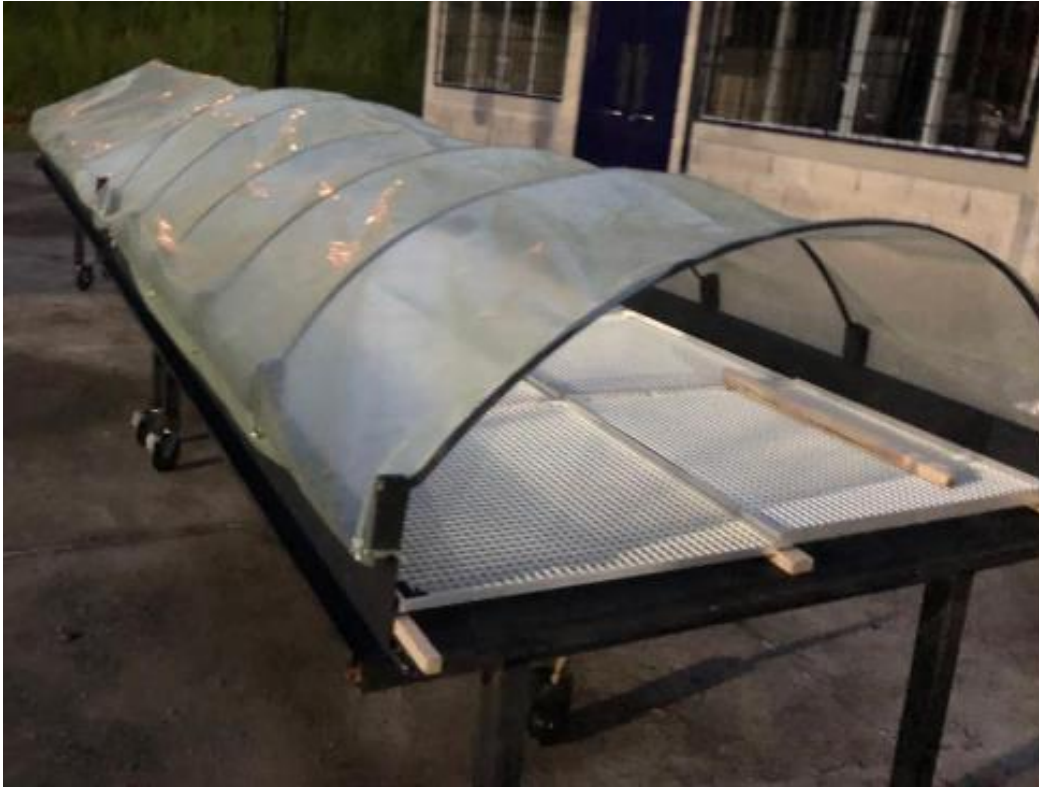
Figura 36. Instalación del plástico efecto invernadero.
