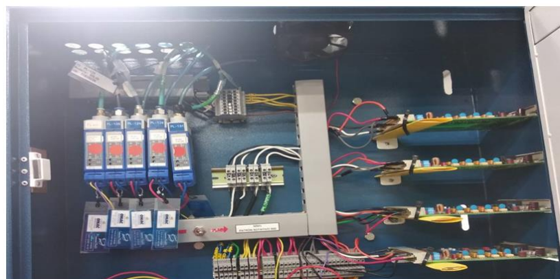
Instalación de nuevo amplificador para independizar la señal de los patrones.
