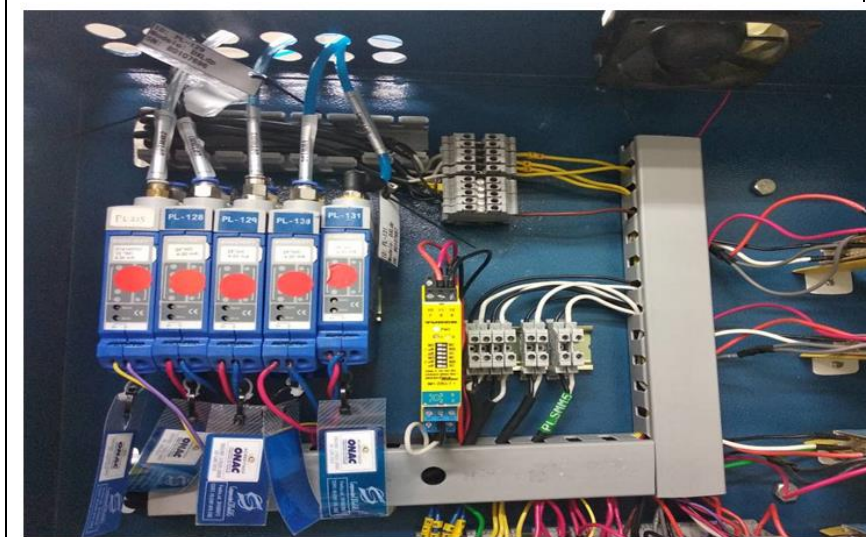
Instalación de nuevo amplificador para independizar la señal de los patrones.
