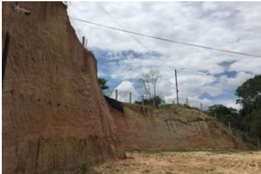
Figura 37. Panorámica del talud
