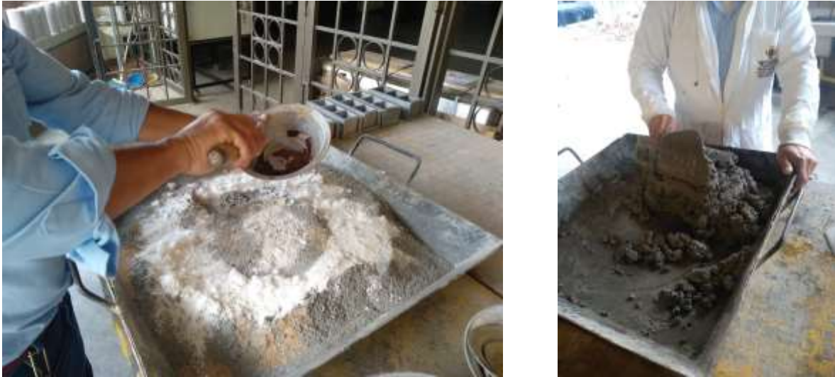
Figura 27. Mezcla de mortero
