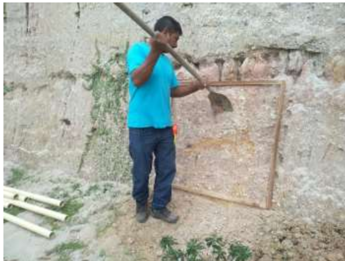
Figura 39. Armado de marcos y perfilado del talud
