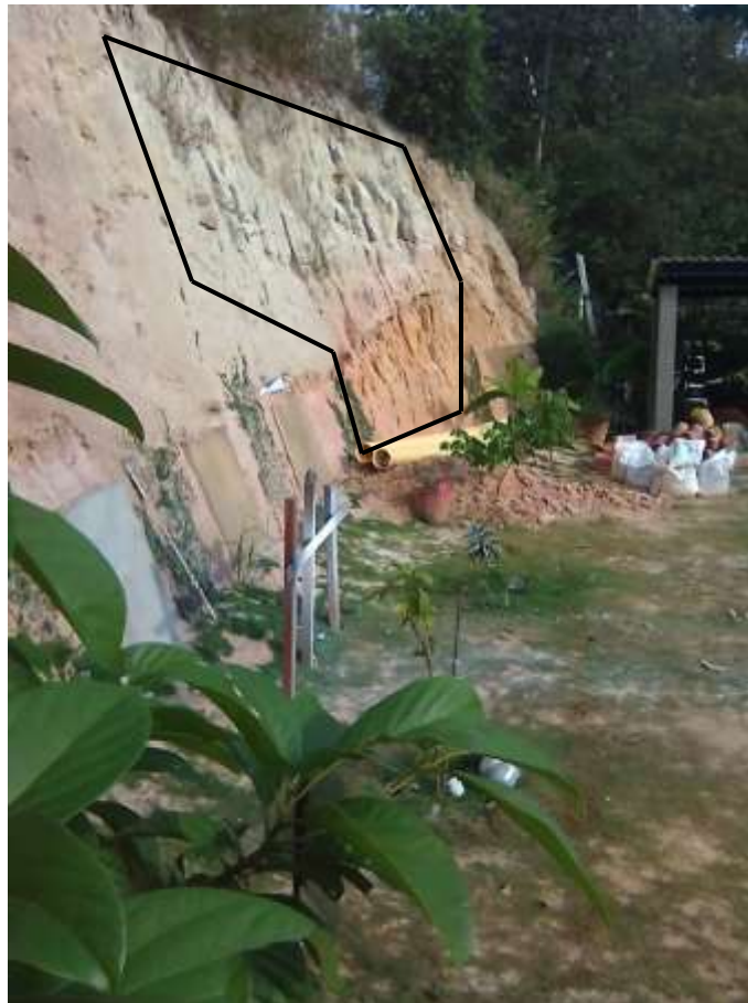
Figura 43. Panorámica final del talud
