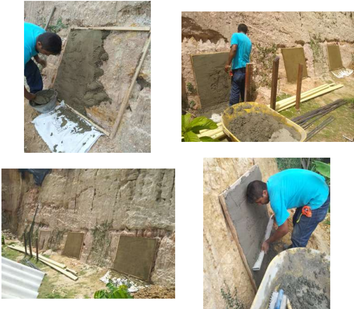
Figura 41. Proyección del mortero en el talud
