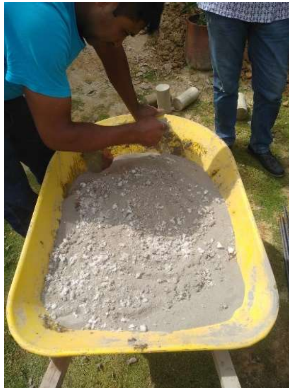
Figura 40. Mezclado de materiales del mortero
