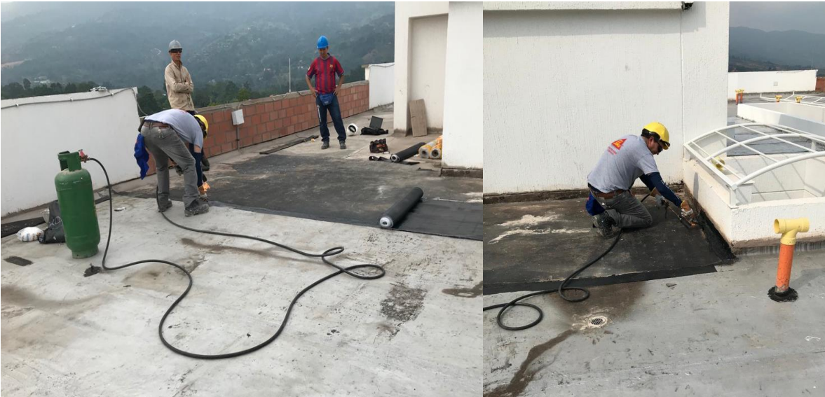
Figura 13. a) Aplicación de muestra en sitio de manto asfáltico para sistema de impermeabilización en obra nueva. b) Adecuación de medias cañas de la cubierta haciendo uso del manto asfáltico.
