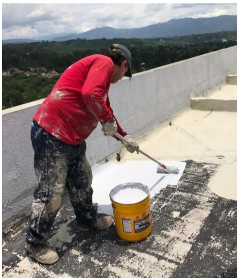
Figura 38. Aplicación de sistema de impermeabilización en poliuretano (Sikalastic® 612).
