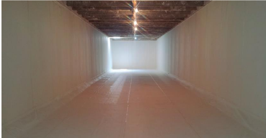
Figura 30. Impermeabilización de tanque de almacenamiento de agua potable con membrana de PVC.
