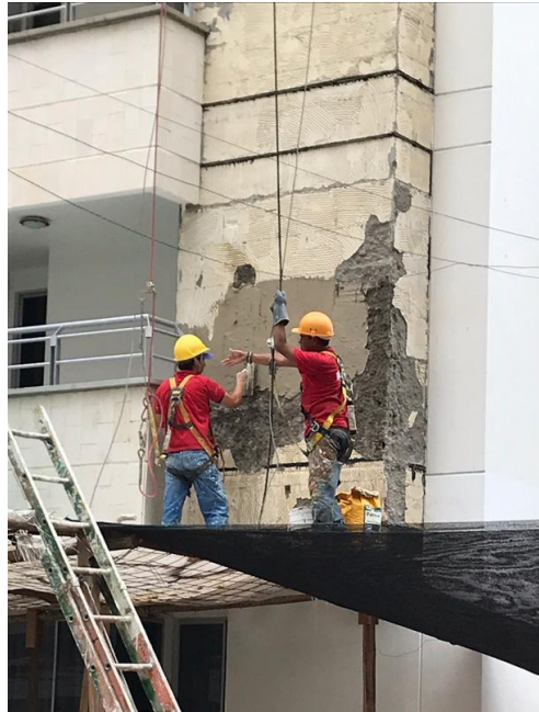
Figura 41. Reparación del sustrato o soporte en fachada.
