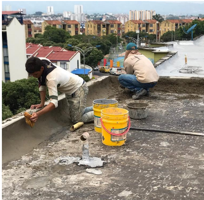
Figura 37. Construcción de medias cañas.
