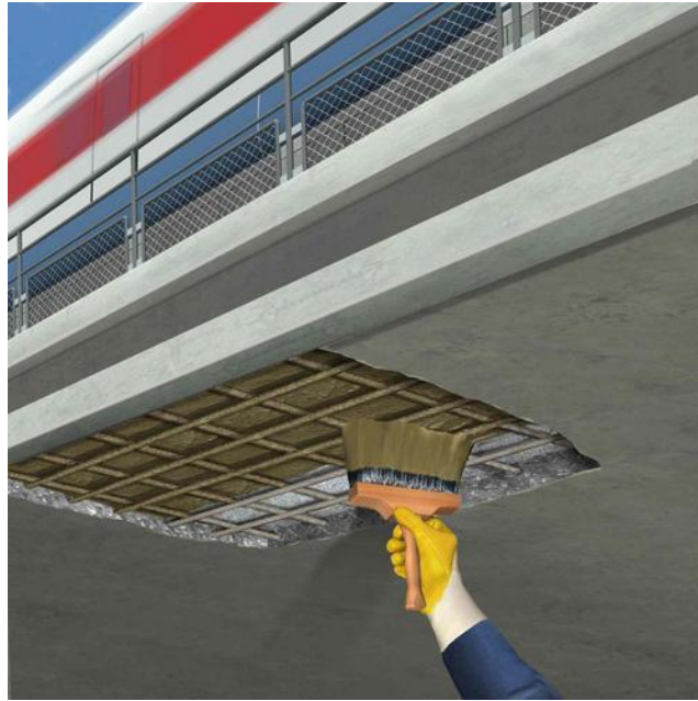
Figura 23. Aplicación de recubrimiento de protección en el acero de refuerzo.
