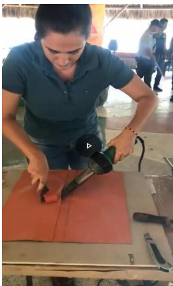
Figura 39. Unión de listones de membrana de PVC por termofusión.
