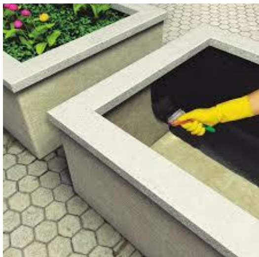
Figura 31. Impermeabilización de una jardinera.[8]
