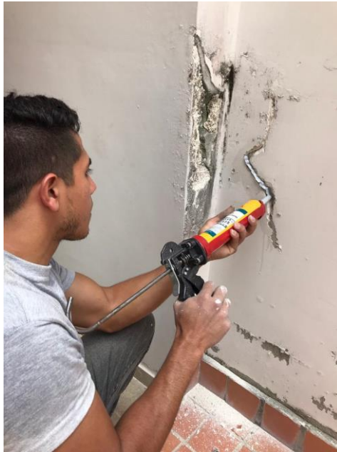
Figura 20. Procedimiento de sello de fisura en muro medianero.
