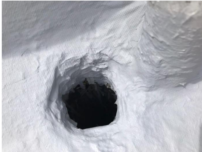
Figura 36. Emboquillado de sifones.
