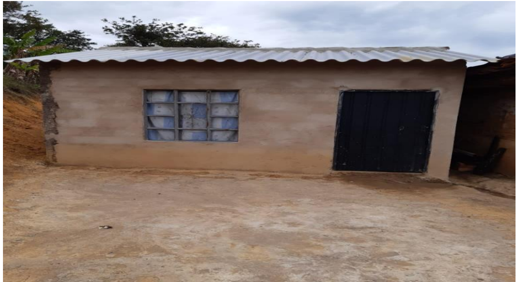
Figura 8.4. Mejoramiento vereda Semisa
