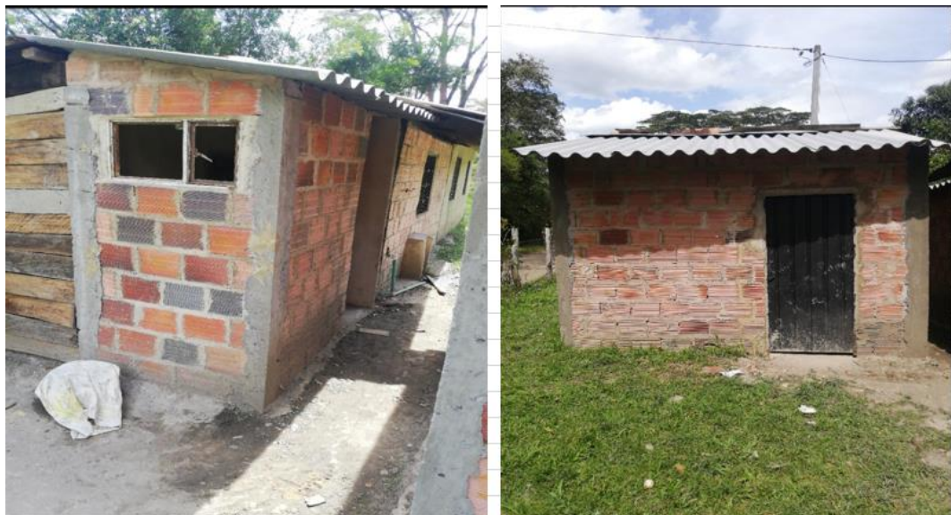
Figura 8.9. Mejoramiento vereda Rio Suarez
