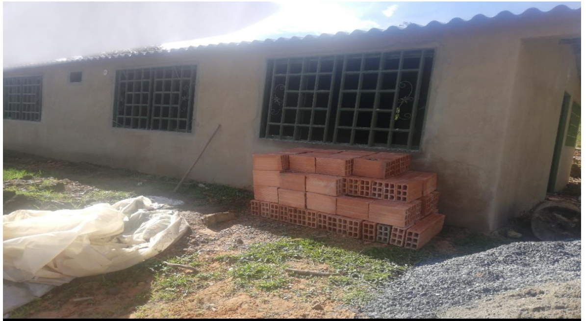
Figura 8.6. Mejoramiento vereda Jarantiva
