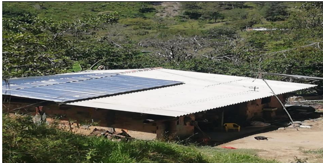
Figura 8.3. Mejoramiento vereda Iroba
