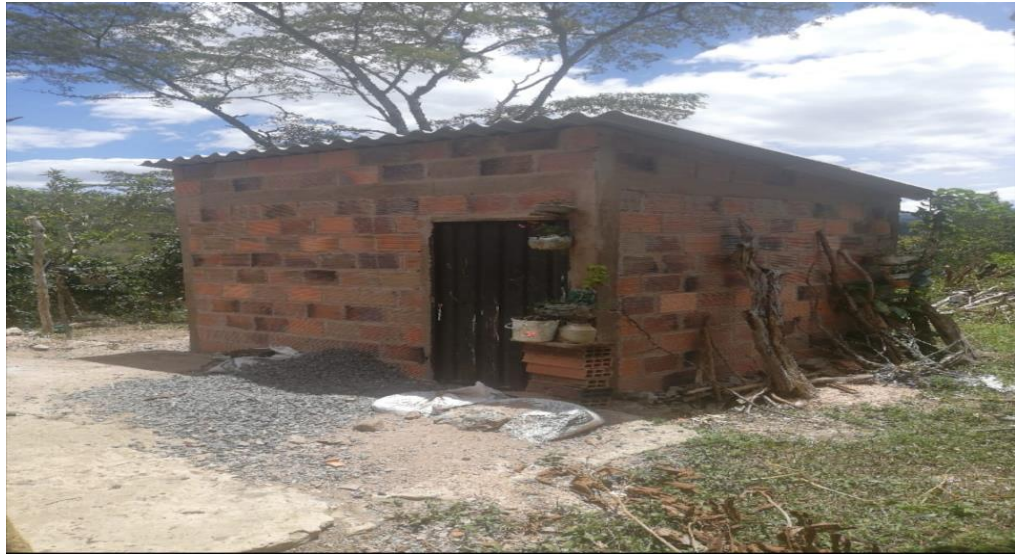
Figura 8.2. Mejoramiento vereda Iroba
