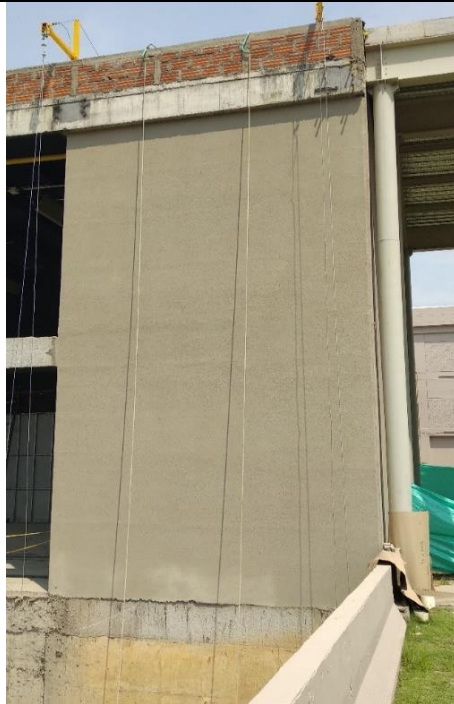
Ilustración 21. Aplicación Corever
