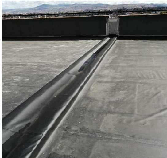
Ilustración 55 instalación de Euco membrana en canales
