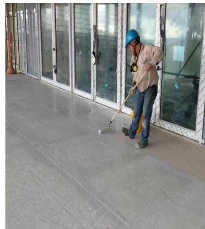
Ilustración 26. Segunda Mano de impermeabilización
