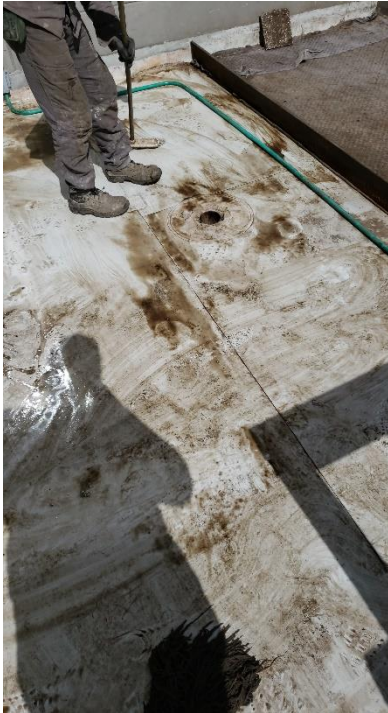
Ilustración 42. Limpieza Membrana
