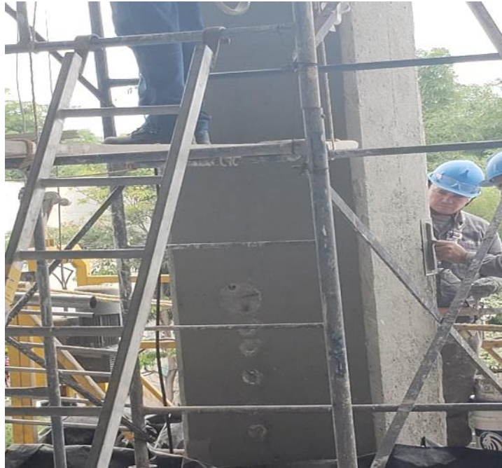
Ilustración 17. Regularización Superficie
