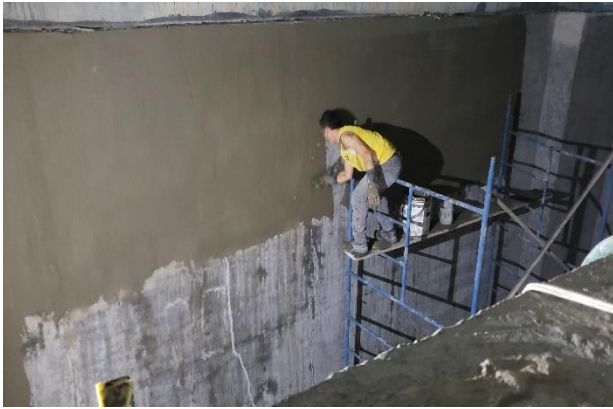
Ilustración 33. Impermeabilización Tanque 2
