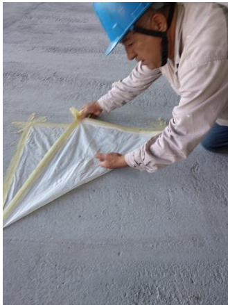
Ilustración 22. Inspección prueba de fraguado
