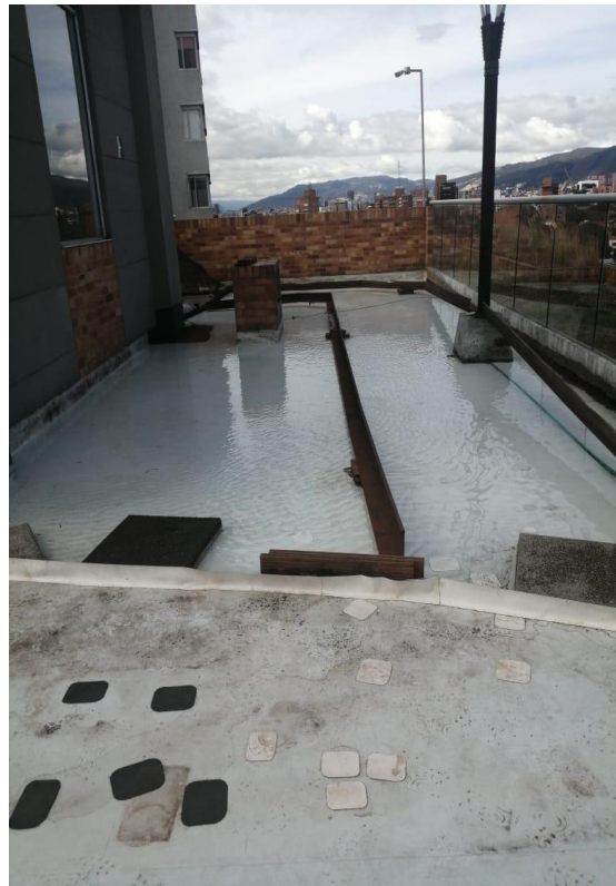
Ilustración 51. Prueba de Estanqueidad 2
