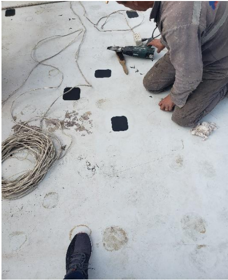
Ilustración 46. Arreglo Orificios
