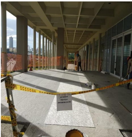
Ilustración 25. Impermeabilización Zona
