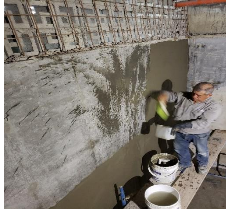
Ilustración 32. Impermeabilización tanque 1
