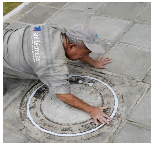
Ilustración 35. Sellamiento tapa exterior
