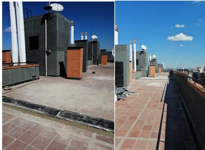
Ilustración 52 Adecuación de la superficie.
