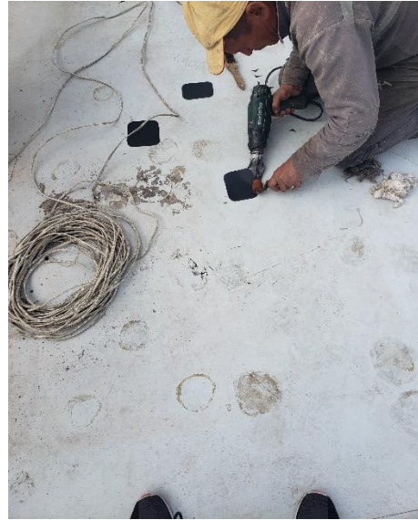
Ilustración 47. Parcheo membrana
