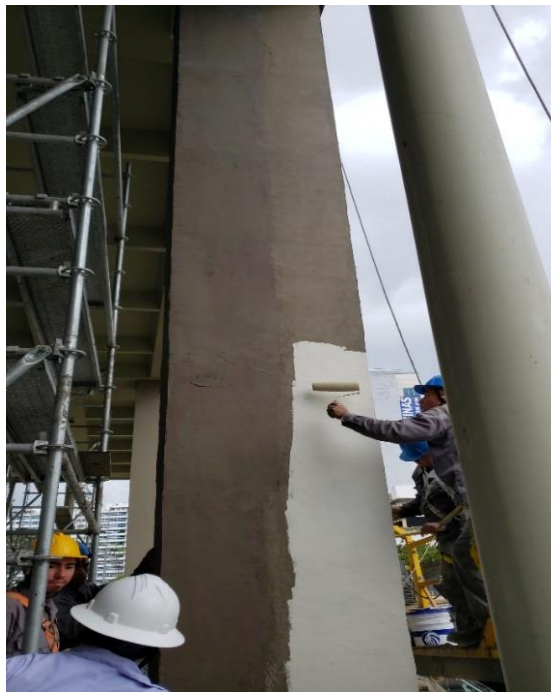
Ilustración 20. Aplicación Pintuprime
