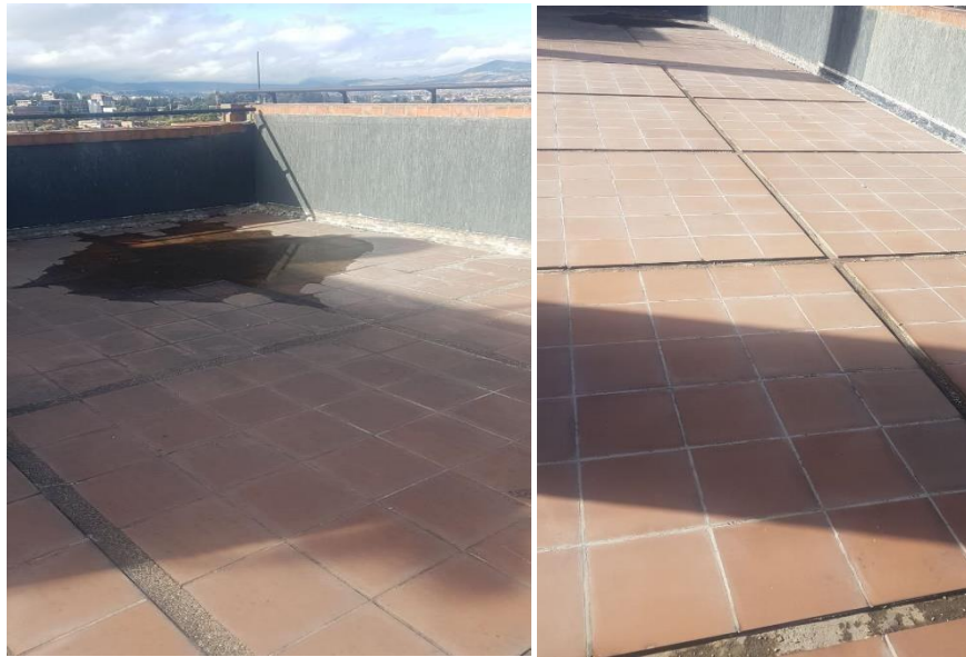
Ilustración 53 Nivelación de la superficie
