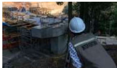
Fotografía 82: Nivelación de puente norte, fuente propia.
