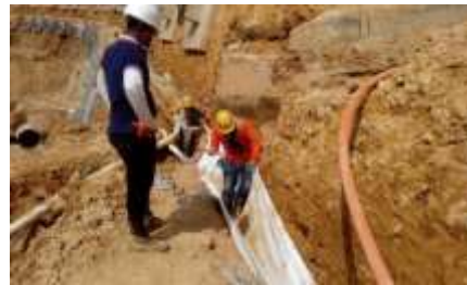
Fotografía 33: instalación tela para filtro, fuente propia.
