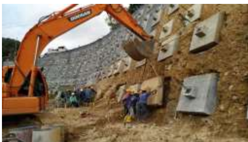
Fotografía 44: instalación de dado de anclaje, fuente propia.
