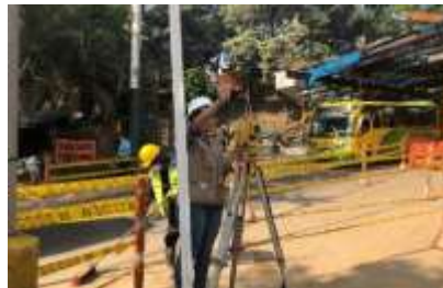
Fotografía 79: levantamiento de excavación, fuente propia.
