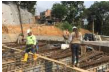
Fotografía 70: Seguimiento de fundida de vigas box culvert curvo, fuente propia.
