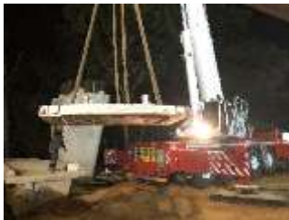
Fotografía 84 Ubicación de maquinaria para instalación de vigas del puente peatonal, fuente propia
