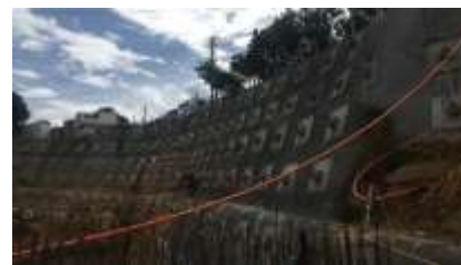
Fotografía 92 Finalización de talud de anclajes san Bernardo sección A, fuente propia.
