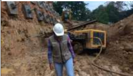
Fotografía 81: Control de procedimiento en talud de anclajes, fuente propia.
