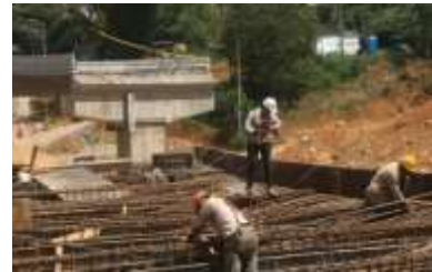
Fotografía 58: conteo de aceros vigas de cimentación en box culvert curvo, fuente
