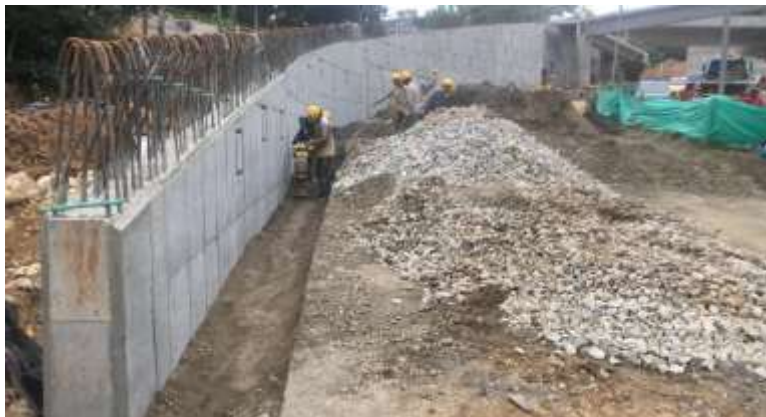
Fotografía 8: Muro de contención sur-occidental intercambiador Fátima, fuente propia.
