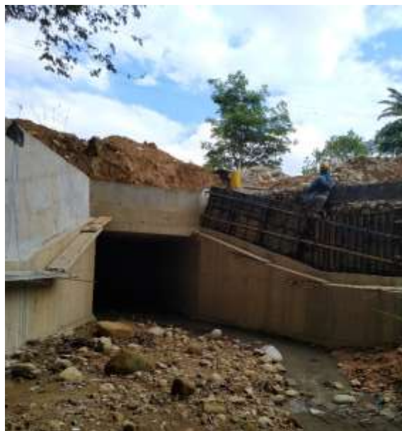
Fotografía 2 Box culvert, recolección de aguas intercambiador
