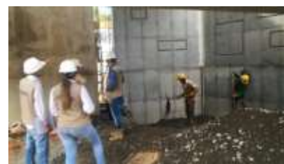
Fotografía 74: Relleno de muro de contención sur occidental, fuente propia.
