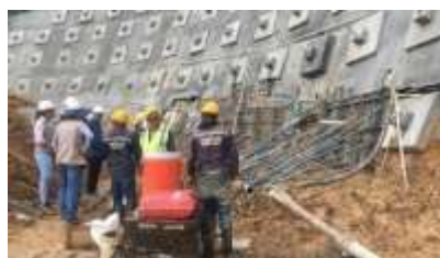
Fotografía 73: revisión de formaletas de recuperación de talud de anclajes, fuente propia.
