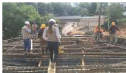
Fotografía 67: control de aceros box coulvert curvo, fuente propia.
