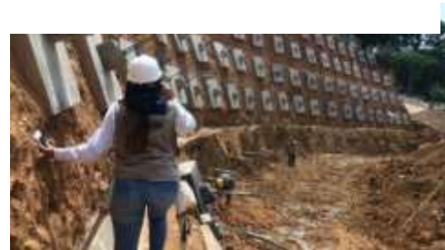
Fotografía 16: nivelación de anclajes, fuente propia.
