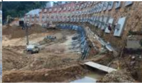
Fotografía 39 Canaleta final, fuente propia.
