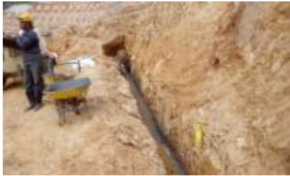
Fotografía 32: excavación de canaleta, fuente propia.
