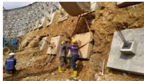
Fotografía 20: Instalación de dado de anclaje, fuente propia.
