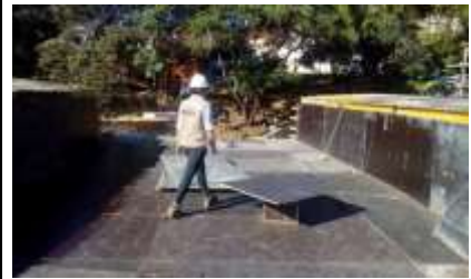
Fotografía 80: Revisión de instalación de fenólico puente norte, fuente propia.
