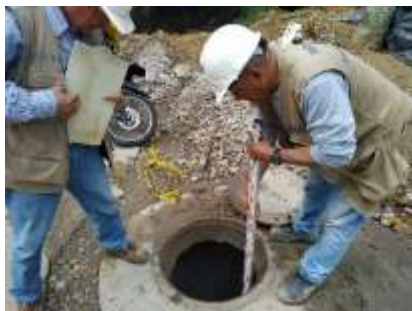
Fotografía 90 Revisión de pozos de inspección red de alcantarillado, fuente propia.
