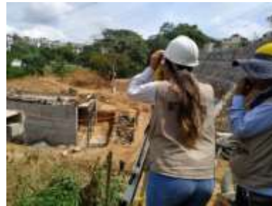
Fotografía 63: levantamiento de placa superior box culvert curvo, fuente propia.
