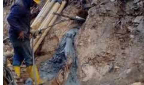
Fotografía 18: Llenado e inyectado de anclajes, fuente propia.
