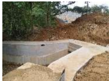
Fotografía 88 Fundida de gaviones, fuente propia.
