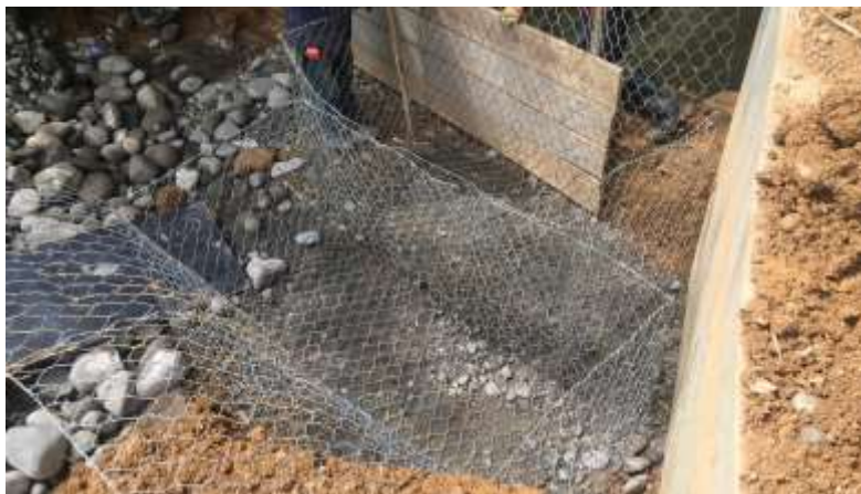
Fotografía 10: armado de cajón de gavión, fuente propia.
