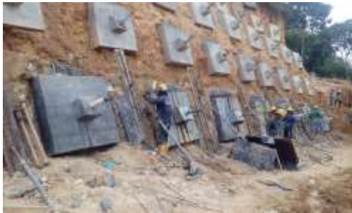
Fotografía 42: instalación de formaleta para sostener talud, fuente propia.
