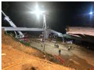
Fotografía 87: Instalación vigas puente peatonal, fuente propia
