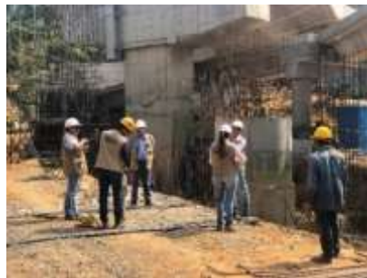
Fotografía 60: revisión aceros muro contención puente sur-occidental, fuente propia.
