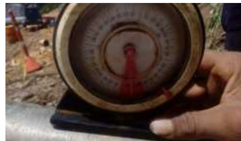
Fotografía 17: Revisión de inclinación de perforación para anclajes, fuente propia.
