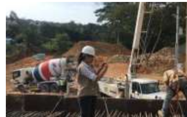
Fotografía 71: Registro de seguridad de trabajadores, fuente propia.
