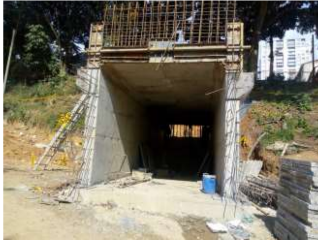
Fotografía 4: Box culvert peatonal, fuente propia.
