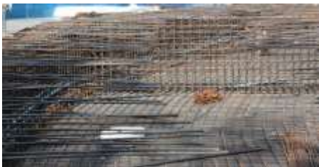
Fotografía 53: instalación de la viga adicional central dentro de la viga cajón
