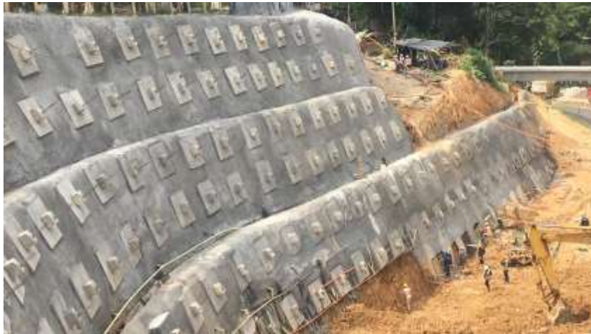
Fotografía 12: Unión de sector A y sector B talud de anclajes, fuente propia.
