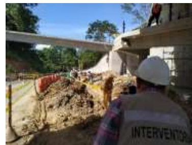
Fotografía 89 Nivelación de tubería de alcantarillado, fuente propia.
