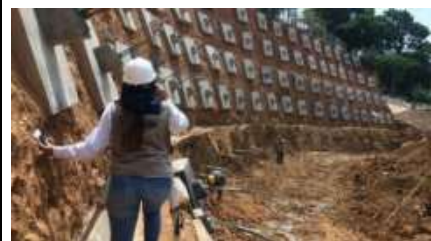
Fotografía 83: Nivelación de anclajes, fuente propia.
