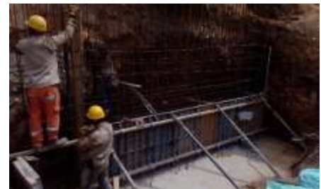
Fotografía 24 instalaciones aceros y formaletas para muros anclados, fuente propia.
