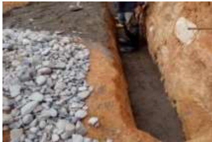
Fotografía 35: instalación de sub base, fuente propia
