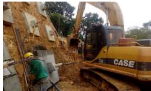
Fotografía 15 Perfilado de talud de anclajes, fuente propia.
