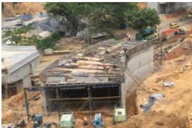
Fotografía 3 Box culvert vehicular intercambiador de Fátima, fuente propia.
