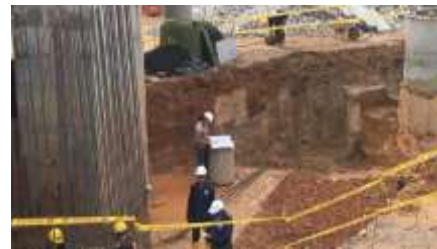
Fotografía 65: revisión de planos de muro de contención sur occidental, fuente propia.
