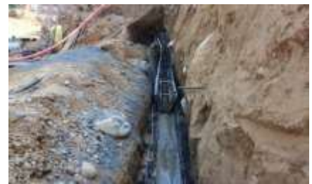
Fotografía 37: instalación de formaleta para canaleta, fuente propia.
