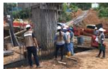
Fotografía 77: Revisión aceros muro de contención norte occidental, fuente propia.
