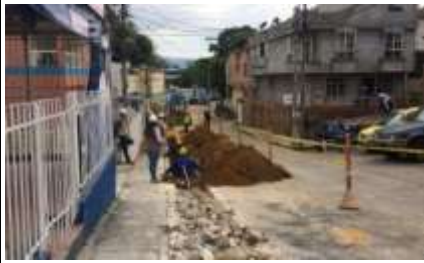
Fotografía 78: Control de instalación de tubería, fuente propia.
