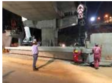
Fotografía 85 Arreglo de vigas puente peatonal, fuente propia.
