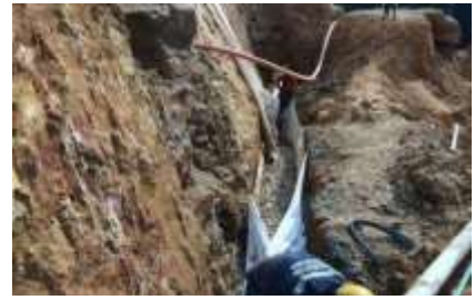
Fotografía 34 instalación de triturado, fuente propia.
