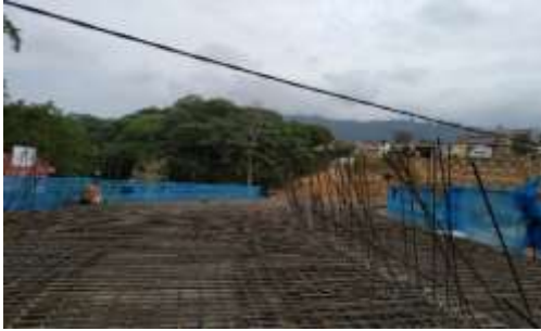
Fotografía 54: instalación de aceros de la placa superior
