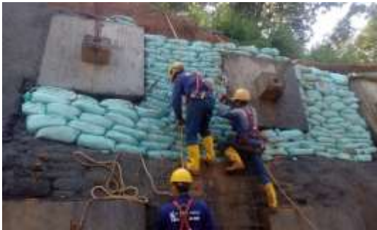
Fotografía 46: recuperación de terrazas con costales, fuente propia.
