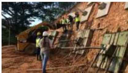
Fotografía 66: Seguimiento de fundida de anclajes, fuente propia.
