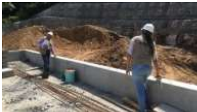
Fotografía 69: toma de medida de materia box culvert curvo, fuente propia.
