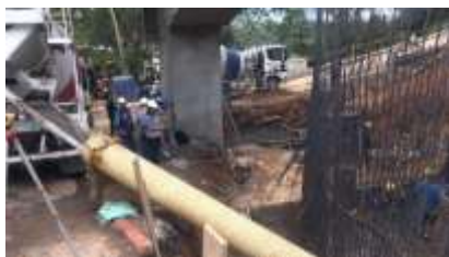
Fotografía 72: revisión fundida de zapata muro de contención oriental, fuente propia.
