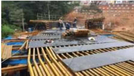
Fotografía 51: Instalación fenólico puente norte, fuente propia.
