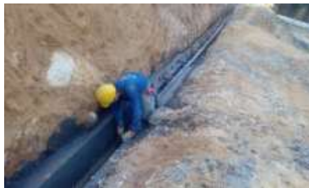
Fotografía 38 fundida de formaleta, fuente propia.
