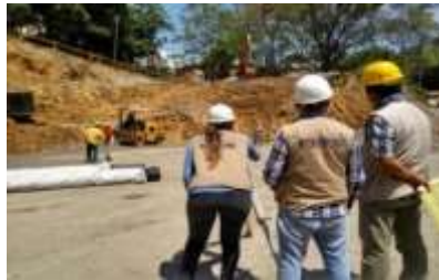
Fotografía 57: nivelación de capas instaladas de tierra armada, fuente propia.
