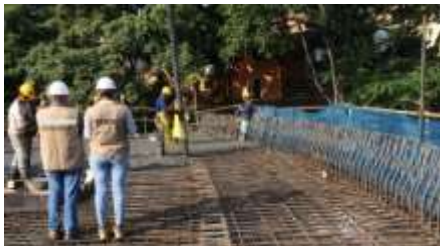
Fotografía 55: Fundida de placas superior e inferior puente norte, fuente propia.
