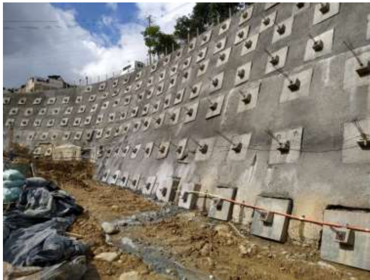
Fotografía 5: Talud de anclajes, fuente propia.
