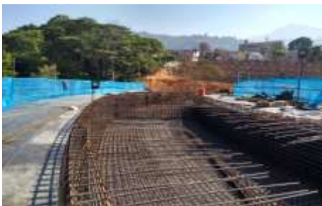
Fotografía 52. Instalación de los aceros de la placa inferior puente norte, fuente propia.
