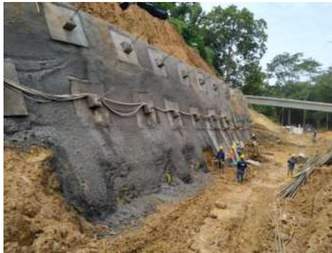
Fotografía 48 Entrega sección b talud de anclajes san Bernardo, fuente propia.
