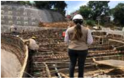
Fotografía 56: revisión de aceros box curvo, fuente propia.
