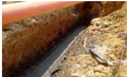
Fotografía 36: instalación de acero, fuente propia.
