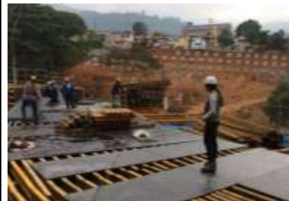
Fotografía 61: revisión de instalación de fenólico, puente norte, fuente propia.
