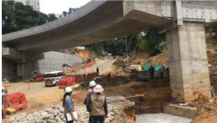
Fotografía 1 puente norte intercambiador de Fátima, fuente propia.
