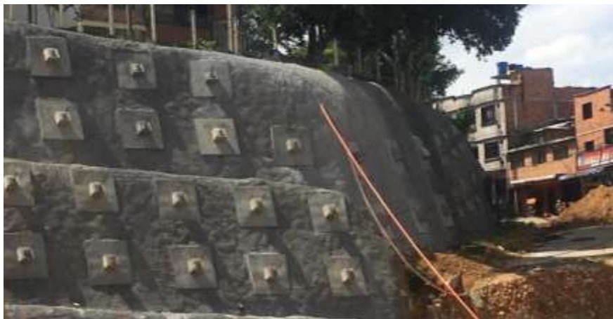
Fotografía 13: unión de sector A y C en talud de anclajes, fuente propia.
