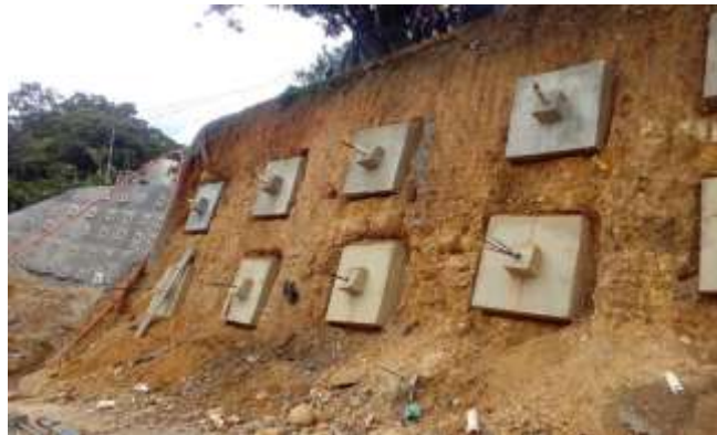
Fotografía 49: Entrega anclajes sección C talud de anclajes san Bernardo, fuente propia.
