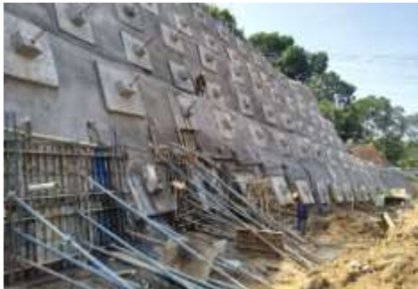
Fotografía 47 Sostenimiento de talud con instalación de mallas, fuente propia.
