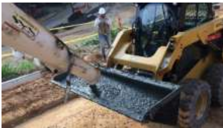
Fotografía 64: registro fotográfico de llegada y entrega de concreto, fuente propia.
