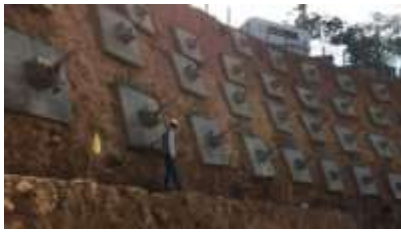
Fotografía 62: Revisión de canaleta terraza 2 talud de anclajes, fuente propia.
