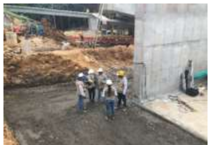
Fotografía 59: planeación con comisión de topografía del contratista, fuente propia.
