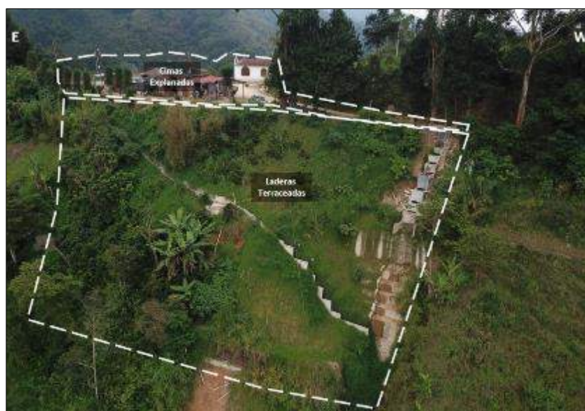
Fotografía 9. Obras de ingeniería y cimas explanadas localizadas al costado este del talud.
