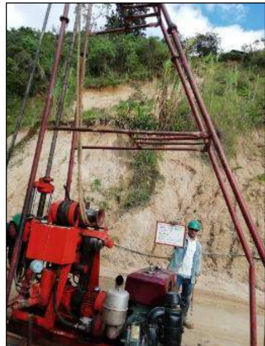
Fotografía 47. Avance de perforación con máquina de rotación
