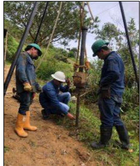
Fotografía 15. Demarcación de puntos de referencia para control de longitudes perforadas
