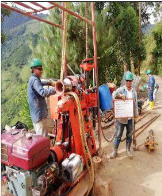
Fotografía 46. Inicio de perforación con máquina de rotación
