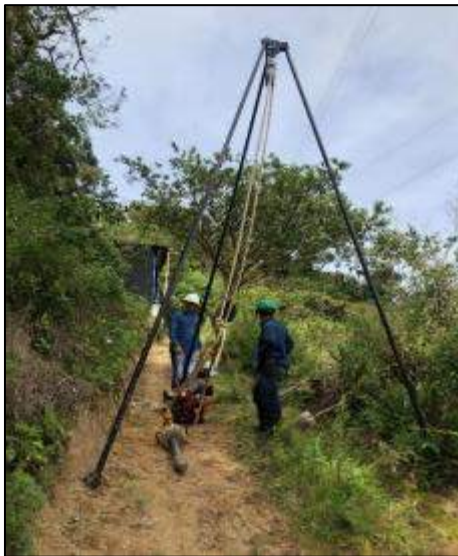
Fotografía 14. Demarcación de puntos de referencia para control de longitudes perforadas
