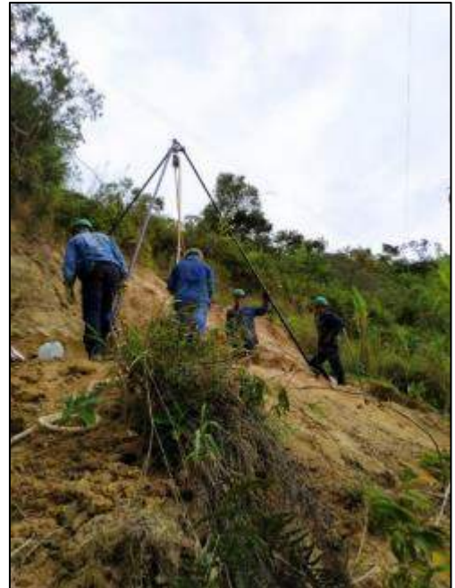
Fotografía 25. Adecuación del equipo de perforación en el punto designado
