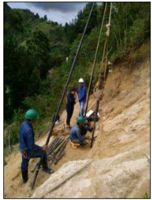
Fotografía 27. Avance en actividades de perforación con equipo SPT
