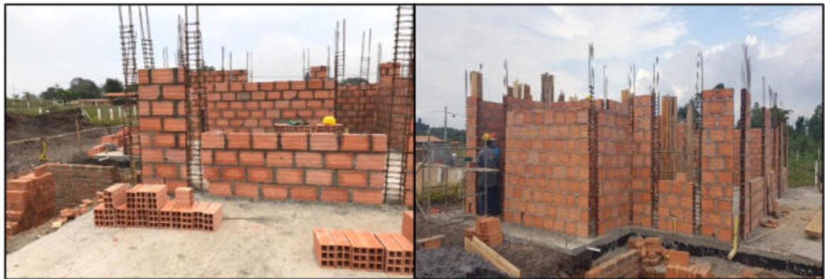
Ilustración 32. Mampostería casa 51 Fuente: Propia
