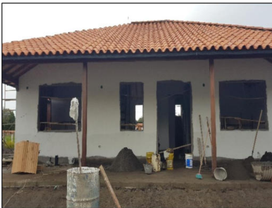
Ilustración 62. Primera mano de pintura casa 51 Fuente: Propia
