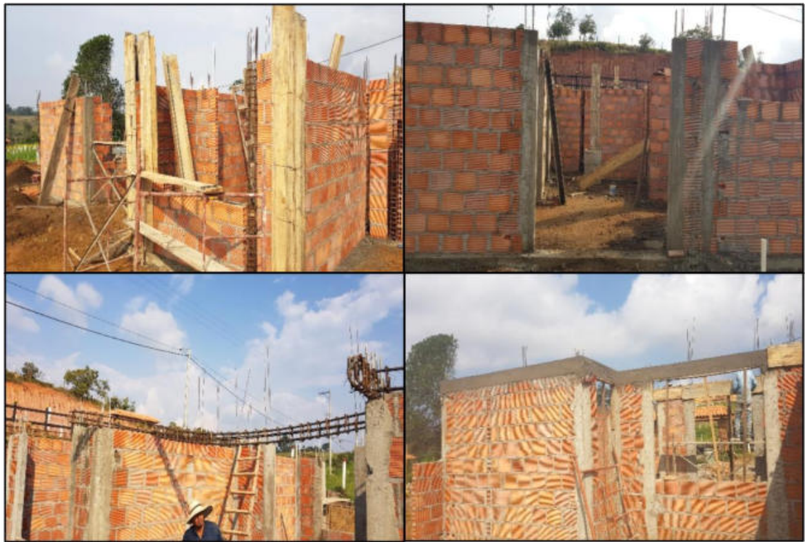
Ilustración 38. Columnetas y viga corona casa 294 Fuente: Propia
