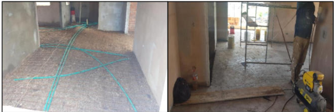
Ilustración 28. Fundida placa de contrapiso casa 51 Fuente: Propia
