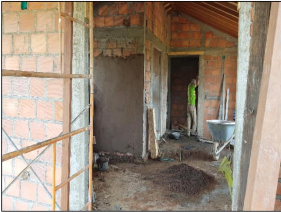
Ilustración 58. Mortero de nivelación casa 294 Fuente: Propia
