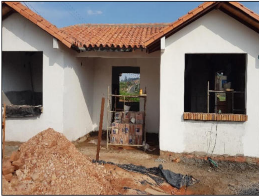
Ilustración 63. Primera mano de pintura casa 294 Fuente: Propia
