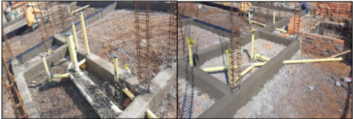
Ilustración 21. Instalación de tubería sanitaria casa 51 Fuente: Propia
