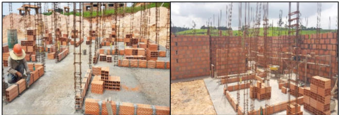
Ilustración 34. Mampostería casa 221 Fuente: Propia
