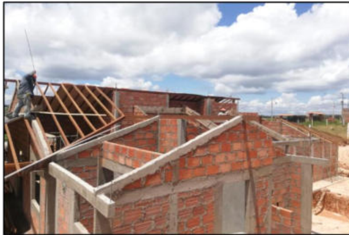
Ilustración 43. Viga cinta casa 221 Fuente: Propia
