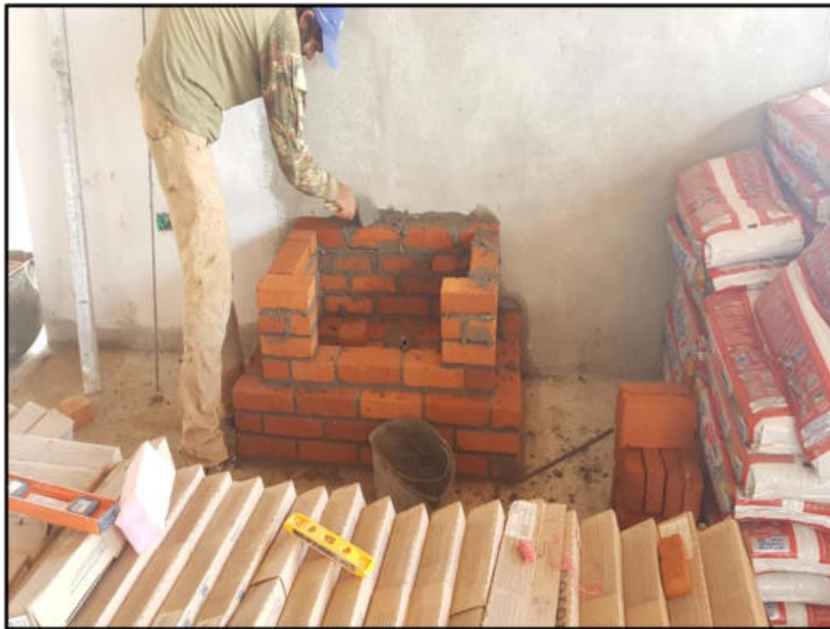
Ilustración 77. Arranque chimenea casa 221 Fuente: Propia
