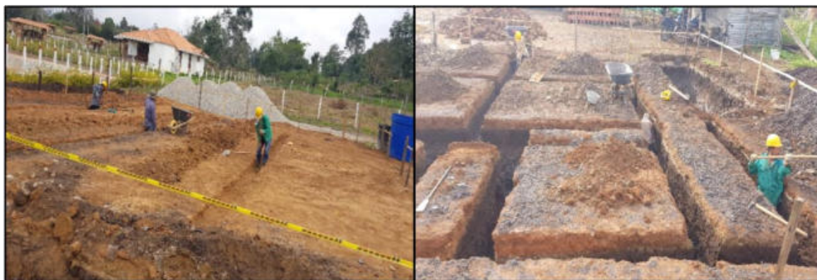
Ilustración 15. Excavaciones casa 51 Fuente: Propia
