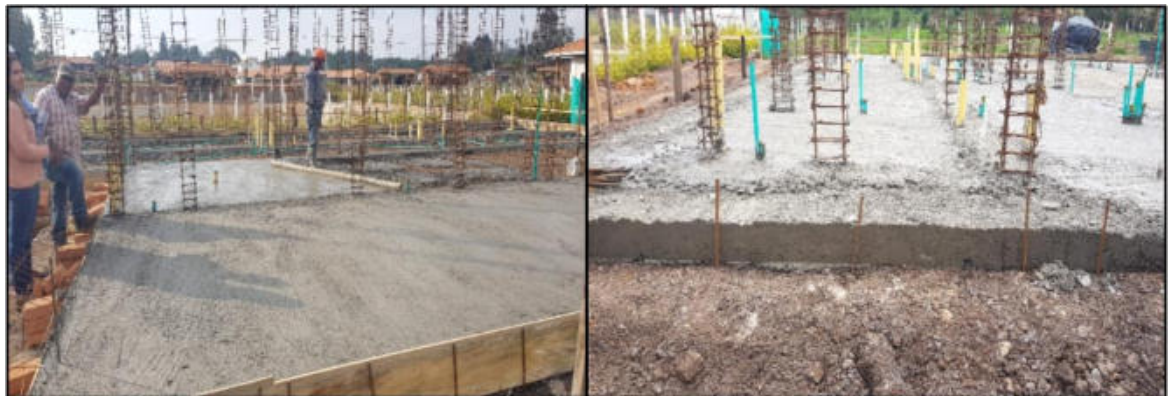
Ilustración 28. Fundida placa de contrapiso casa 51 Fuente: Propia
