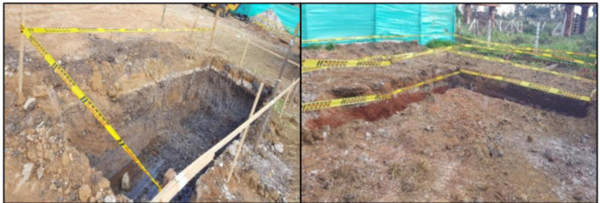
Ilustración 9. Demarcación y excavación tanque Subterráneo y PTAR casa 51 Fuente: Propia
