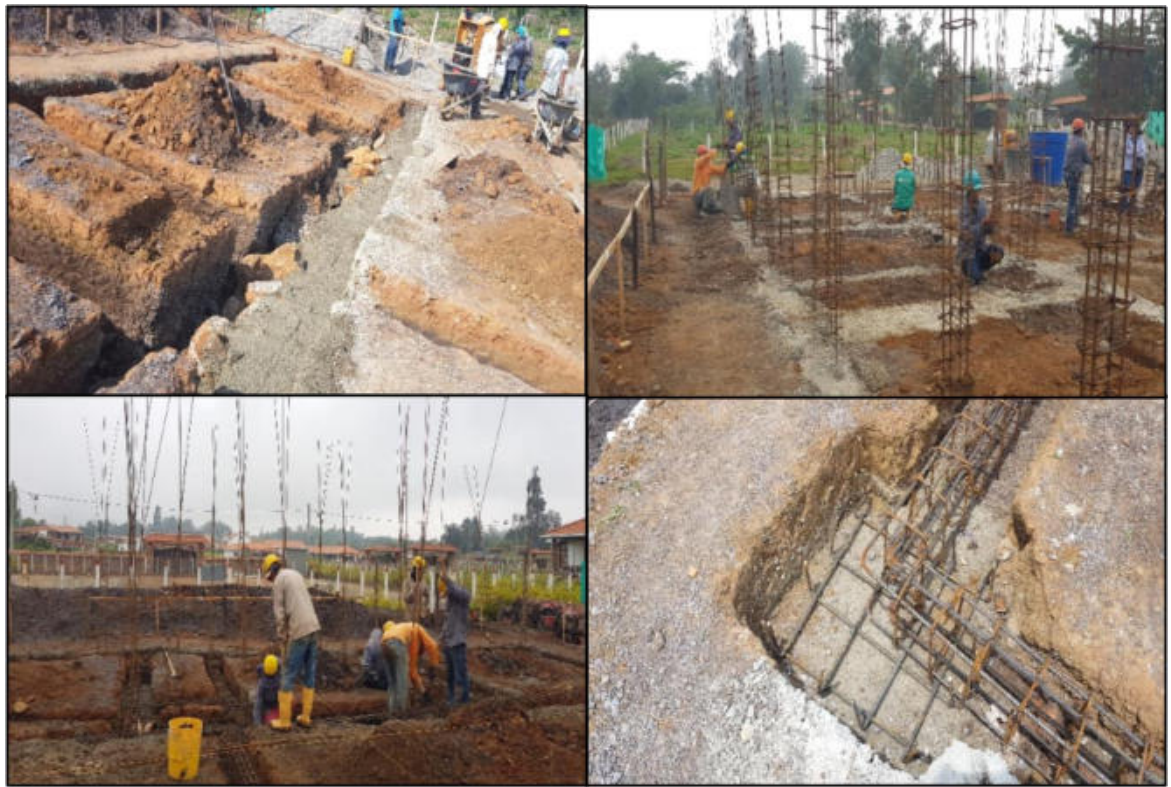
Ilustración 18. Fundida de ciclópeo, viga de cimentación y zapatas casa 51 Fuente: Propia
