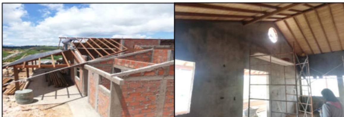
Ilustración 47. Estructura en madera y machihembrado casa 221 Fuente: Propia
