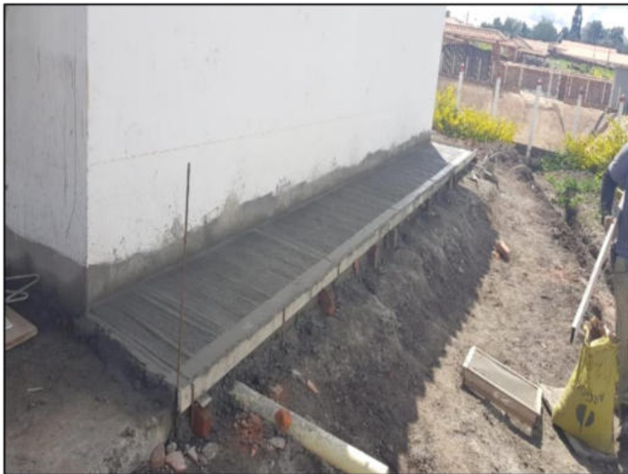
Ilustración 66. Fundida de andenes casa 51 Fuente: Propia
