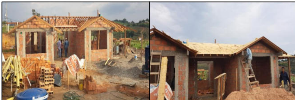
Ilustración 46. Estructura de madera y machihembrado casa 294 Fuente: Propia
