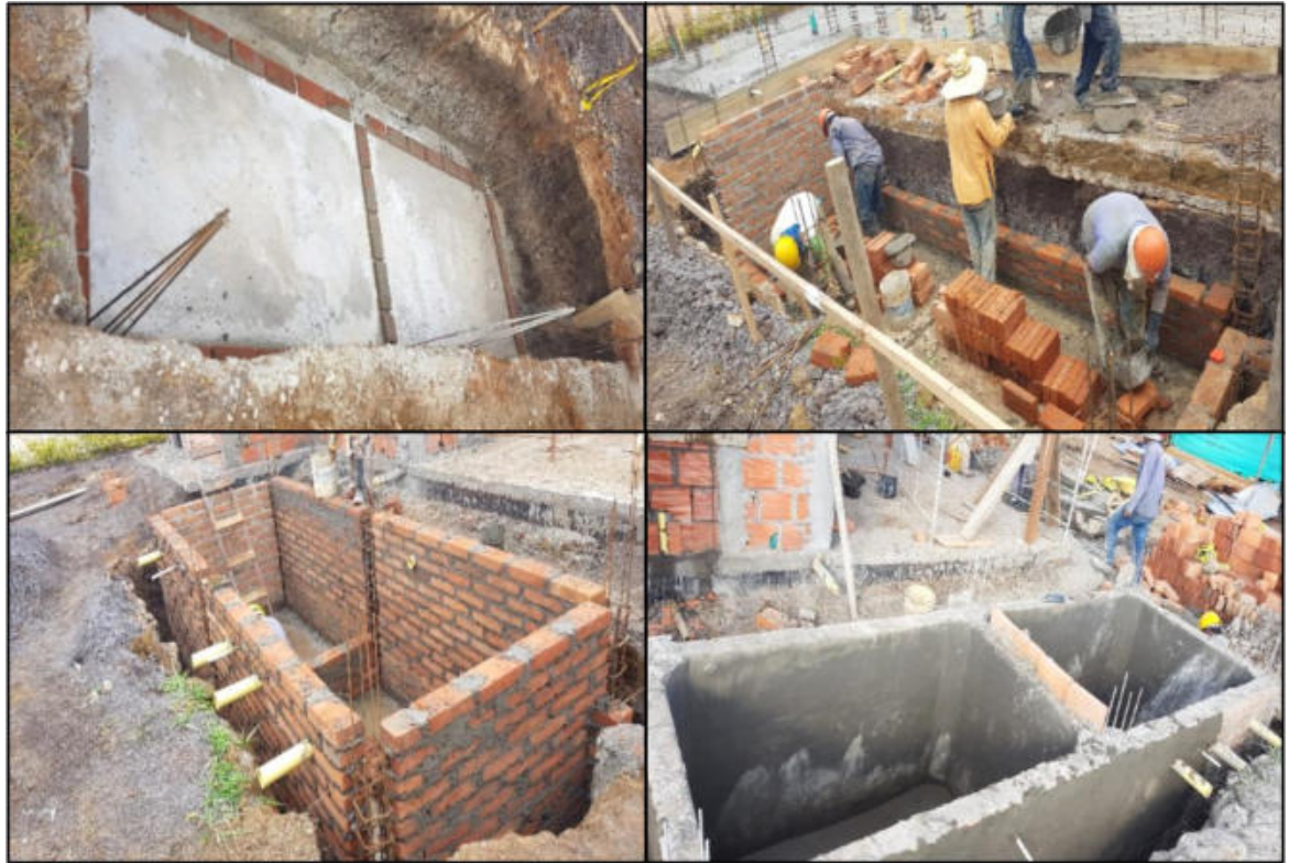
Ilustración 68. Tanque subterráneo casa 51 Fuente: Propia
