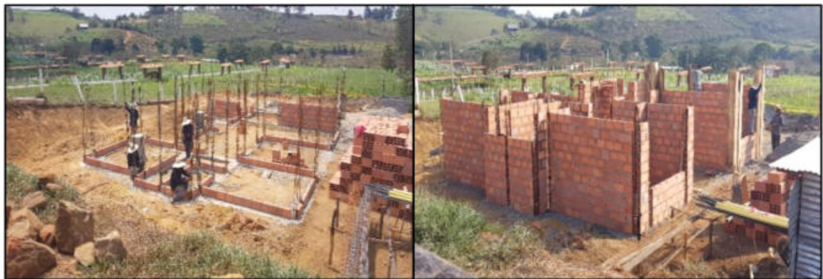
Ilustración 33. Mampostería casa 294 Fuente: Propia
