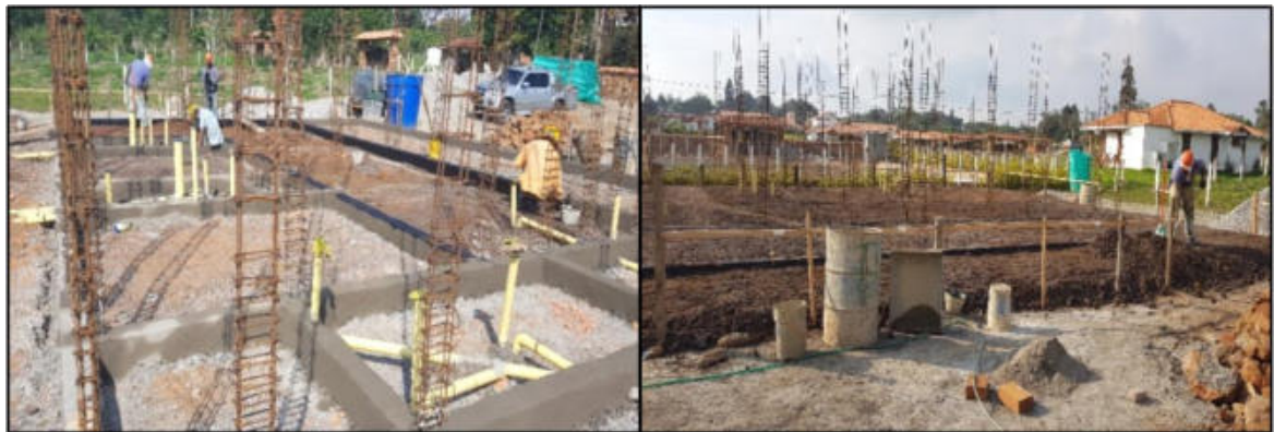
Ilustración 24. Sobrecimiento de dos hiladas de ladrillo temosa casa 51 Fuente: Propia
