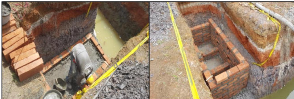
Ilustración 72. Ejecución PTAR casa 51 Fuente: Propia
