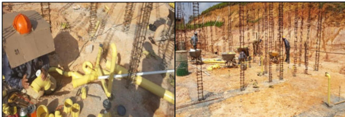
Ilustración 23. Instalación tubería sanitaria casa 221 Fuente: Propia
