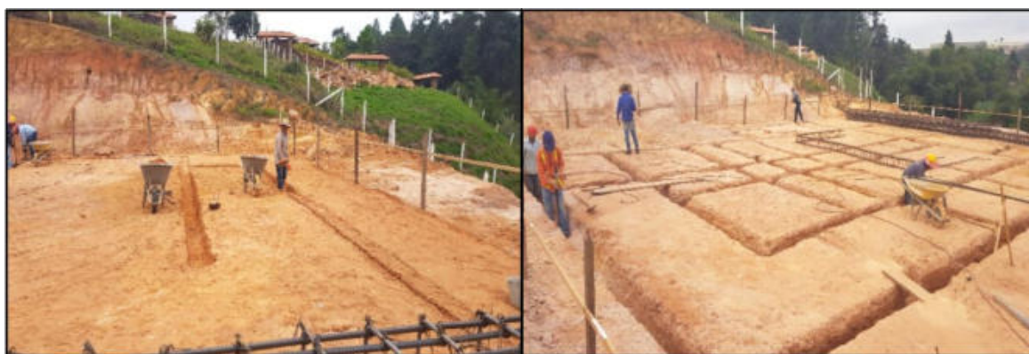
Ilustración 16. Excavaciones casa 221 Fuente: Propia
