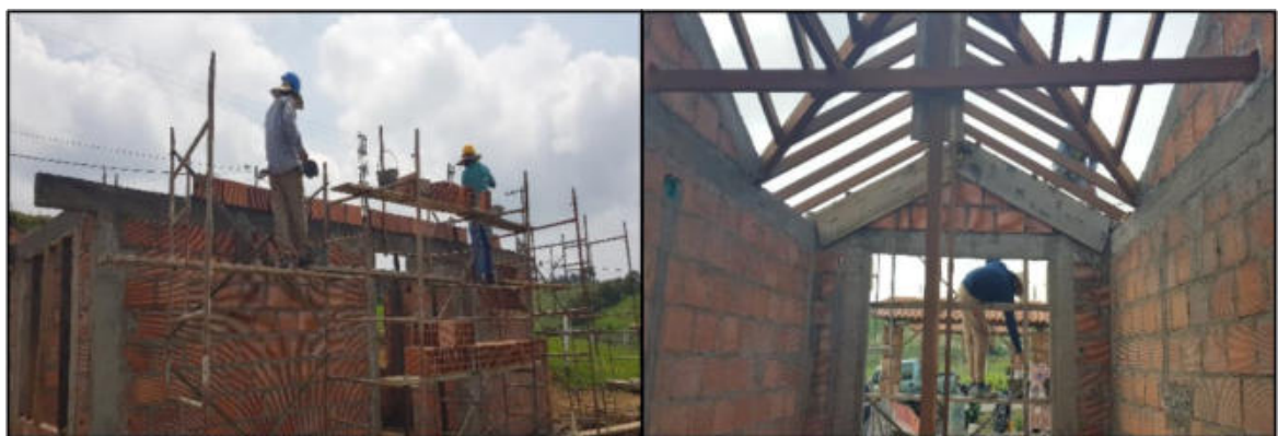
Ilustración 42. Cuchillas y viga cinta casa 294 Fuente: Propia
