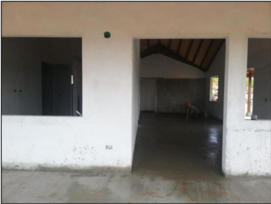
Ilustración 59. Mortero de nivelación casa 221 Fuente: Propia
