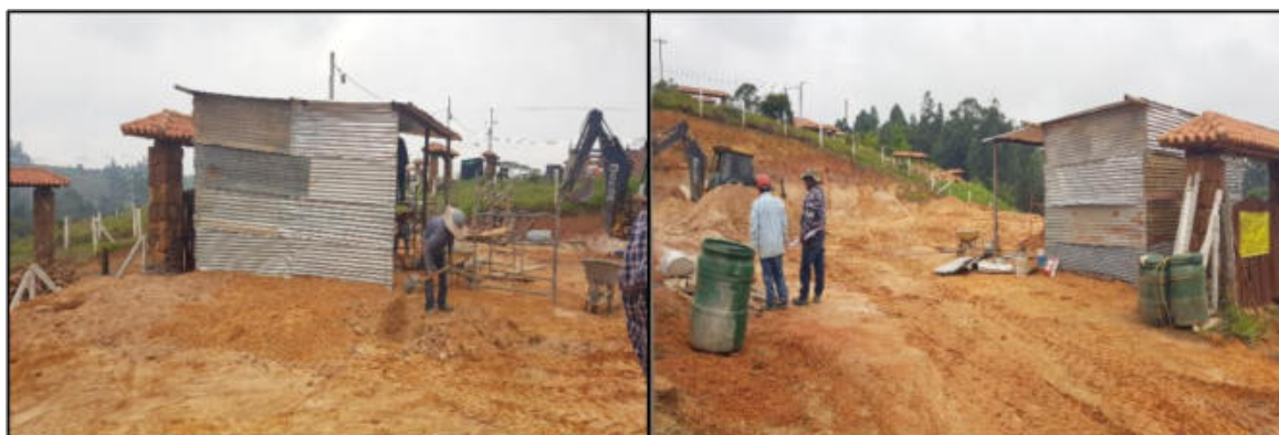
Ilustración 11. Construcción del campamento y la letrina casa 221 Fuente: Propia
