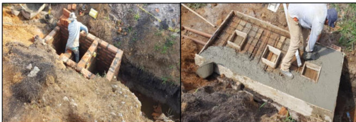
Ilustración 73. Ejecución PTAR casa 294 Fuente: Propia
