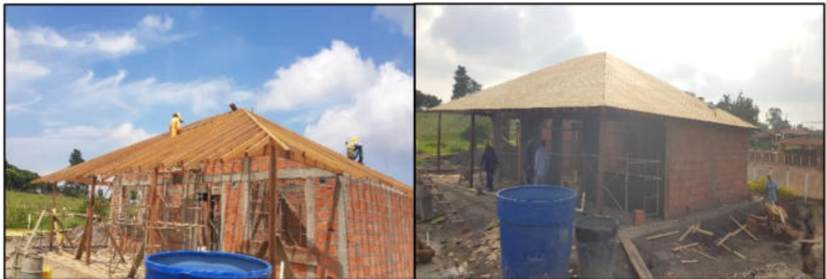
Ilustración 45. Estructura en madera y machihembrado casa 51 Fuente: Propia
