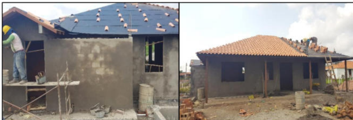
Ilustración 49. Extendida de la tela y entejada casa 51 Fuente: Propia
