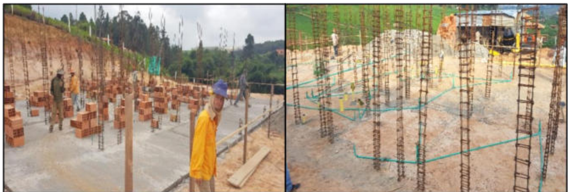
Ilustración 30. Fundida placa de contrapiso casa 221 Fuente: Propia
