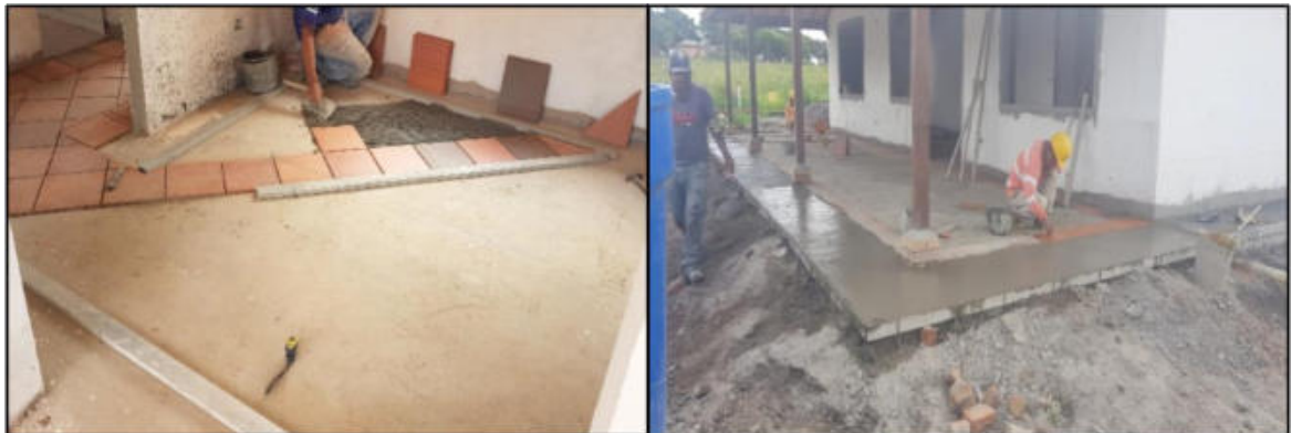
Ilustración 60. Enchapes piso 51 Fuente: Propia
