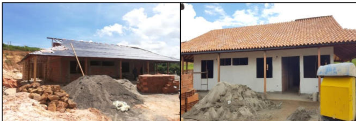
Ilustración 50. Extendida de la tela y entejada casa 294 Fuente: Propia
