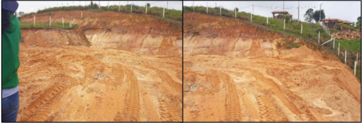
Ilustración 7. Descapote y replanteo casa 221 Fuente: Propia
