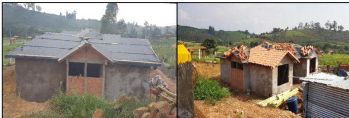
Ilustración 49. Extendida de la tela y entejada casa 51 Fuente: Propia
