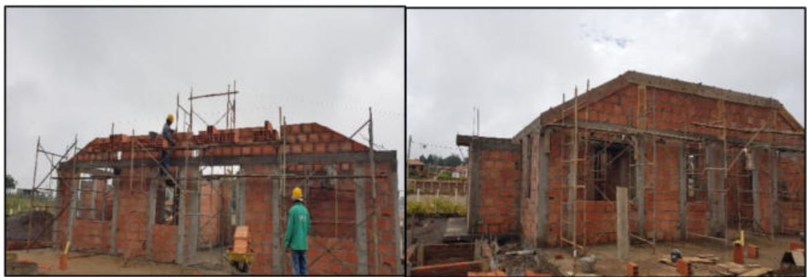
Ilustración 41. Cuchillas y viga cinta casa 51 Fuente: Propia
