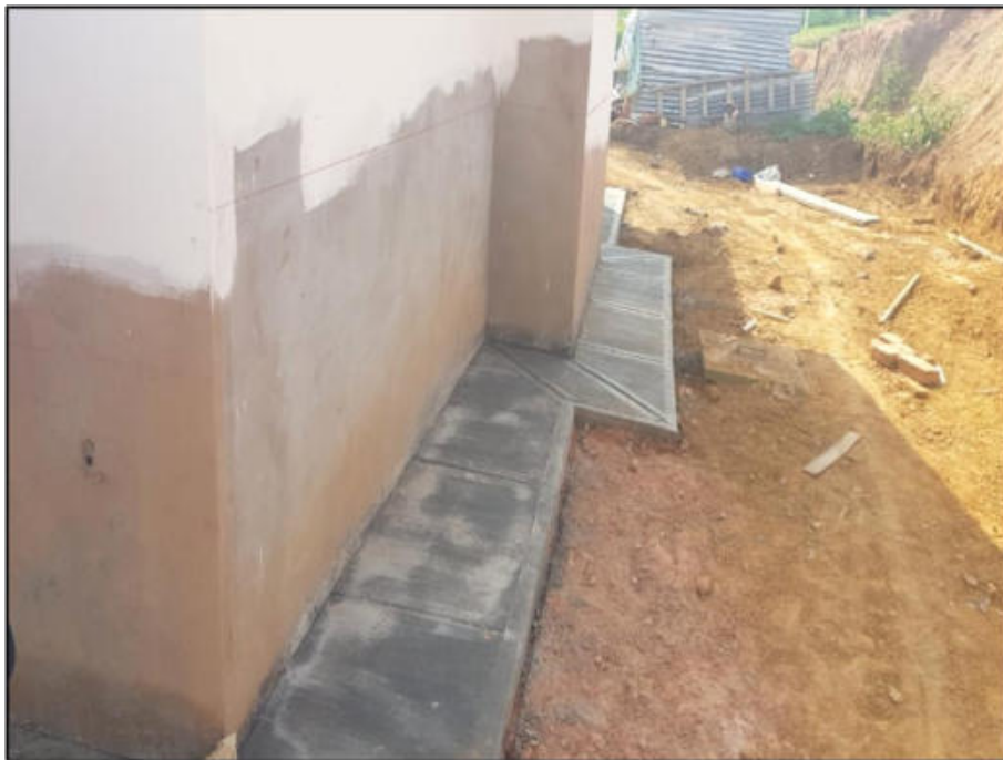
Ilustración 67. Fundida de andenes casa 294 Fuente: Propia
