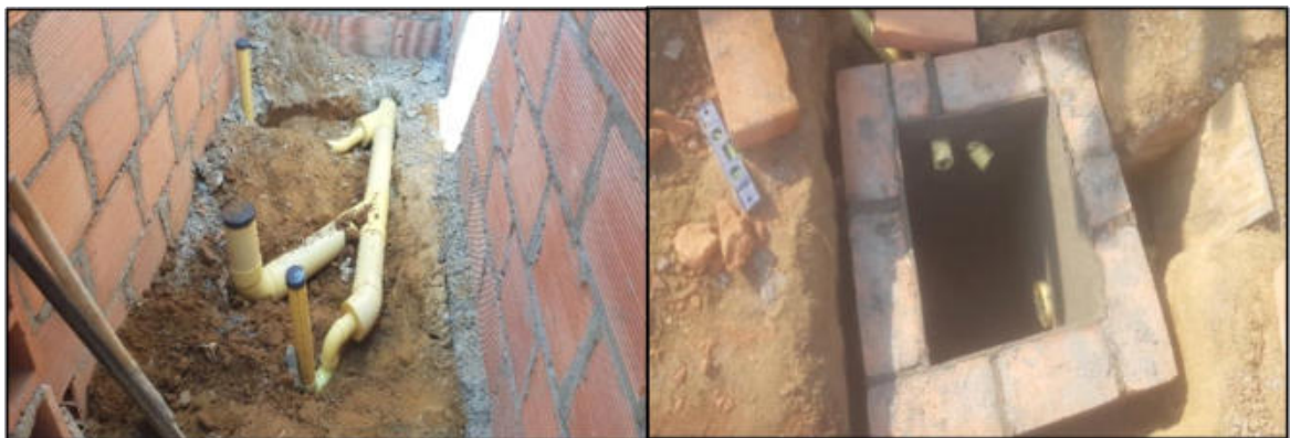
Ilustración 22. Instalación tubería sanitaria casa 294 Fuente: Propia
