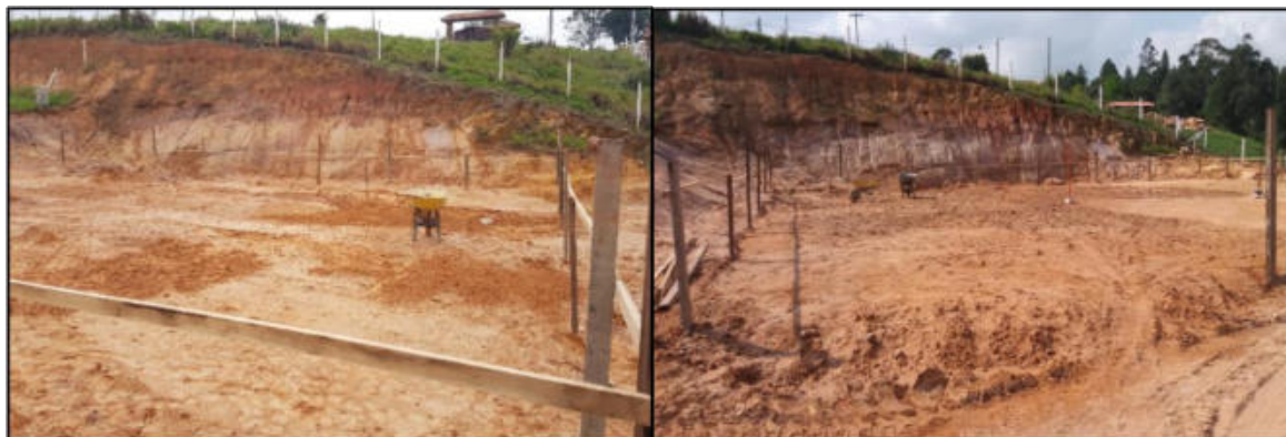
Ilustración 10. Demarcación y nivelación casa 221 Fuente: Propia
