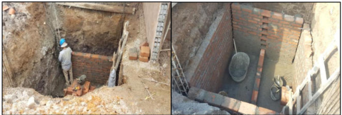
Ilustración 68. Tanque subterráneo casa 51 Fuente: Propia
