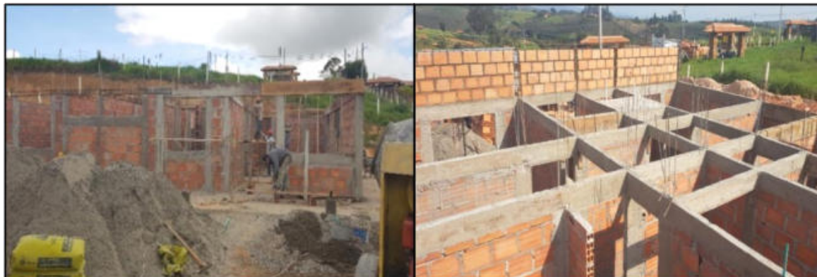
Ilustración 39. Columnetas y viga corona casa 221 Fuente: Propia
