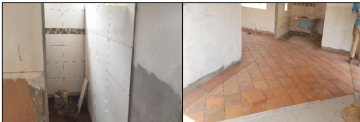
Ilustración 61. Enchapes paredes y piso casa 294
